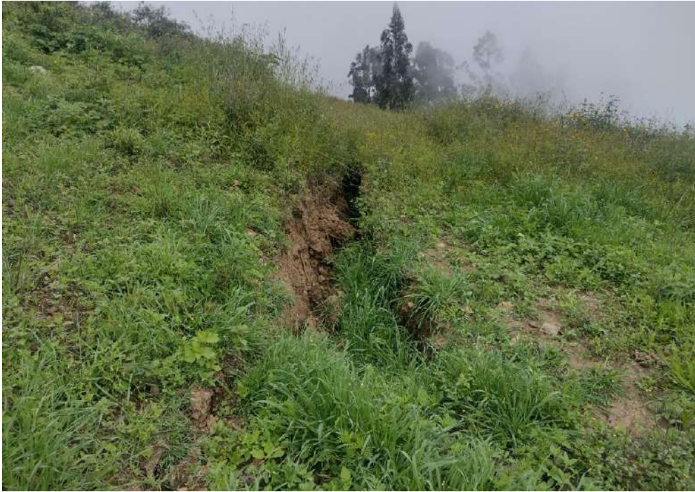
Gráfico 24: Agrietamiento del suelo en el sector de Quechuas
