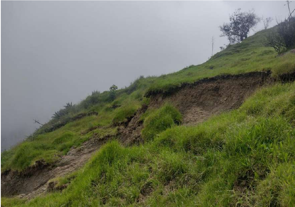
Gráfico 22: Deslizamiento en la zona de Quechua
