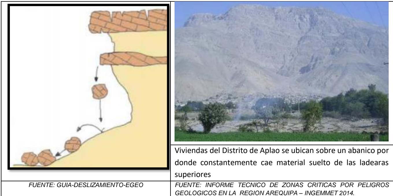
Imagen N° 12: Desprendimiento de rocas
