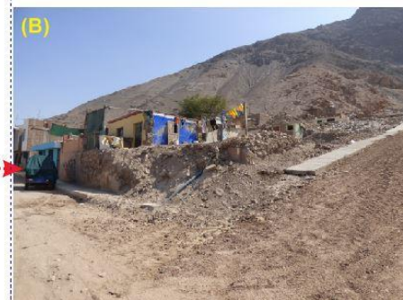
Imagen 67: (A) Se aprecia el estrechamiento de la calle al existir una vivienda que fue un obstáculo para el paso del huico. (B) Vivienda destruida por el flujo de detritos del 07 de febrero del 2019.
