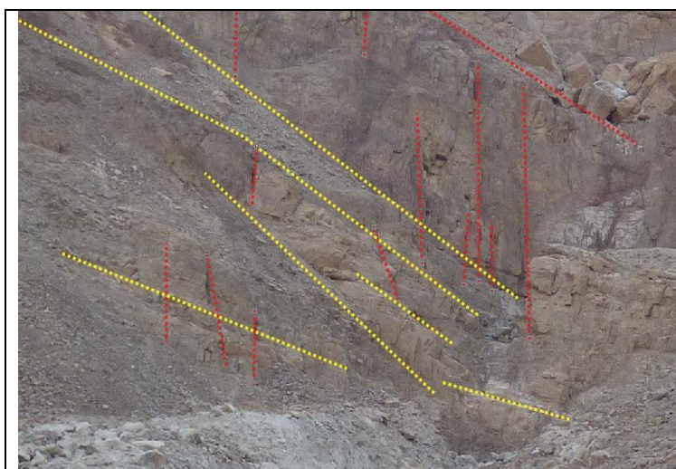
Imagen 29. Se muestran los planos de estratificación en las areniscas (línea amarilla) y el sistema de fracturamiento oblicuo a estas (líneas rojas).
