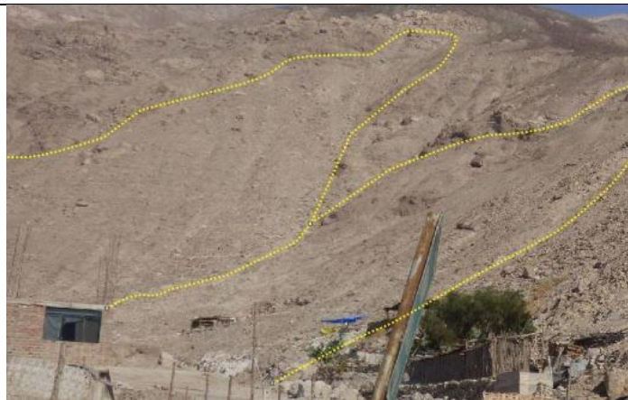
Imagen 35. Evidencias de movimientos en masa antiguos, generalmente por gravedad (con poca influencia de agua de lluvia).
