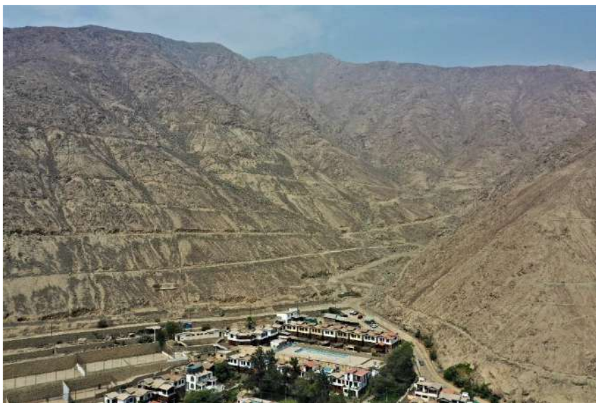
Fotografía 7. Vista panorámica de los depósitos de flujos de detritos ubicado al sureste de las Manzanas I y H de la urbanización El Cuadro. Coordenadas UTM: 304413.00 / 8673455.00, Zona 18.
