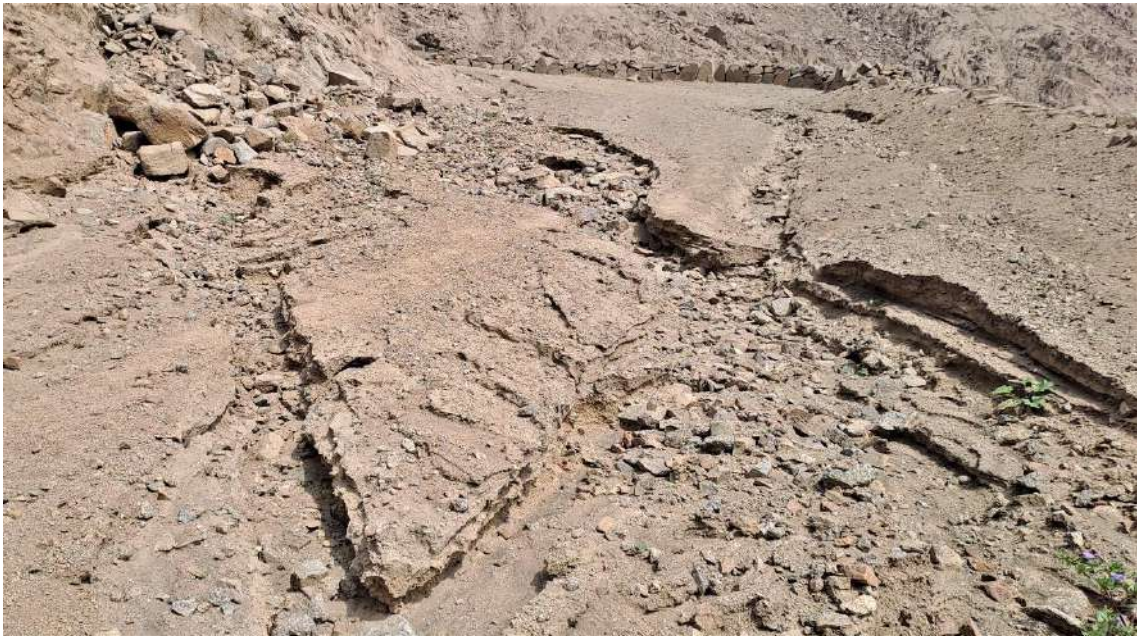
Fotografía 9. Rastros de generación de flujos de detritos durante el ciclón Yacu ubicado al noreste de la manzana I de la urbanización El Cuadro. Coordenadas UTM: 304513.00 / 8673148.00, Zona 18.
