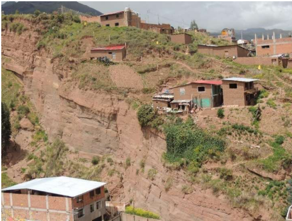
Vista de construcciones cercanas al corte de talud.
