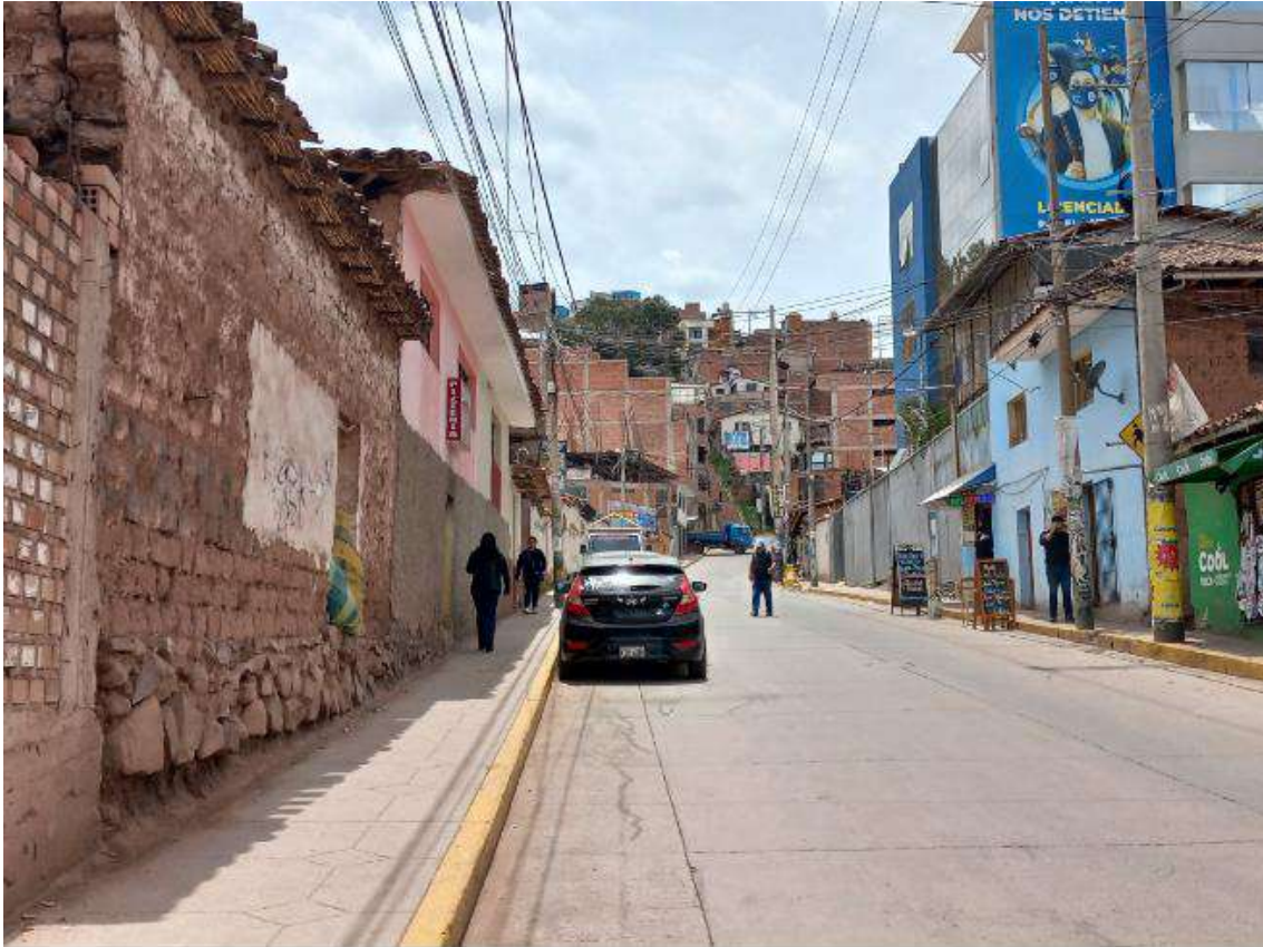
Foto N°1 Vista de viviendas
