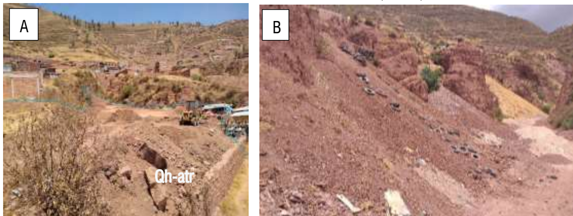
FOTOGRAFÍA 7: FOTOGRAFÍA A: DEPÓSITO ANTRÓPICOS/MATERIAL DE DESMONTE, FOTOGRAFÍA B: VISTA DE DETALLE DE DEPÓSITO RECIENTES VERTIDOS EN LA LADERA DE LA QUEBRADA.
