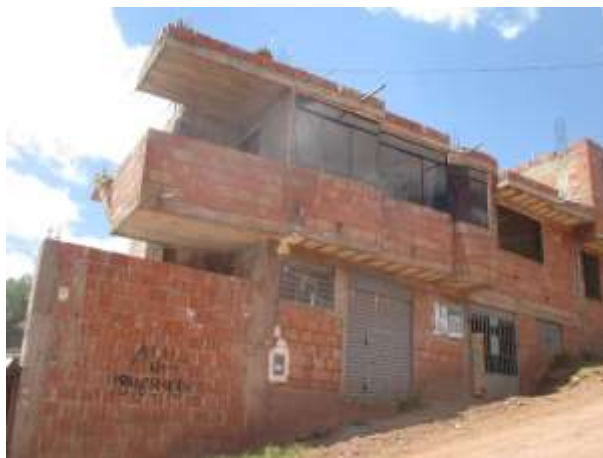
FOTOGRAFÍA 19: EDIFICACIONES DE CONCRETO ARMADO, UBICADAS EN LA APV. HÉROES DE SAN ANTONIO MANZANA A
