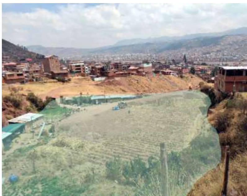
FOTOGRAFÍA 11: VISTA DE MATERIALES DE RELLENO CON PROFUNDIDADES DE 2M A 3M
