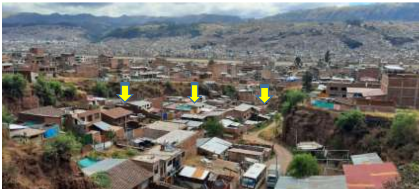
FOTOGRAFÍA 14: POBLACIÓN ASENTADA EN CAUCE DE QUEBRADAS QUE FUERON RELLENADAS CON DESMONTE
