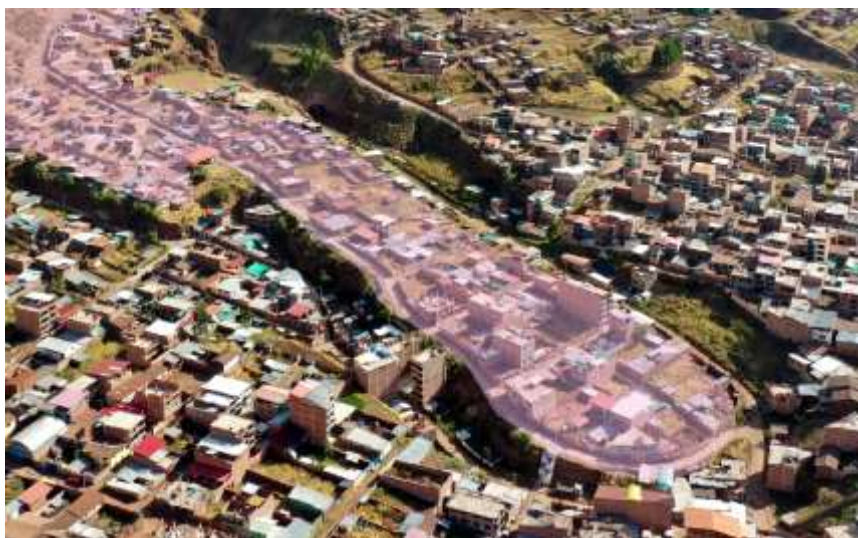
FOTOGRAFÍA 15: ZONAS SIN RELLENO, UBICADAS EN PLATAFORMAS ELEVADAS DE LA FORMACIÓN SAN SEBASTIÁN.
