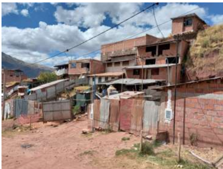
FOTOGRAFÍA 2: REGISTRO FOTOGRÁFICO DE LAS VIVIENDAS DE MATERIAL DE CONCRETO ARMADO, LADRILLO Y ADOBE, QUE CORRESPONDIENTES A LA. A.P.V. NACIÓN SAN ANTONIO.
