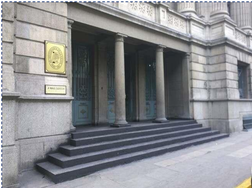
Vista frontal de la sede Palacio
