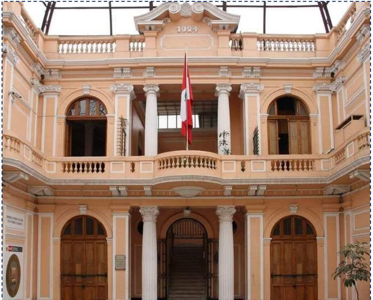
Figura N°5 Vista lateral de la sede Ex Correo (pasaje Piura)
