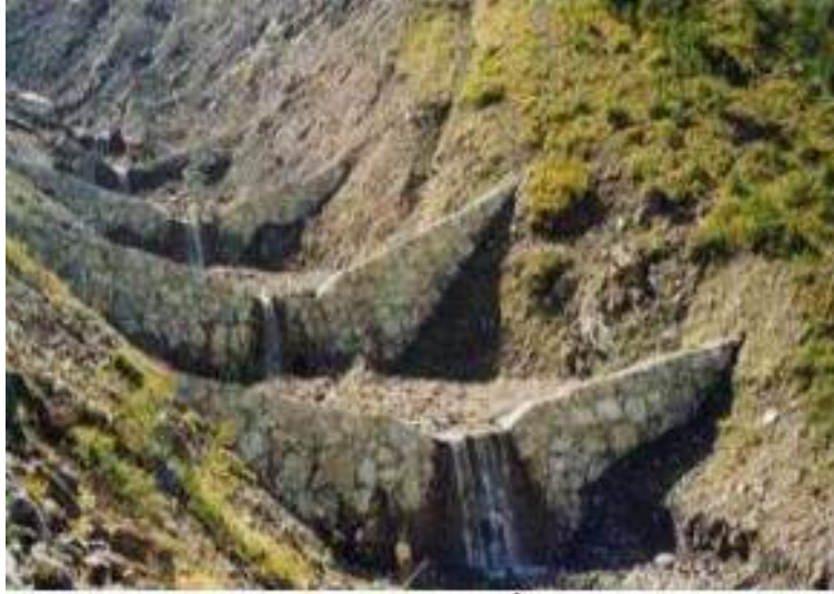
Figura 51. Ejemplo de diques escalonado de hormigón.
