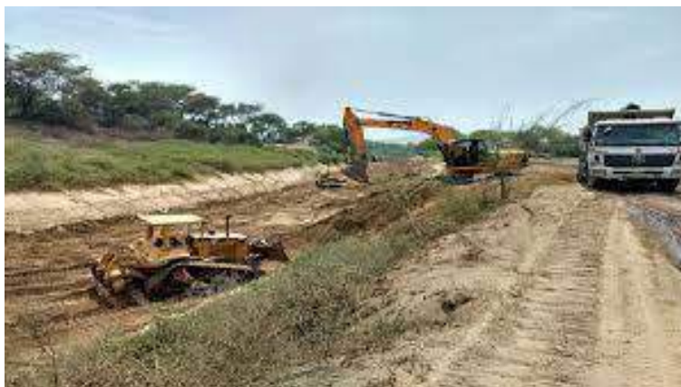
Figura 50. Ejemplo de obras de canalización.
