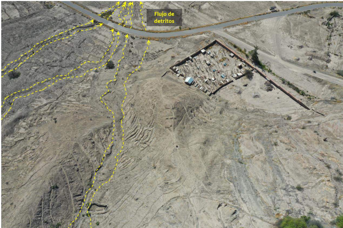
Figura 29. Se observa las direcciones del flujo de detritos en la ladera del cerro Joto Jahuana. Afecta la vía Ayo – Andagua.
