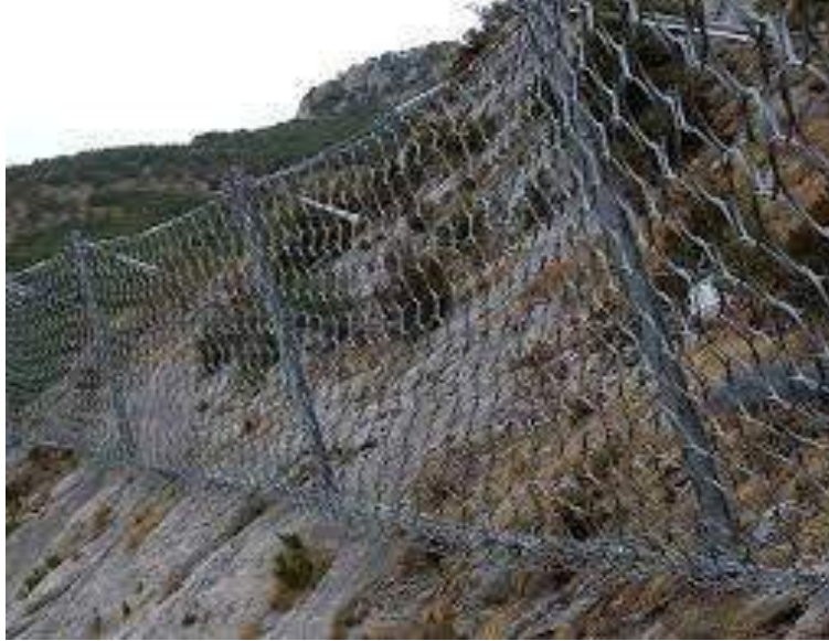
Figura 49. Ejemplo de barreras dinámicas para caídas de rocas.
