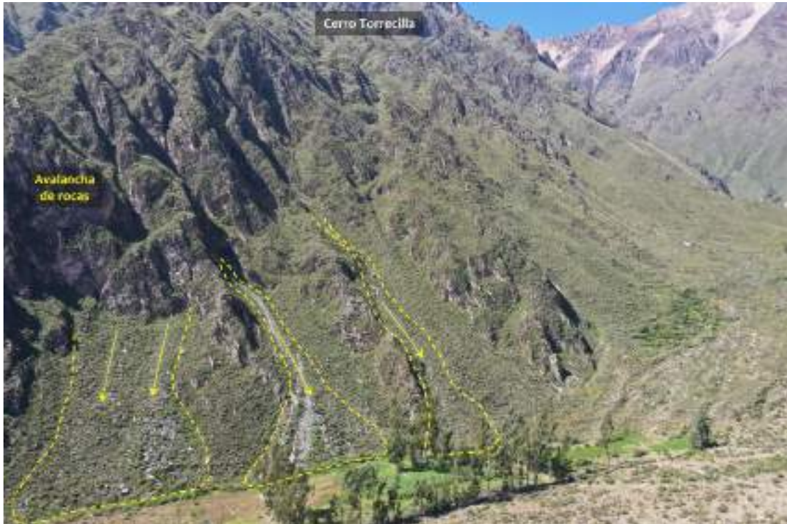
Figura 44. La figura muestra avalanchas de rocas en el cerro Torrecilla, ubicada al norte del anexo Subna (marcadas con líneas entrecortadas amarillas).
