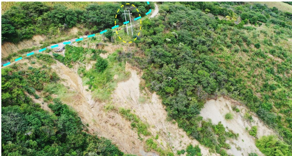
Fotografía 8. Detalle de la parte alta deslizamiento-flujo 2, donde se aprecia un canal de regadío (en línea celeste), postes de fluido eléctrico (resaltados en línea amarilla) que podrían ser afectados de continuar el movimiento.
