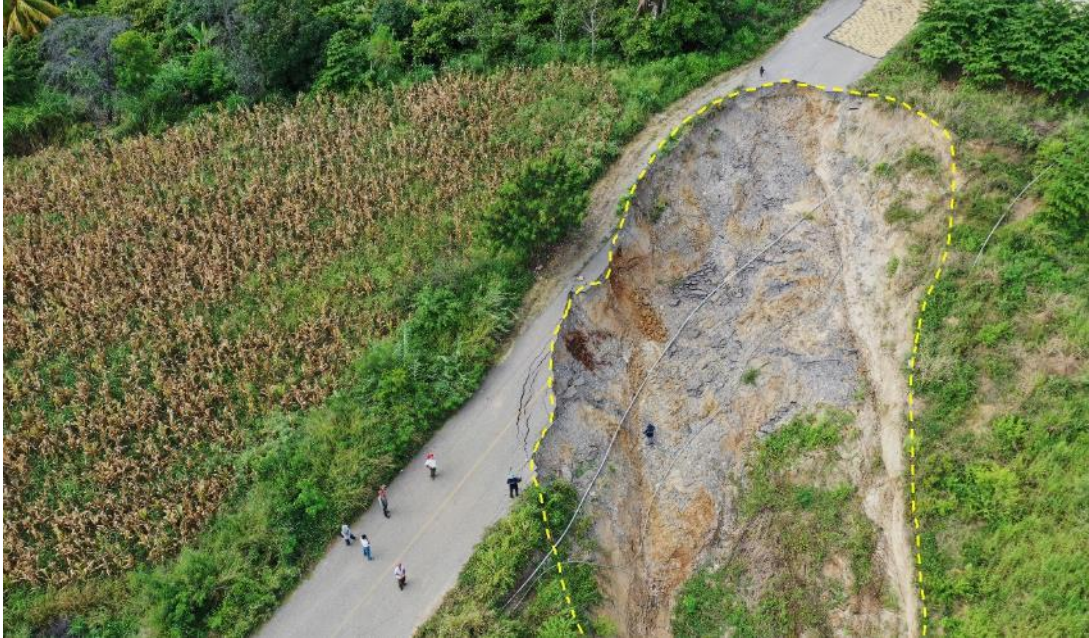
Figura 19. Vista de la parte alta del deslizamiento-flujo 1.
