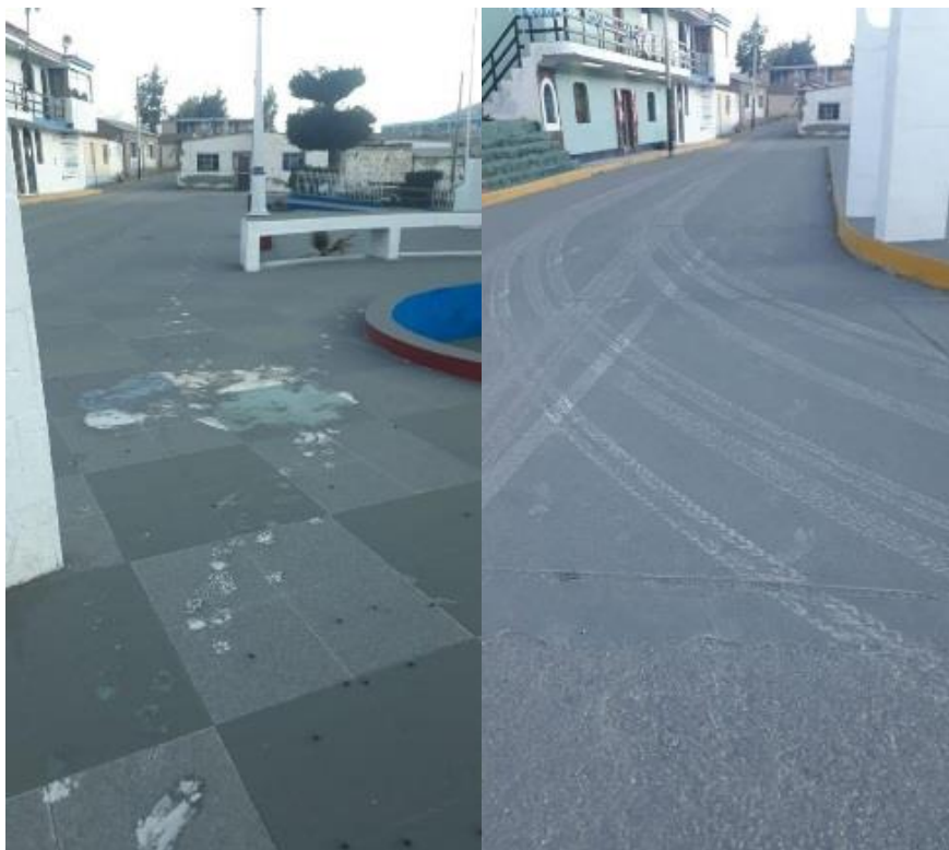
Figura 20. Afectación por caída de ceniza en Chojata por la explosión del 6 de agosto.
