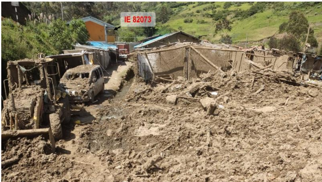
Figura 12. Daños en la localidad de La Victoria en marzo del 2023, se aprecia la IE 82073 en la parte posterior.
