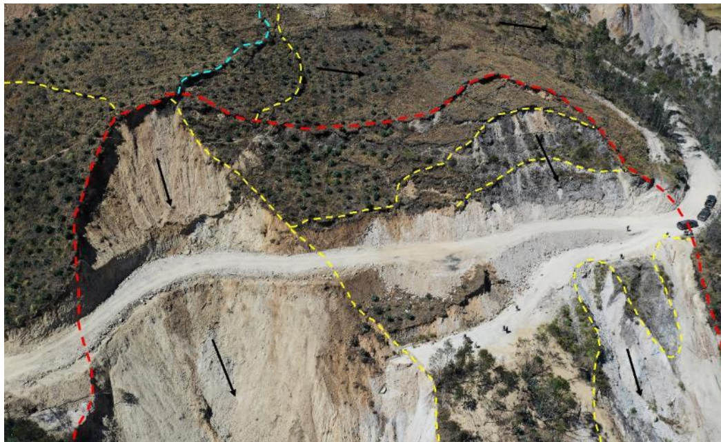
Figura 14. Vista de la parte alta del movimiento complejo La Victoria, se aprecia la corona principal del movimiento (en rojo) además de escarpes secundarios (en amarillo) y la corona de un deslizamiento (en celeste) que tiene una dirección de movimiento divergente.
