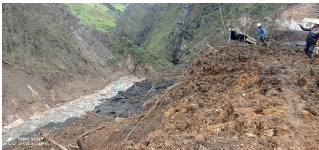
Fotografía 3. Parte final del movimiento complejo La Victoria, en el margen del río Perejil en marzo del 2023.
