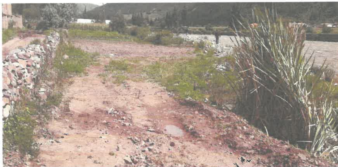
Fotografía 21. Sector susceptible a inundaciones en la margen izquierda del río Vilcanota en el sector de Juchuy pampa (UTM: 221572E; 8475897N)
