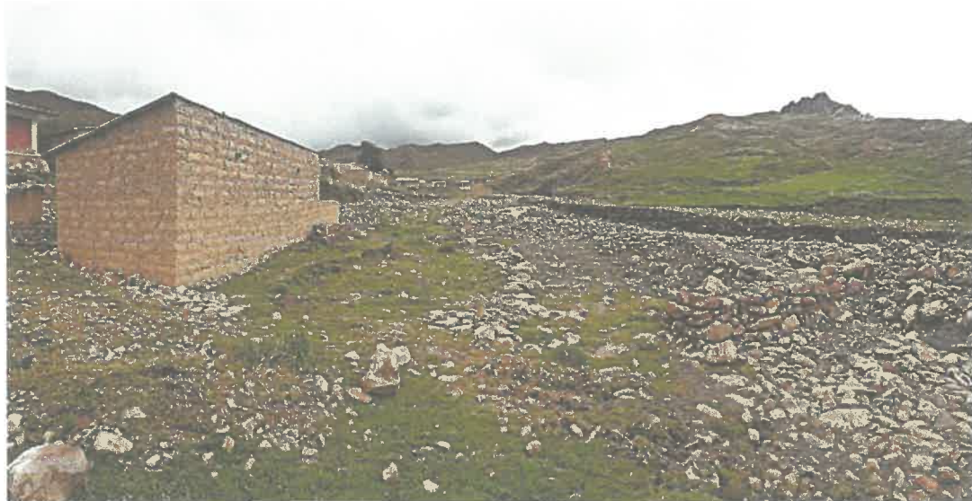
Fotografía 4. Flujo de detritos en la margen derecha del rio Huiscamayo (UTM: 236008E; 8472461N)
