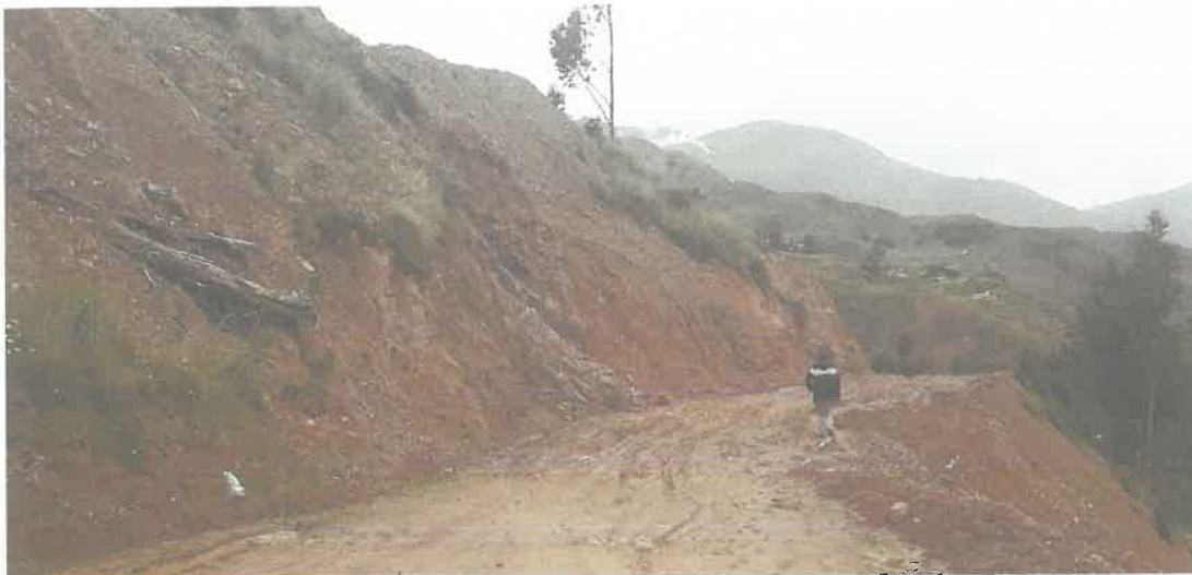
Fotografía 6. Zona inestable constantes deslizamientos en el sector de Llama Central (UTM: 232331E; 8472741N)
