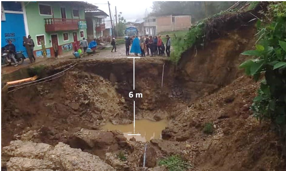
Figura 9. Agrietamientos (líneas amarillas discontinuas), con longitudes de 1m a 5 m, ubicados en la parte superior del macizo rocoso.
