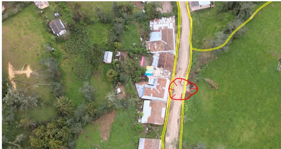
Figura 11. Canal de drenaje de escorrentía (líneas amarillas), sin revestimiento.
