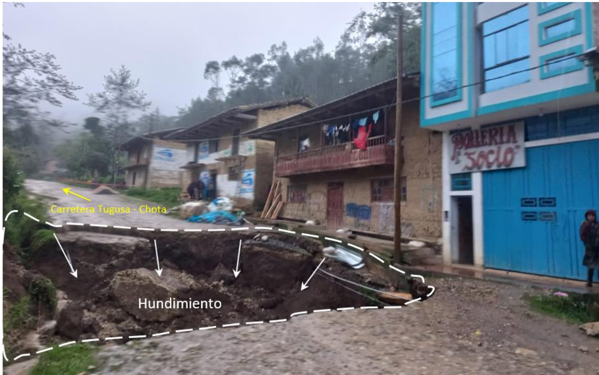
Figura 6. Dolina ubicada a 660 m (líneas discontinuas color blanco), al noroeste del sector evaluado, el agua ingresa de manera continua. Coordenadas UTM, WGS-84, 17S. Norte: 9288661 y Este: 754051.
