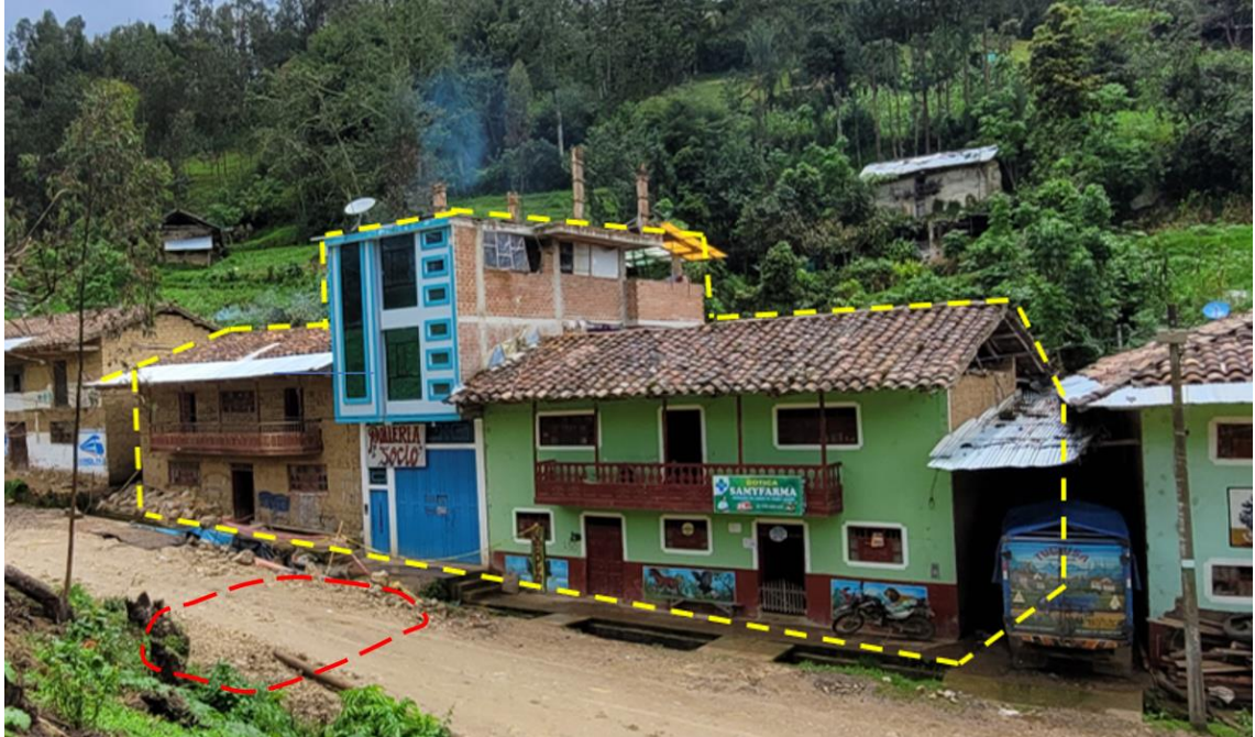
Figura 12. Viviendas afectadas directamente por el hundimiento (líneas discontinuas amarillas) y perímetro del hundimiento (líneas discontinuas color rojo).
