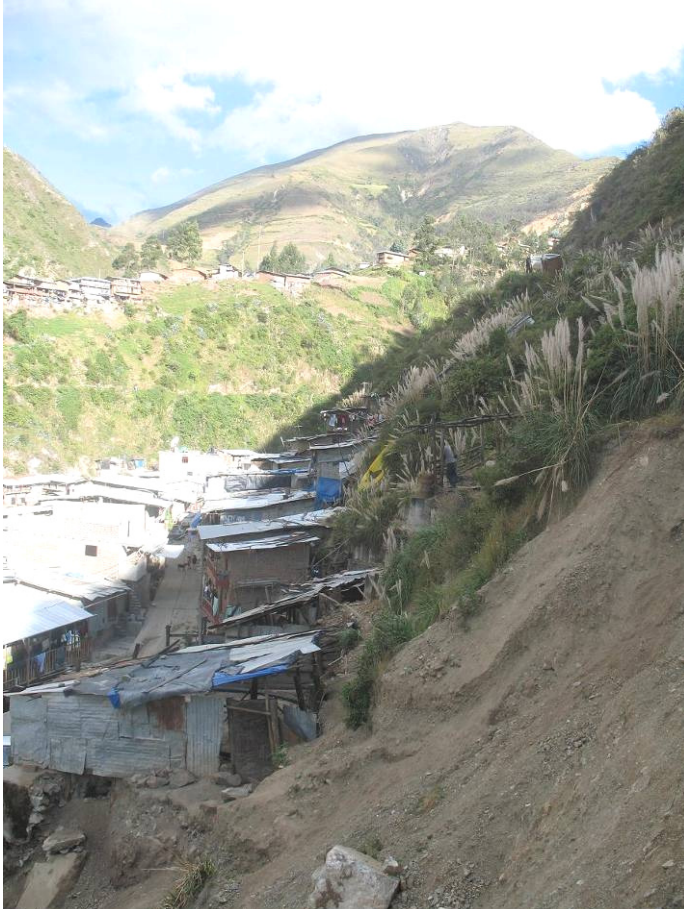
Foto 9: Pendiente del terreno del sector donde ocurrió el derrumbe. Supera los 40°.
