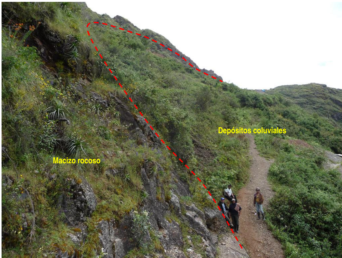
Foto N° 13: Contacto de los depósitos coluviales con macizo.
