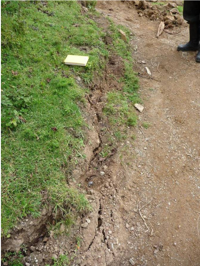
Foto N° 14: Se observa agrietamiento leve en los depósitos coluviales.
