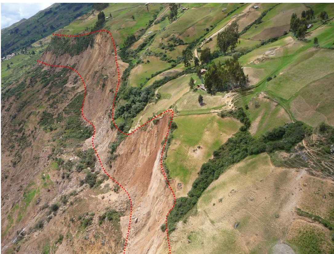
Foto 19: Escarpa del deslizamiento Collona.
