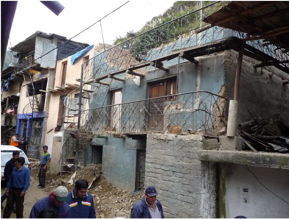
Foto 8: Viviendas destruidas por el derrumbe de Retamas.
