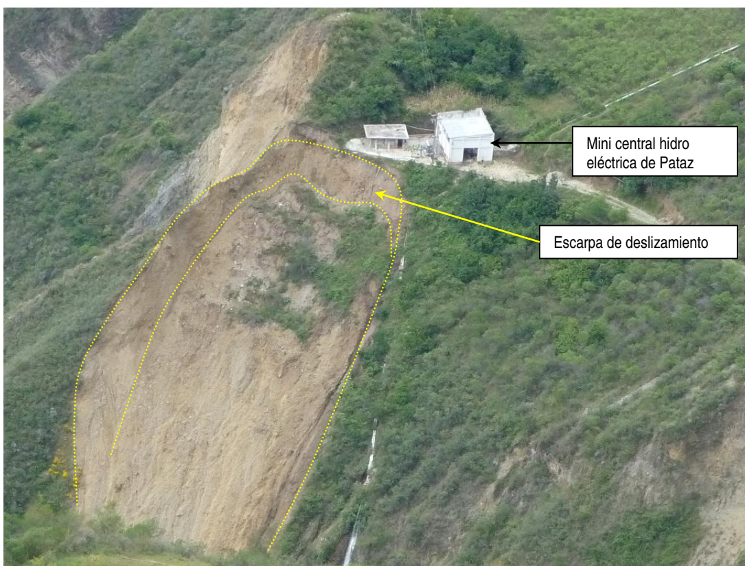
Foto N° 17: Minicentral hidroeléctrica que abastece de energía al poblado de Pataz ubicada en la cresta del deslizamiento activo.
