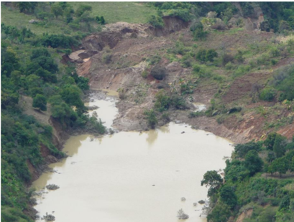
Foto N° 2: Laguna formada por el deslizamiento Chamanacucho. Los pobladores de la zona escarbaron una zanja para vaciar el agua.
