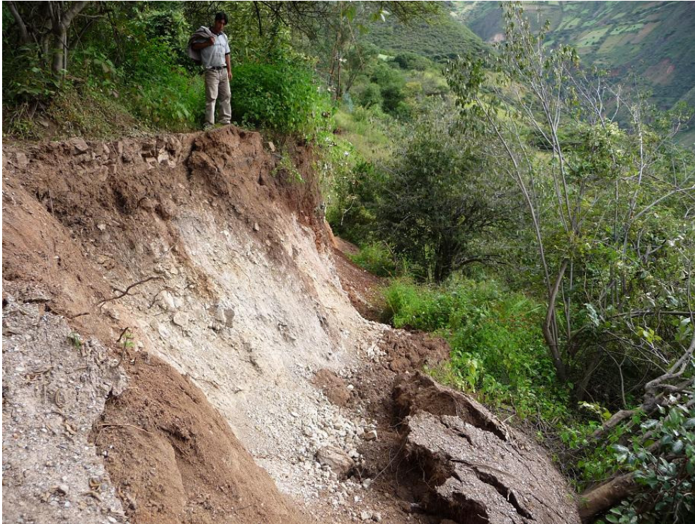
Foto N° 3: Parte de la escarpa del deslizamiento Chamanacucho.
