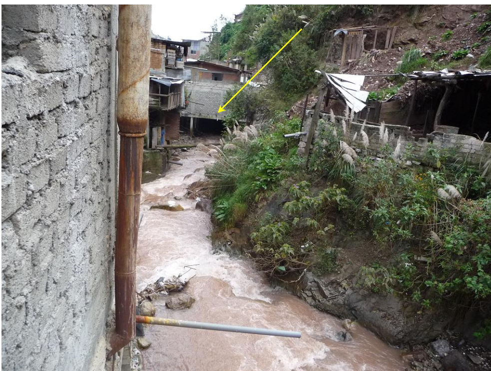
Foto 10: Se observa las viviendas construidas sobre el cauce de la quebrada.
