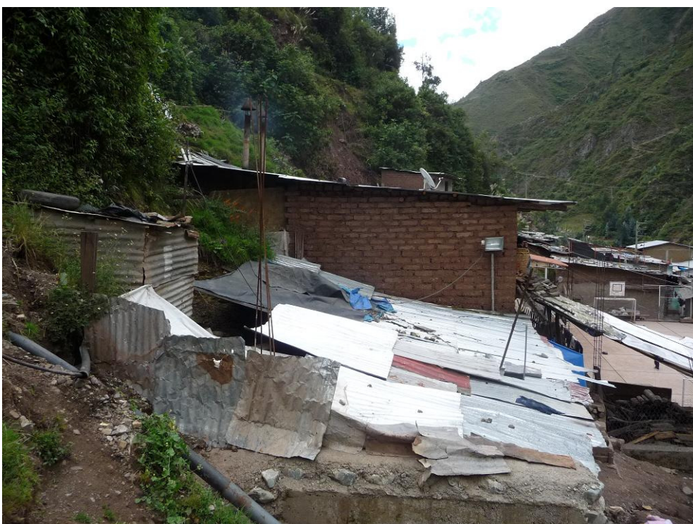
Foto 11: Viviendas construidas pegadas al talud del cerro de fuerte pendiente: Sector Codiciada.
