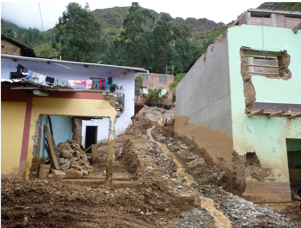
Foto N° 16: Se observa las viviendas afectadas por el flujo y el canal de concreto de 0.50 m.
