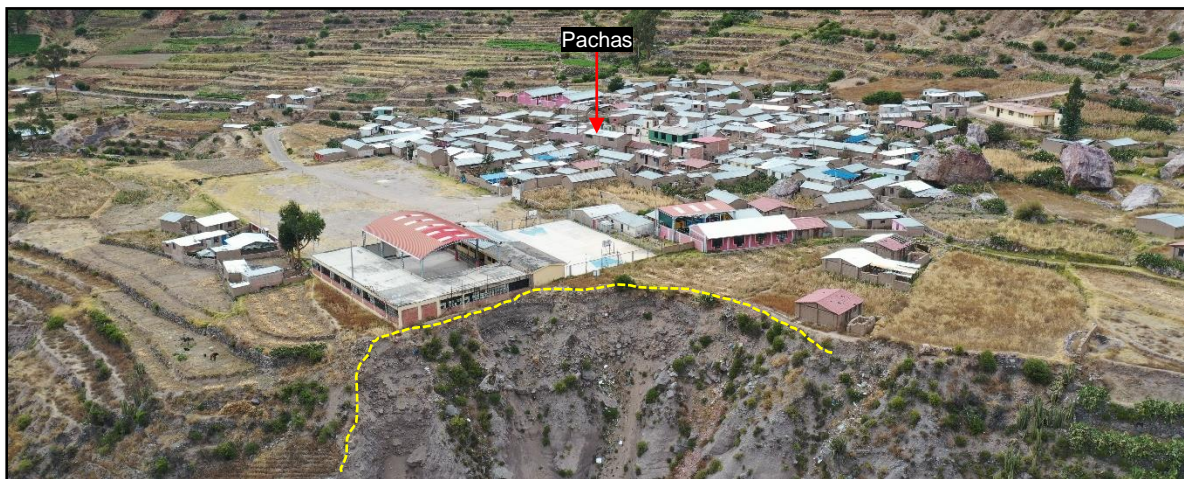
Figura 6. Zona de derrumbes en el centro poblado de Santiago de Pachas
