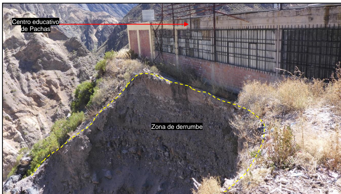
Figura 8. Centro de estudio de Pachas, viene siendo afectado por derrumbe.
