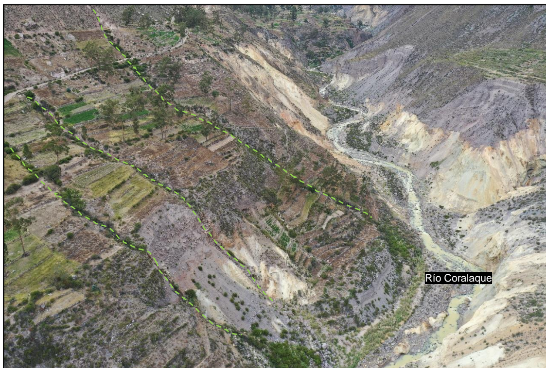
Figura 12. Procesos de erosión de ladera en (cárcava).
