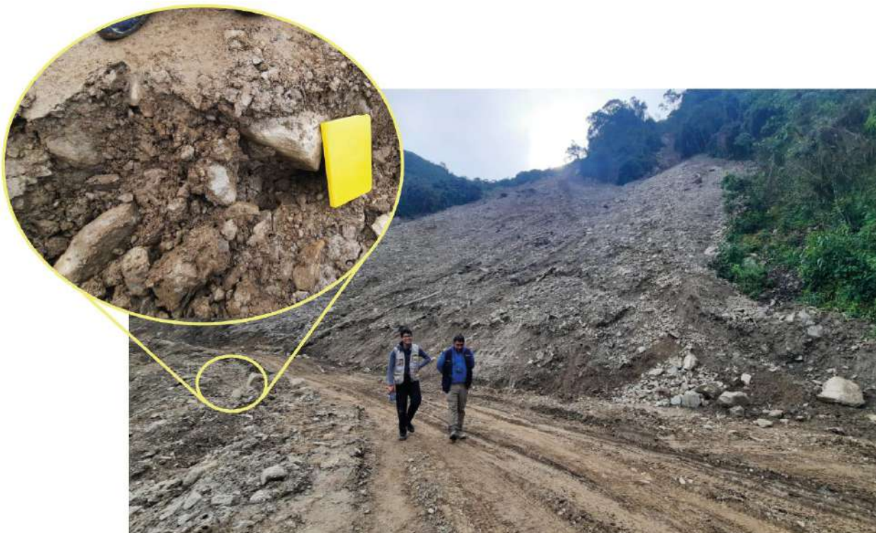
Figura 5. Depósitos coluvio deluviales, movilizados por la activación del deslizamiento en el sector Sillapata – Cconchuaycco, Km 148+120 de la vía CU-100. Coordenadas UTM 18 L E: 693716, S: 8519540 y Elevación: 2390 m.
