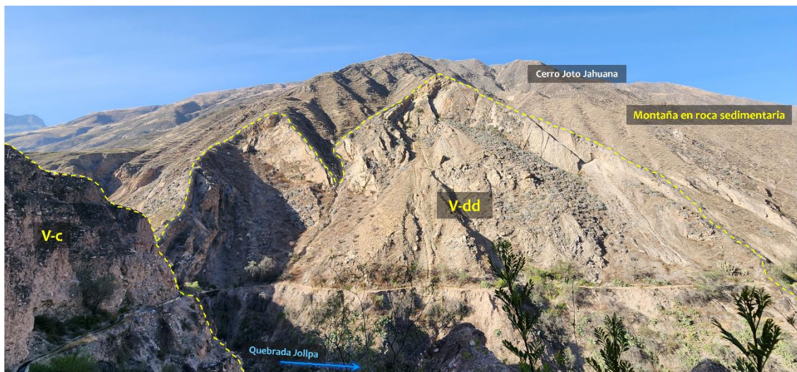
Figura 18. Se observa la Montaña en roca sedimentaria (RM-rs) y la Vertiente con depósito de deslizamiento (V-dd) en la margen izquierda de la quebrada Jollpa.
