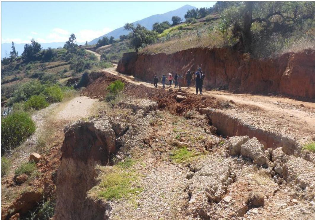
**Fotografía 3.** Escarpa del deslizamiento reactivado, que afectó tramo carretero que conduce a pueblos aledaños.
