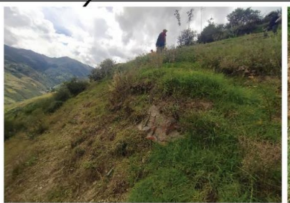
Escarpa del deslizamiento Ds_1
