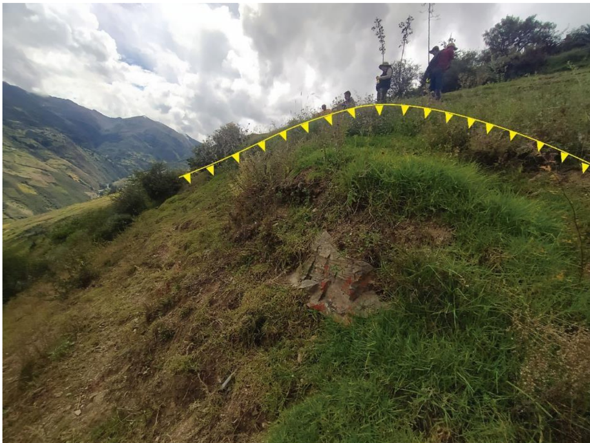
Figura 12. Muestra el escarpe del deslizamiento rotacional suspendido Ds_1, ubicado por debajo del C.P. Pueblo Libre.
