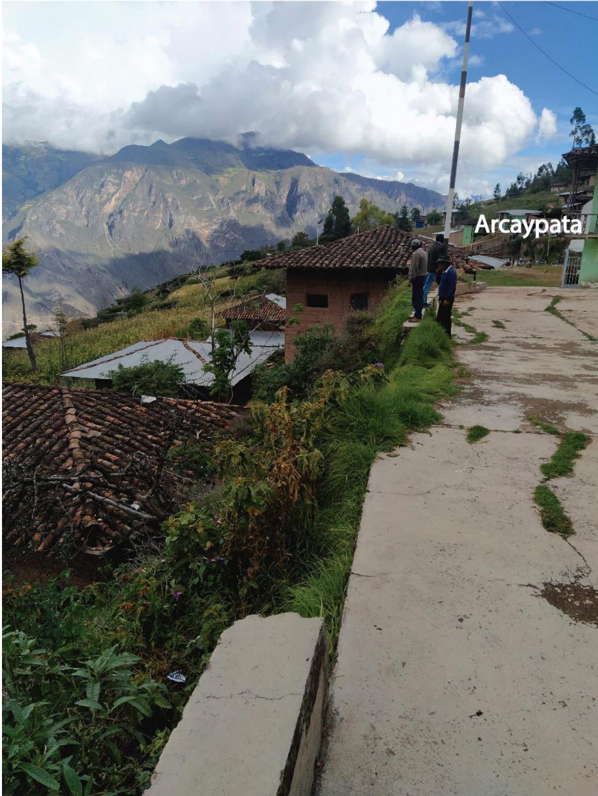
Figura 19. Posibles evidencias de reactivaciones que llegan a Arcaypata, caída de muros de contención cercano a la plaza e iglesia del caserío.
