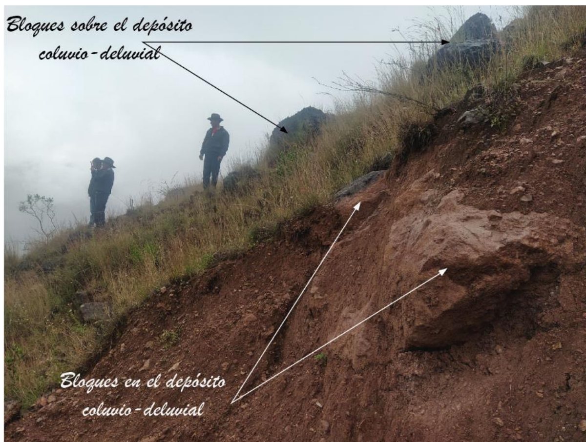
Figura 5. Depósito coluvio-deluvial en el sector Las Habas, obsérvese los bloques dentro del cuerpo del deslizamiento.
