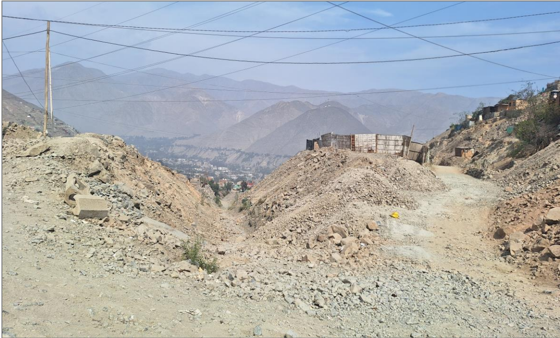
Fotografía 6. Parte media de la quebrada Santa María, en ambas márgenes se observa material disponible, fácilmente erosionable ante la ocurrencia de un flujo de detritos.
