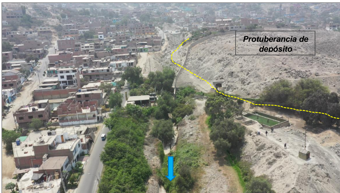
Figura 5. Protuberancia de depósito consolidado, dispuesto a la margen izquierda de la quebrada Santa María, sirve como barrera ante una posible afectación por flujo de detritos al terreno de Yanacoto II.
