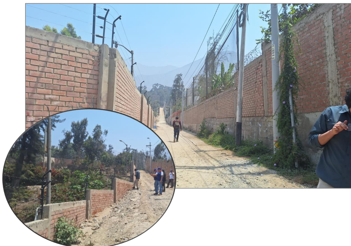
Figura 6. Vista del Pasaje S/N, por el cual discurrió un flujo a partir de las lluvias registradas en la zona de estudio, así mimos, se observa que el muro que delimita Yanacoto, tiene aproximada 50 cm de altura, por donde fácilmente puede ingresar flujos posteriores.
