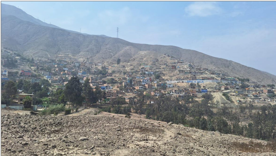
Fotografía 5. Vista al noroeste de los locales de Yanacoto I y II, laderas de pendientes altas, urbanizadas; con muchas probabilidades de producirse caída de rocas, derrumbes, y erosión por escorrentía pluvial.
