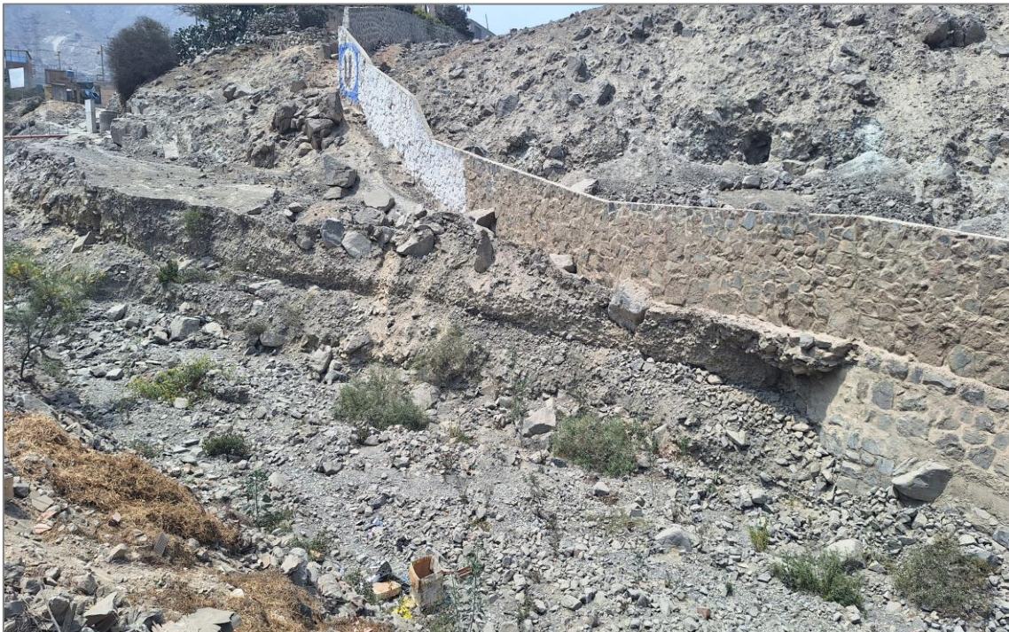
Fotografía 7. Vista de material transportado por flujos antiguos, alcanza una altura aproximada de 3 m, que posteriormente fue erosionado, dejando expuesto el muro que delimita Yanacoto II.
