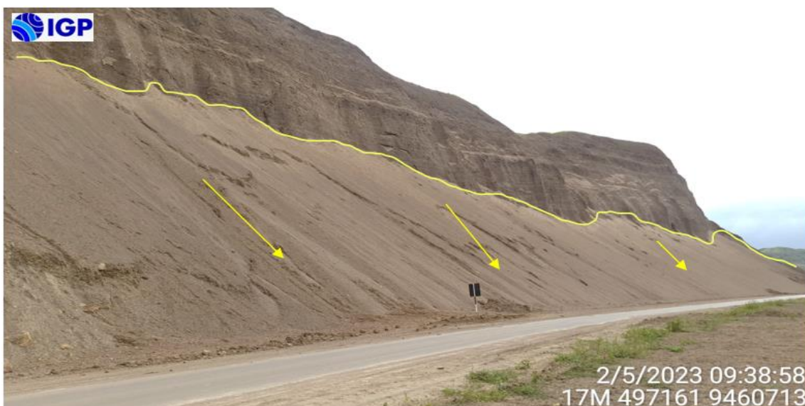
Figura 36.- Depósito coluvial conformado por materiales sueltos (arenas, limos y arcillas) que han sido dispuestos sobre la ladera del cerro Cinchado y pate de la vía de acceso asfaltada denominada la Costanera
