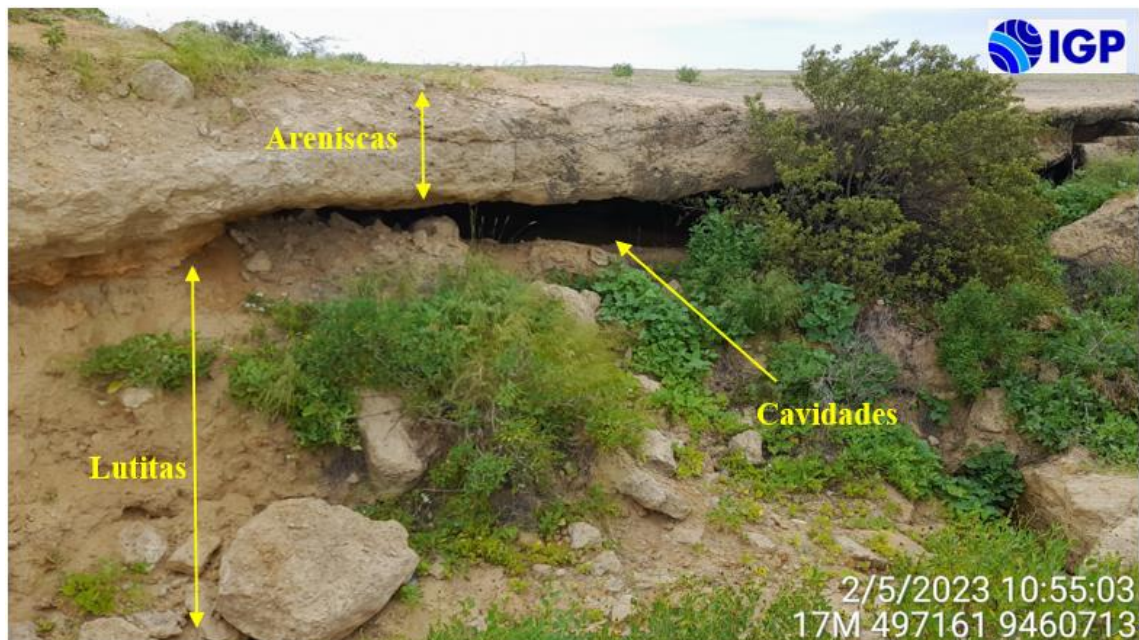
Figura 40.- Rocas areniscas de la Formación Chira sobreyaciendo a las rocas lutitas erosionadas por el agua de escorrentía en el sector Tablazo del C.P. San Felipe que se presentan fracturadas en las inmediaciones de los taludes y susceptibles a desprendimientos
