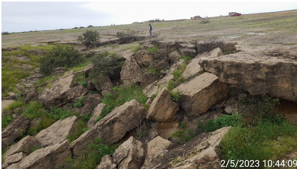
Figura 17.- Unidad geomorfológica vertiente coluvio – deluvial conformada por materiales sueltos susceptibles a la ocurrencia de caída de rocas que fue reconocido en las nacientes de las quebradas Paredones y Arellano
