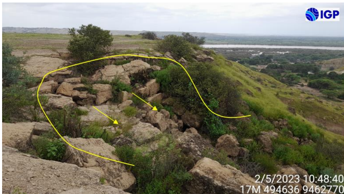
Figura 43.- Depósito coluvial (enmarcado en polígono amarillo) conformado por bloques de roca arenisca fracturada e inestable que aflora en las nacientes de la quebrada Paredones
