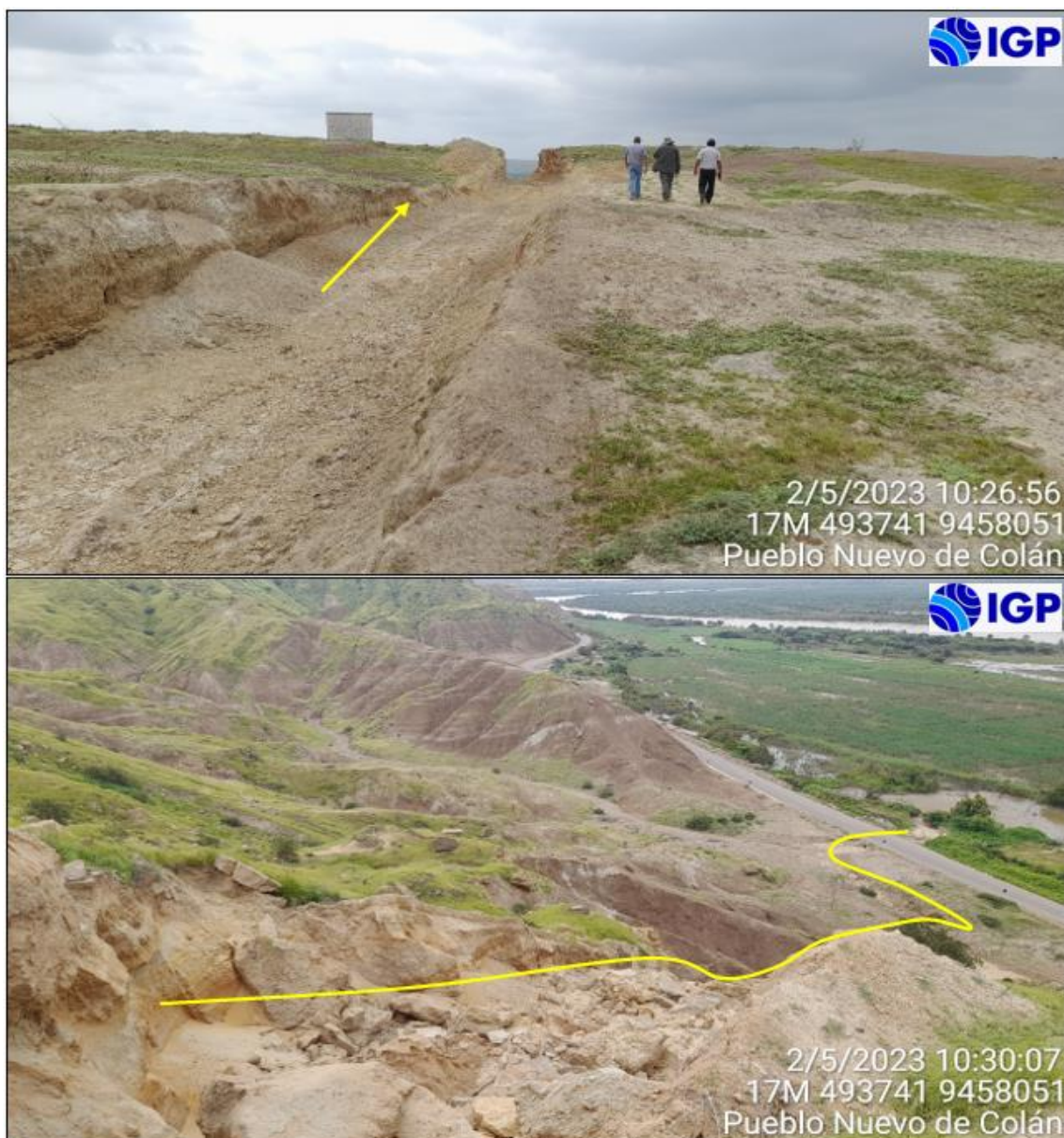
Figura 14.- Canal de coronación situado en el sector Tablazo del C.P. San Felipe que conforma la unidad geomorfológica cauce aluvial. La imagen superior muestra el canal excavado con la finalidad de drenar las aguas de escorrentía hacia la parte baja para evitar la activación de las quebradas Paredones y Arellano, mientras que, la imagen inferior muestra la erosión del flujo de agua sobre la loma y generación de flujos de lodo que se desplazan hacia la vía Costanera
