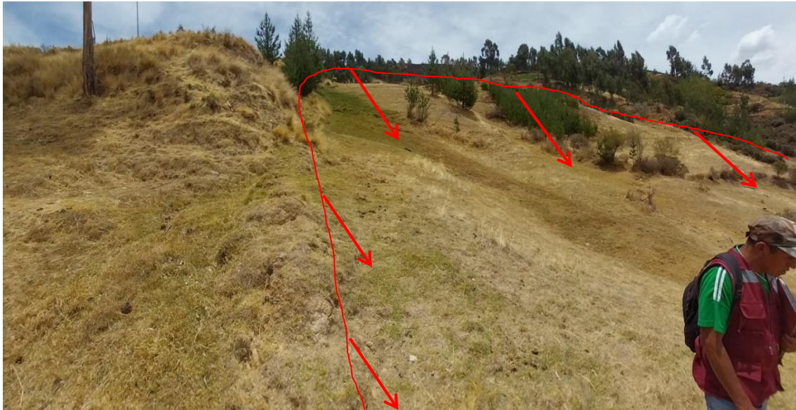
Foto 5 Cabecera de deslizamiento activo, se puede observar el contacto entre afloramiento de rocas y material que se viene deslizando, "sector superior Callacunca"
