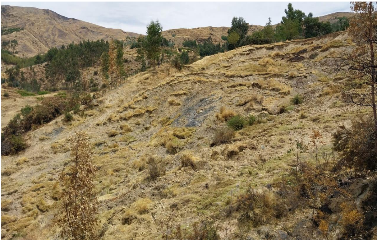
Zona muy inestable ubicada en la parte media baja de la cuenca Callacunca (UTM: 229870E/8469410N), se pueden observar escarpas de deslizamientos muy activos que afectan a terrenos.
