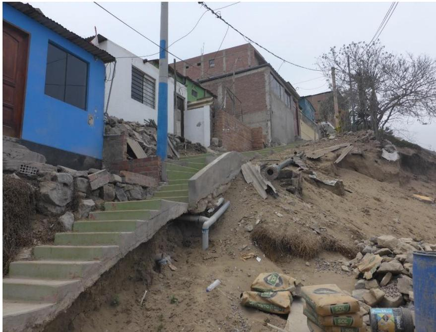
**Fotografía 8.** Viviendas asentadas sobre pircas ubicadas en depósitos de arenas inconsolidados. Coordenadas UTM (WGS 84): 275358 E, 8670785 N.
