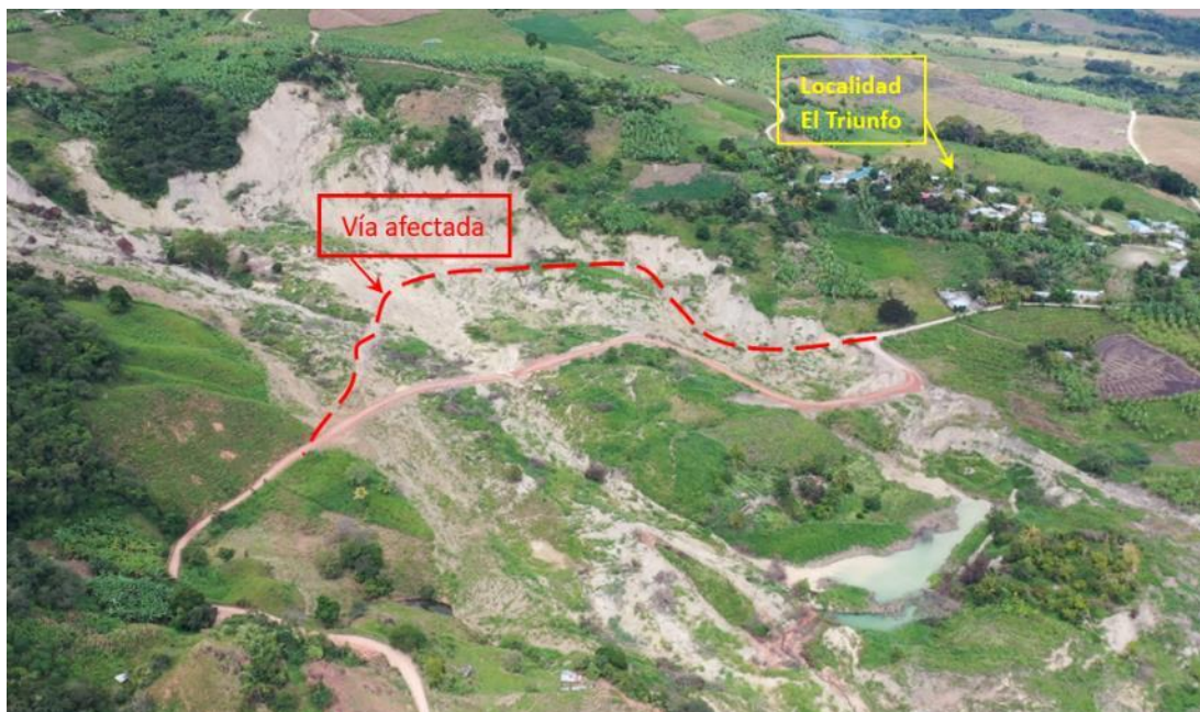
Figura 9. Vía vecinal afirmada (líneas rojas discontinuas), afectada en tramo de 410 metros. Coordenadas: E: 806652, N: 9357383.
