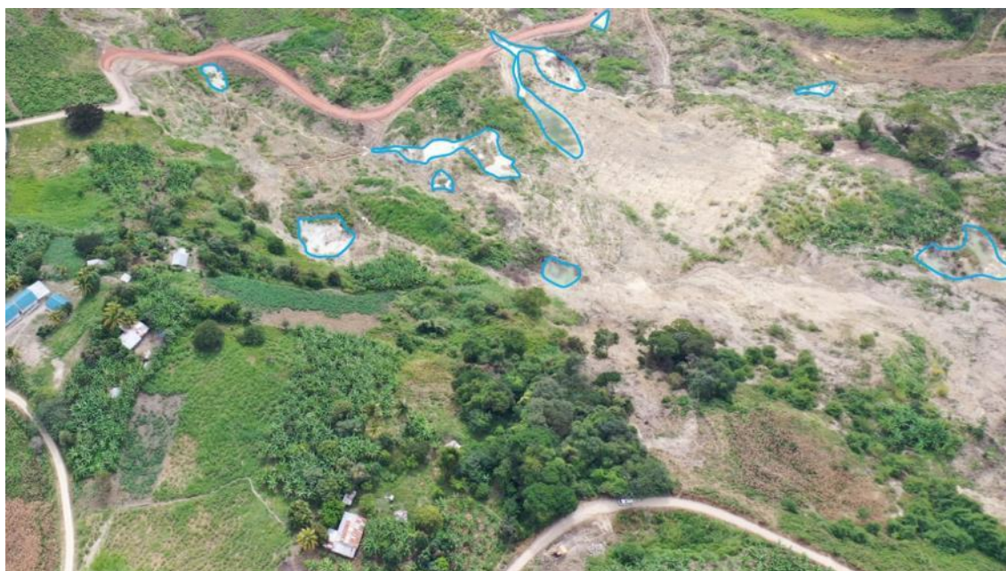
Figura 14. Vista de varios puntos en la parte media superior, donde se identificó surgencia de agua (líneas celestes), dentro del movimiento complejo.
