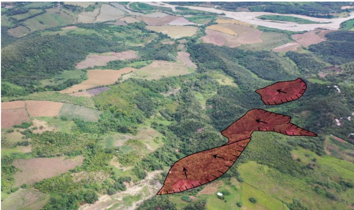
Figura 20. Derrumbe afectó 9.6 hectáreas, ocupadas con vegetación nativa. Coordenadas: E: 805300, N: 9357014.
