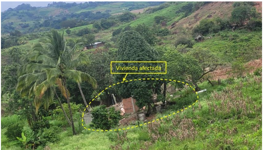
Figura 8. Vivienda inhabitable, dentro del cuerpo del movimiento complejo. Coordenadas: E: 806492, N: 9357224.
