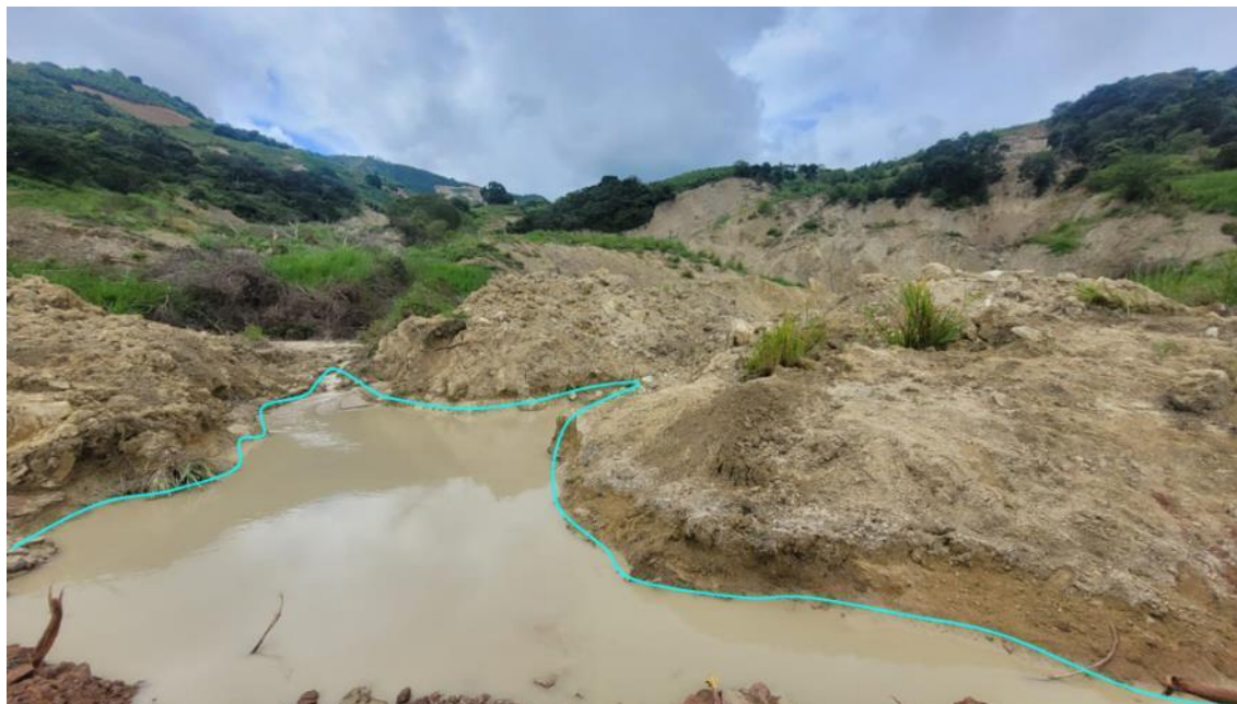
Figura 13. Vista de espejo de agua dentro del cuerpo de deslizamiento (línea celeste), indicador de terrenos saturados.
