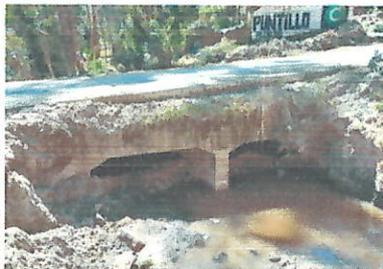
Fotografía N° 02.: Cauce de la quebrada completamente colmatado.
