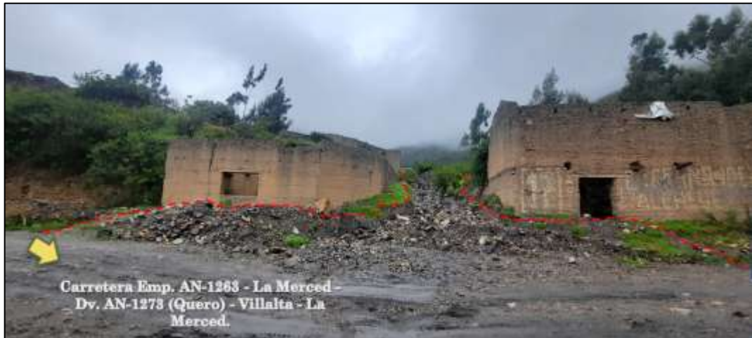
Ilustración 94. Viviendas destruidas por el flujo de lodos y rocas en el caserío Cancal.
