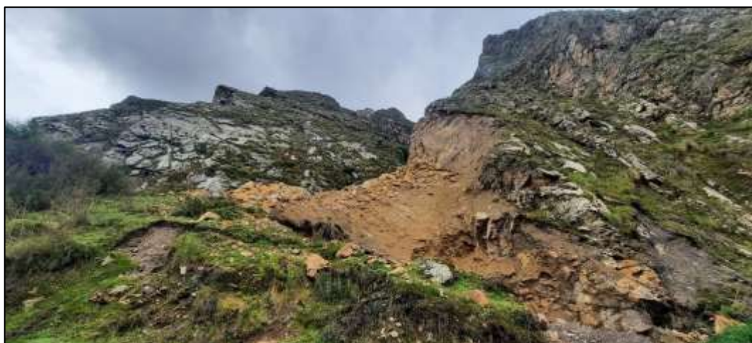
Ilustración 90. Flujo de detritos que interrumpió la vía nacional.
