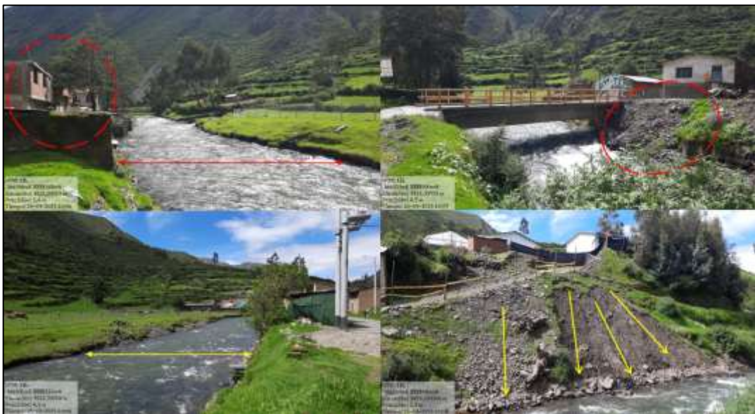
Ilustración 37. Viviendas sobre zonas inundables y márgenes del río erosionados.
