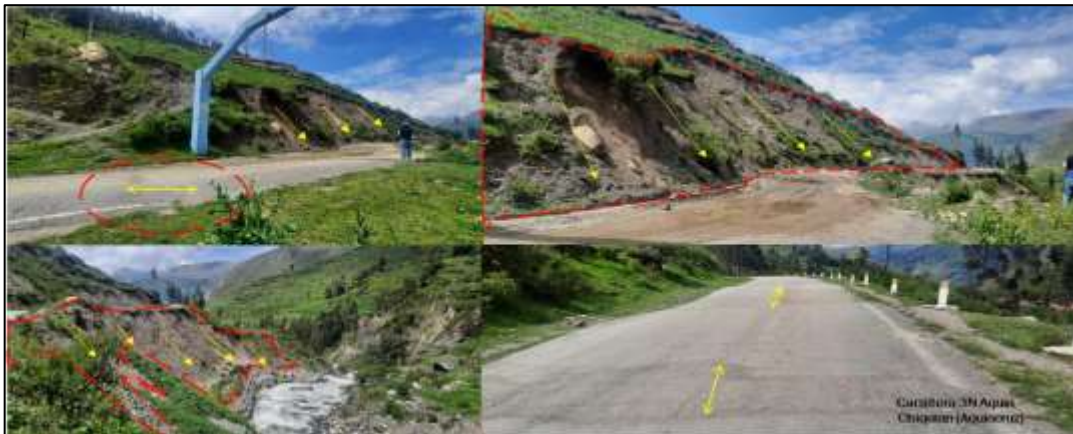
Ilustración 29. Salida de Aquia características que evidencian es deslizamiento.
