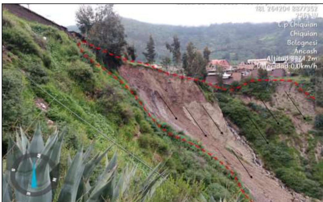
Ilustración 67. Zona de deslizamiento sobre la que se emplazan viviendas.
