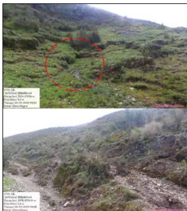
Ilustración 21. Manantial Pachampuqui y áreas de deslizamientos sobre el camino de herradura.
