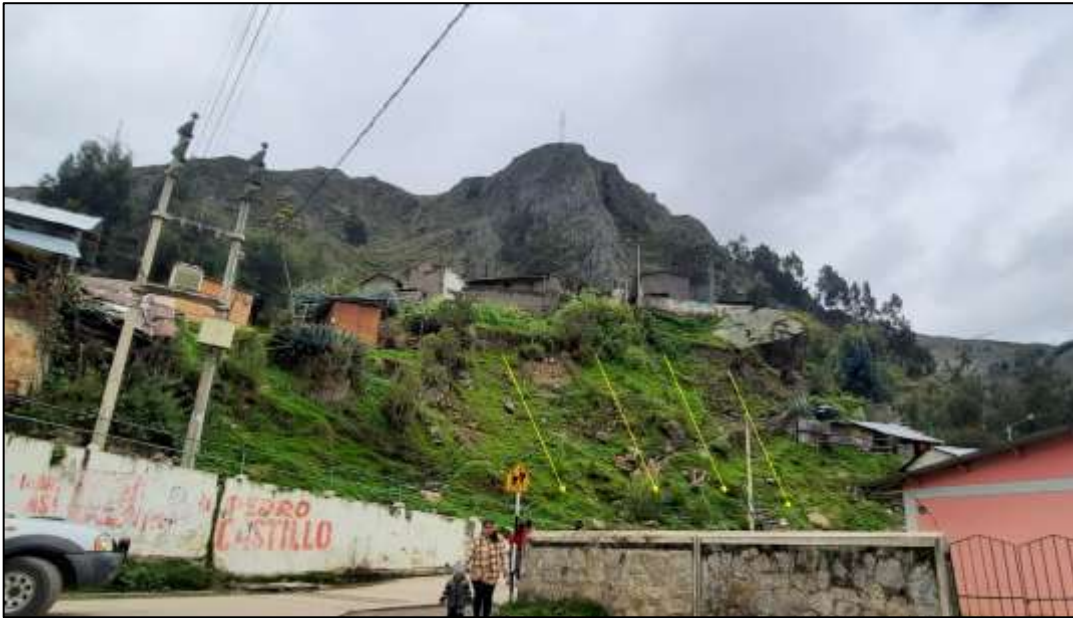
Ilustración 86. Ladera inestable sobre la que se asientan viviendas.
