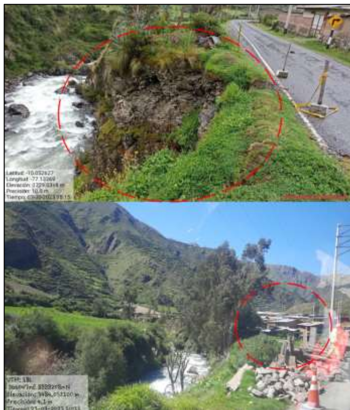
Fuente: Plan de Prevención y Reducción del Riesgo de Desastres del distrito de Aquia 2023 – 2030, MDA.
