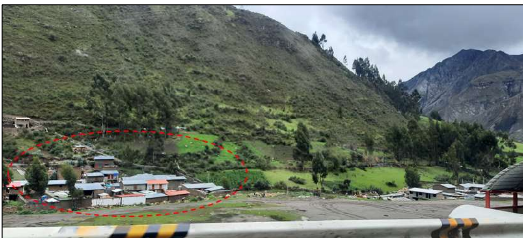
Ilustración 84. Viviendas asentadas en la planicie inundable del río Santa Rosa.
