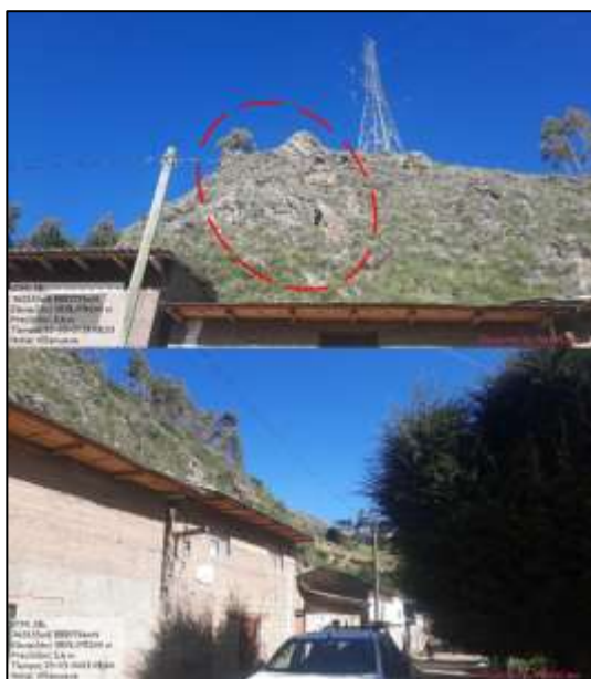
Ilustración 48. Caída de rocas sobre viviendas en el caserío de Villanueva.
