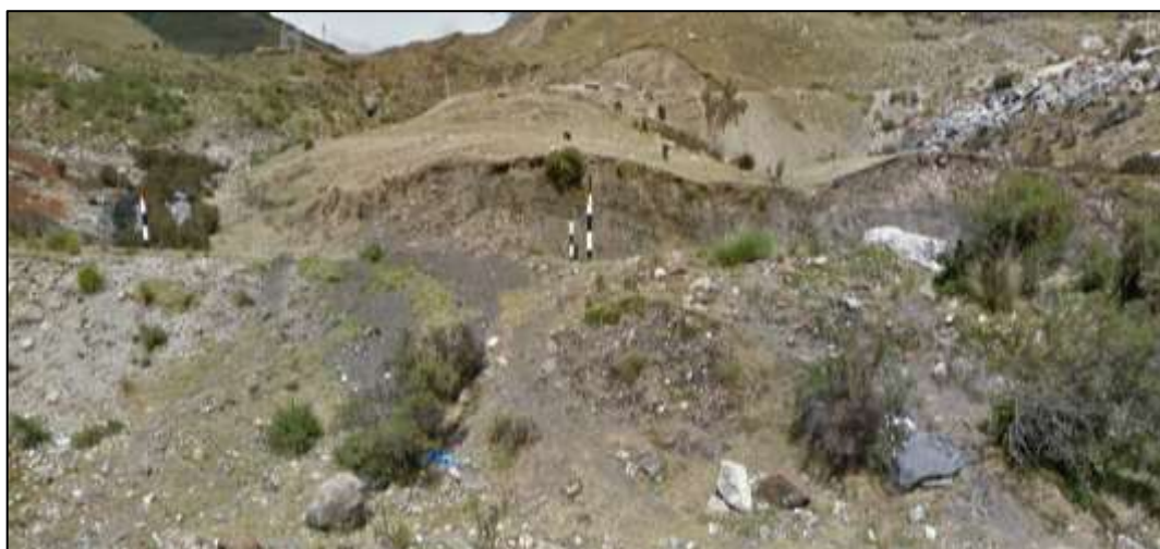
Ilustración 80. Zona de deslizamiento.
