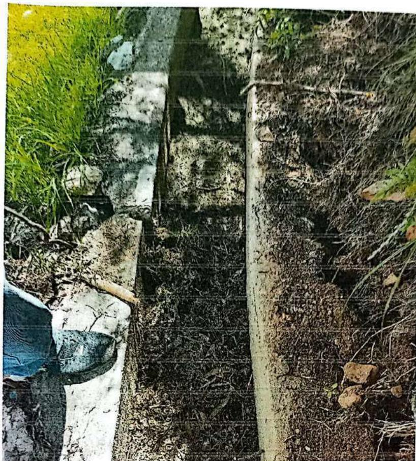
afectado con grietas en varios tramos en un aproximado de 40 a 50 metros de longitud por donde hay fuga de agua al momento que utilizan para riego y esto al desaparecer por las grietas hace que desde la parte baja esta siga avanzando generando un deslizamiento de gran masa de tierra.
