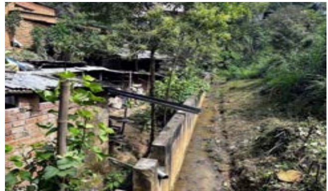
Sector Quebrada Alcaparosa
