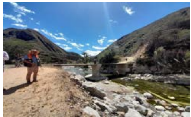
Cochabamba – Puente Valle
