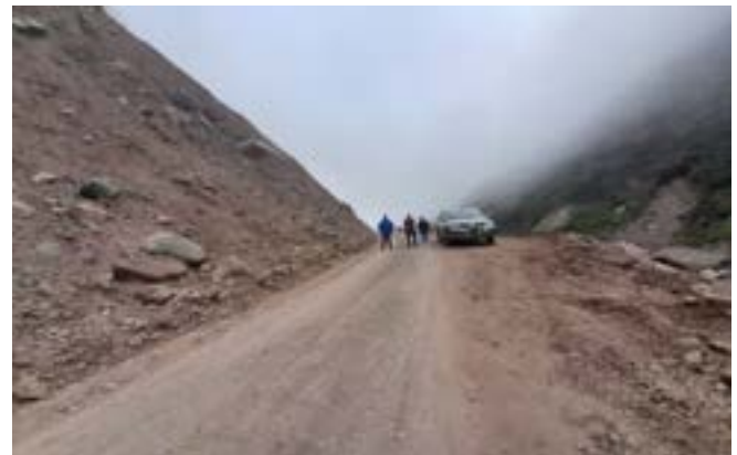
Cirato – El Derrumbe
