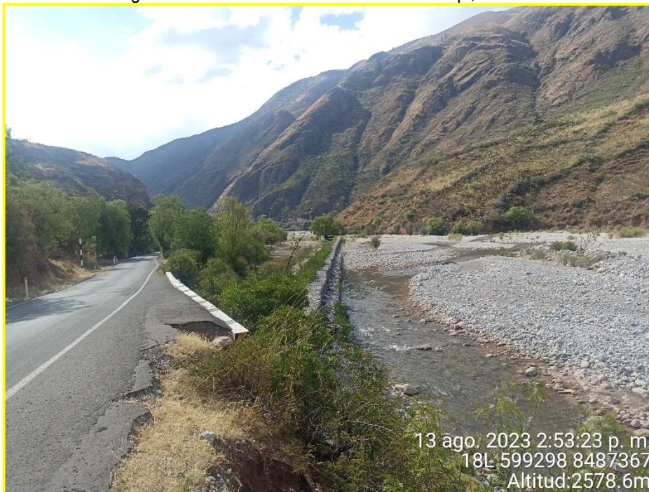
Fotografía N° 12: Vista del cauce fluvial del río Huancapi sector Tío Cucho, se aprecia el punto de inicio del sistema de gacionería deficiente.
