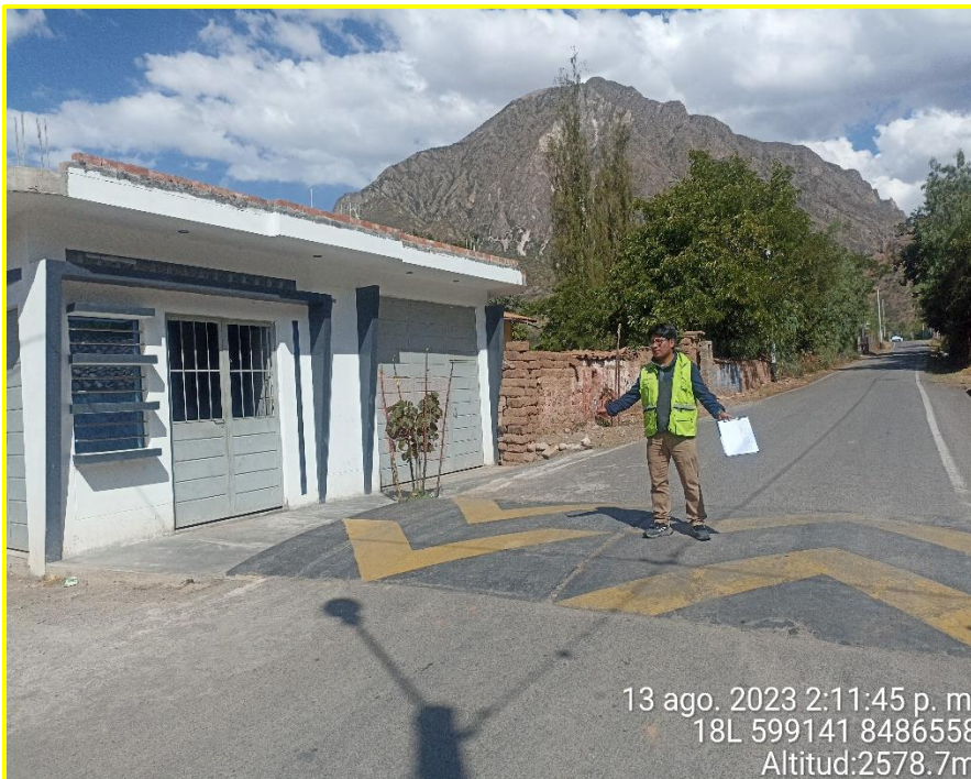
Fotografía N° 05: Vista de viviendas expuestas, construidas en base a tapia y techo de calamina sector San José
