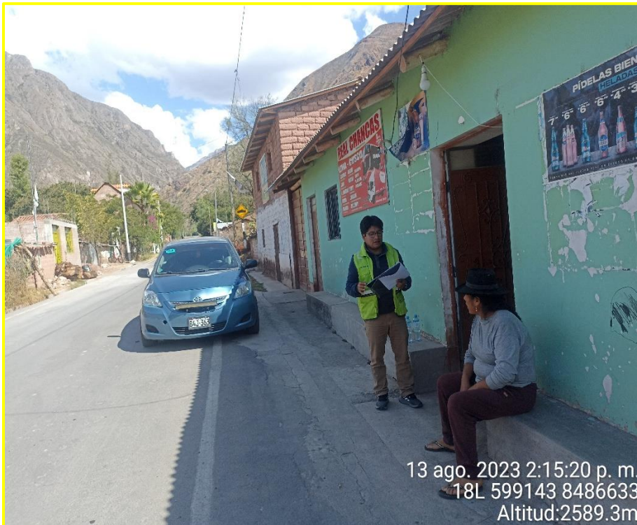
Fotografía N° 07: Vista de vías y viviendas expuestas.
