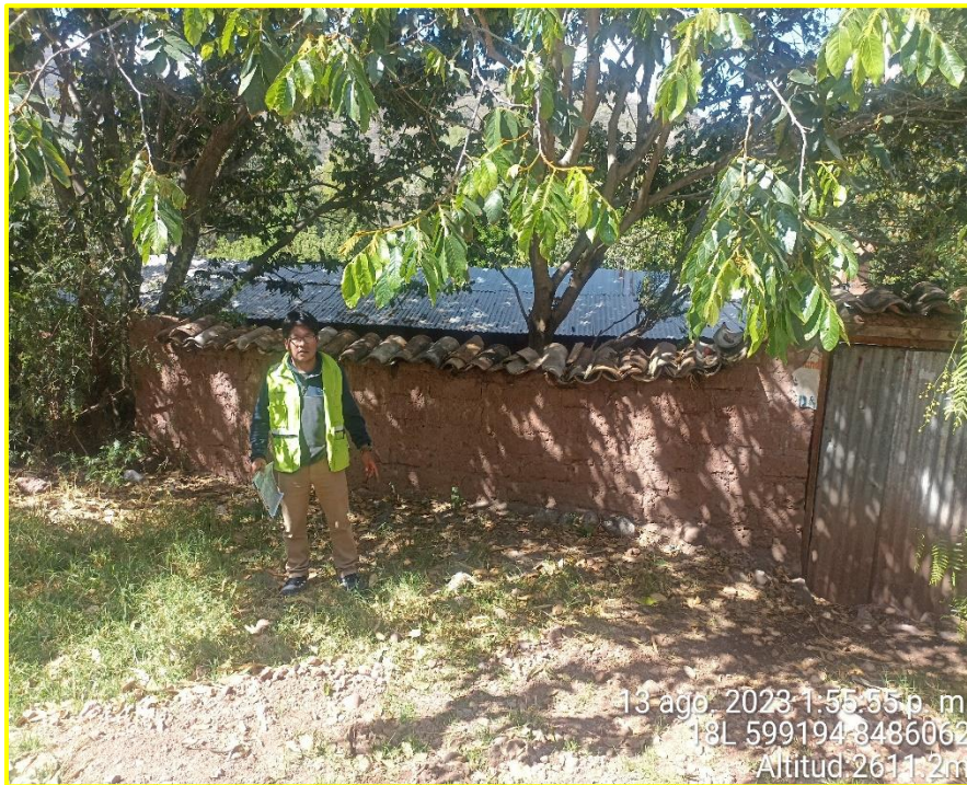
Fotografía N° 05: Vista de viviendas expuestas, construidas en base a tapia y techo de calamina sector San José
