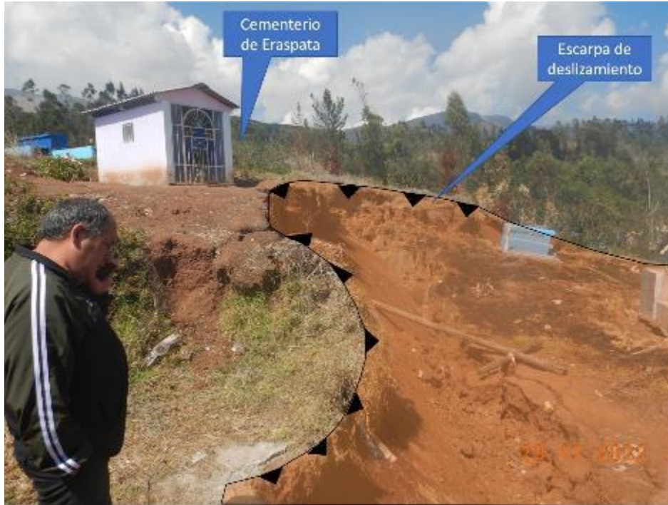
Figura 7. Escarpa principal del deslizamiento en el cementerio de Eraspata, en el cuerpo se aprecian también tumbas que fueron afectadas.
