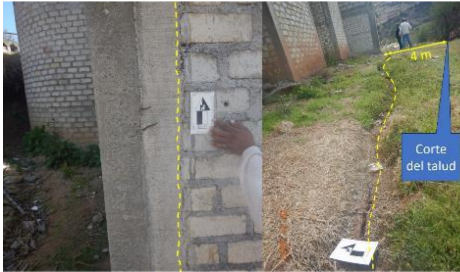
Figura 10. En la zona sur de la iglesia se aprecia una grieta en un muro y junto a ella, en el suelo una grieta con apertura de hasta 2 cm.
