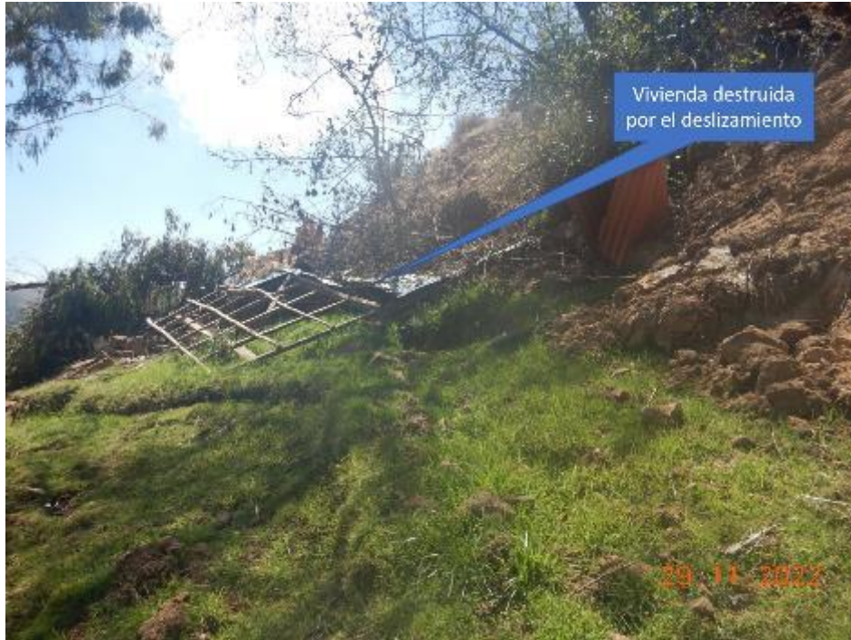
Figura 6. Vivienda ubicada en el pie del deslizamiento que fue destruida por este evento.
