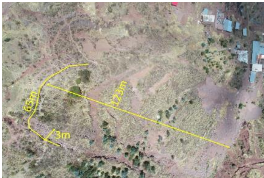
Figura 12. Se aprecia el deslizamiento reactivado con sus medidas.
