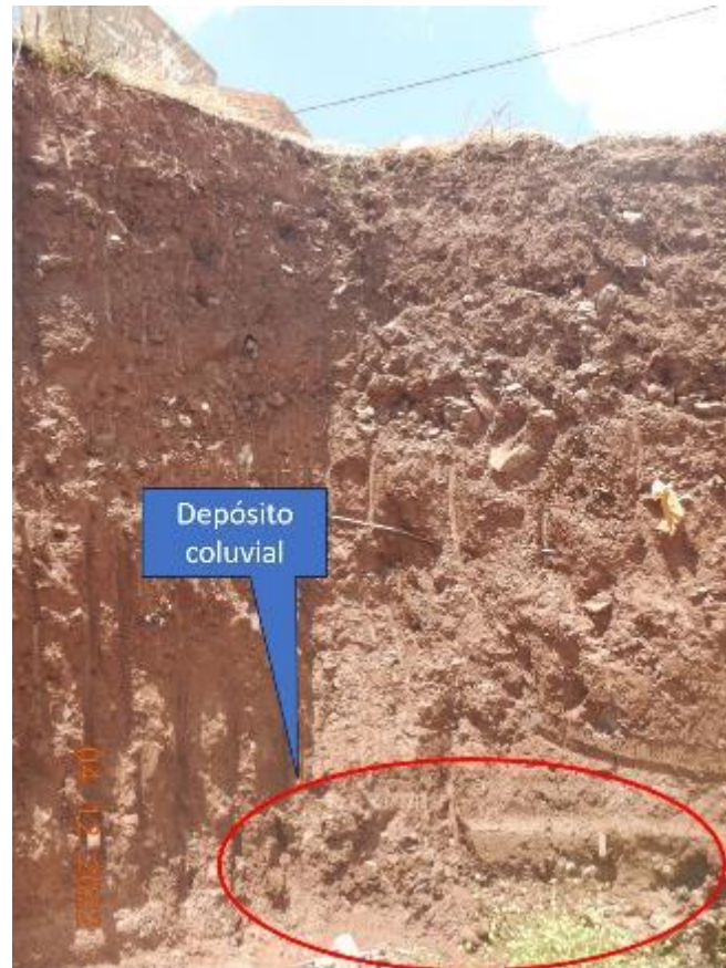
Figura 5. Se aprecia los depósitos coluviales en un corte de 2 m de altura.
