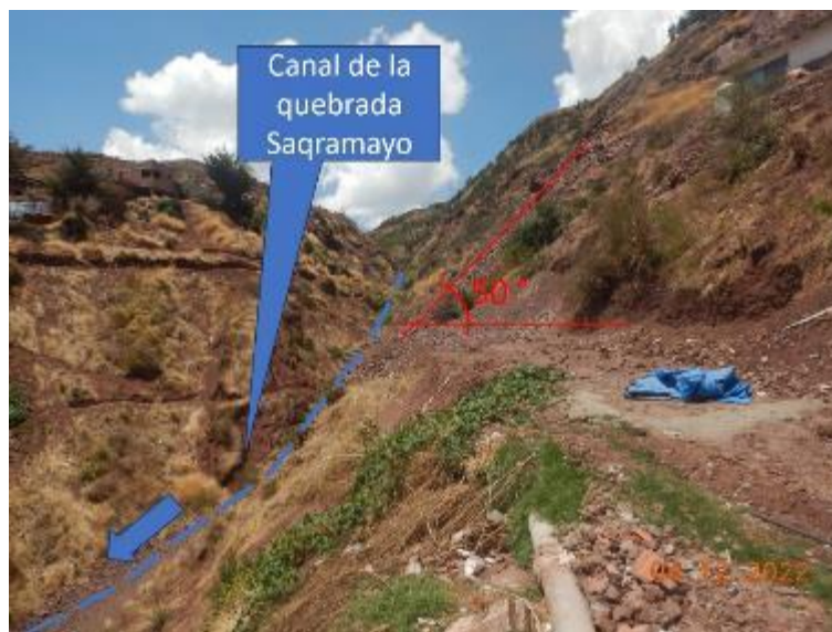
Figura 6. Se aprecia el canal de la quebrada a la altura del deslizamiento en el sector B, se aprecia la pendiente en la margen izquierda de la quebrada.
