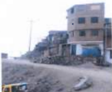
Foto 31: Vista de base de vivienda
