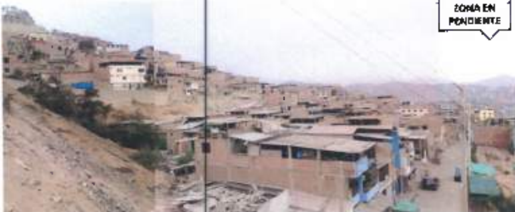
Foto 7: Vista de viviendas en pendiente, desde calle Los Jesuitas
