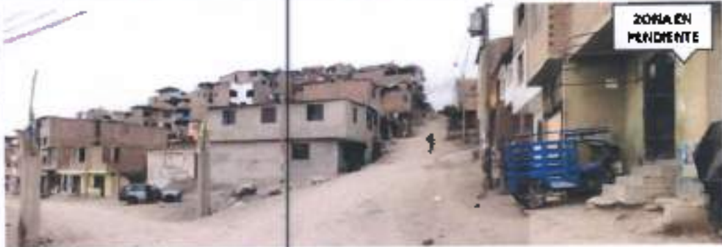
Foto 15: Vista de viviendas en pendiente, desde Calle 2 de Junio
