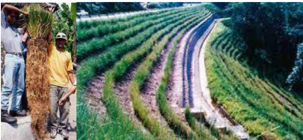
Fotografía 204. Ejemplo de bioingeniería con arbusto (vetiver) en taludes de materiales sueltos.
