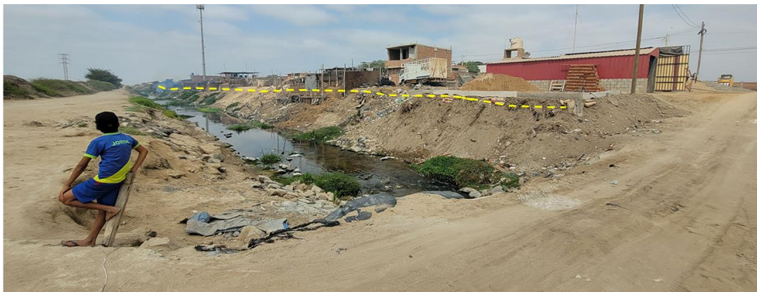
Figura 31. Erosión fluvial en la localidad de Demetrio Acosta Chuez, Lambayeque, donde los depósitos antrópicos son erosionados por el flujo constante del en el canal.
