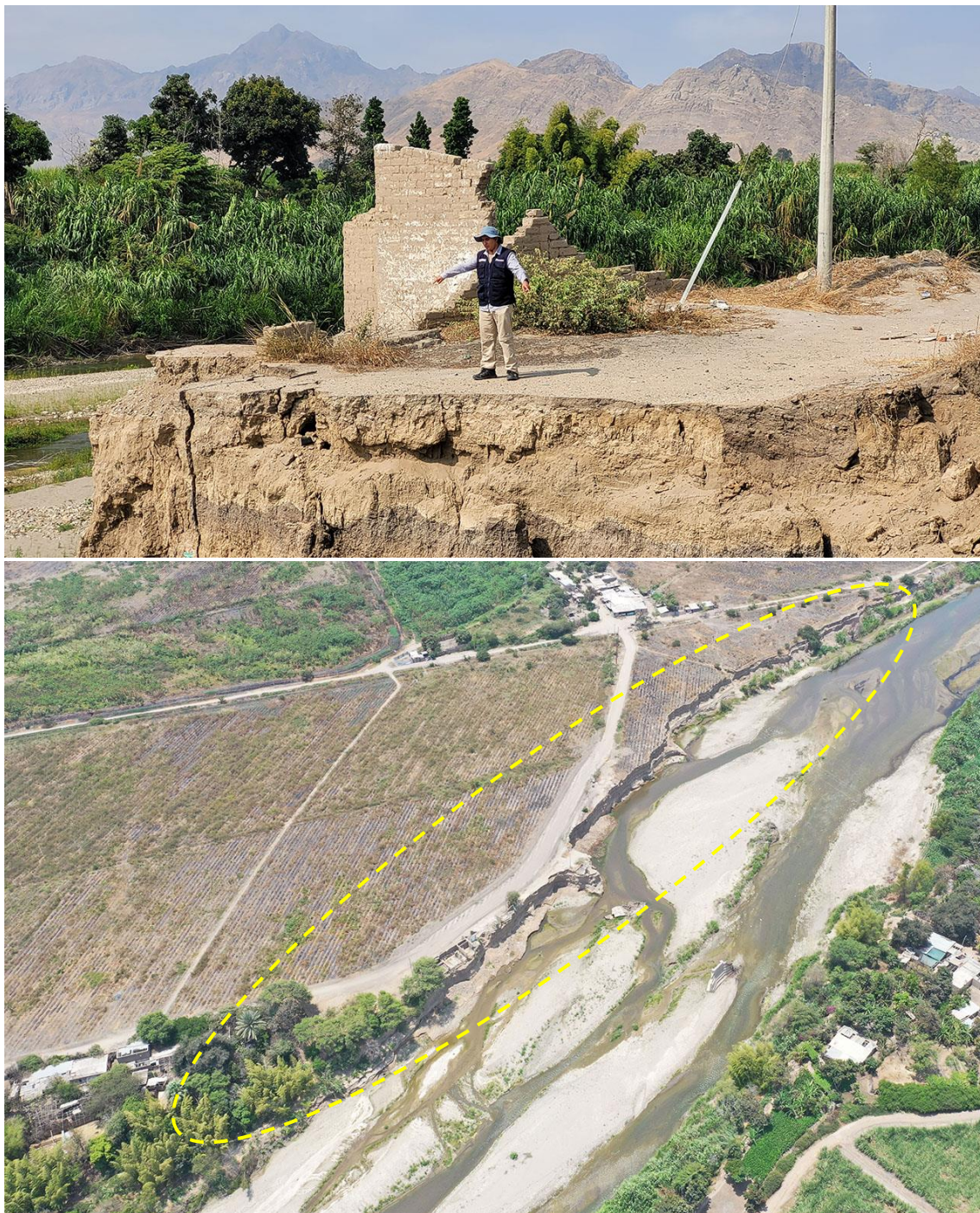
Fotografía 120. Zona crítica 14-089, erosión fluvial en la localidad de San Baltazar que podría afectar 12 viviendas y 100 m de una vía local. Coordenadas E: 652955; N:9249112. (26/09/23).
