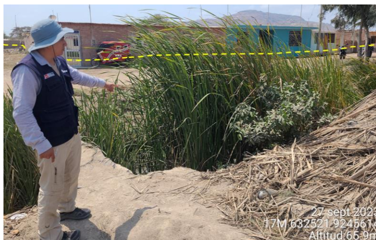
Figura 35. Inundación fluvial por desborde de canal de regadío en mal estado en la localidad de San Pablo, Pomalca (ZC 14-088), la altura de inundación se delimita en amarillo.
