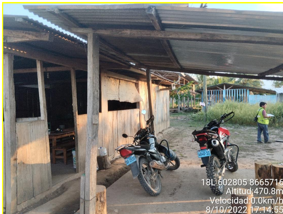
Fotografía N° 05. Vista de viviendas expuestas del sector 02 (Puerto Shampintiari), construidas en base a calaminas y madera.
