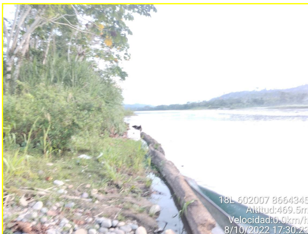
Fotografía N° 04 Vista de áreas susceptibles a la ocurrencia de inundación fluvial, Sector 02 (Puerto Rico del Ene).
