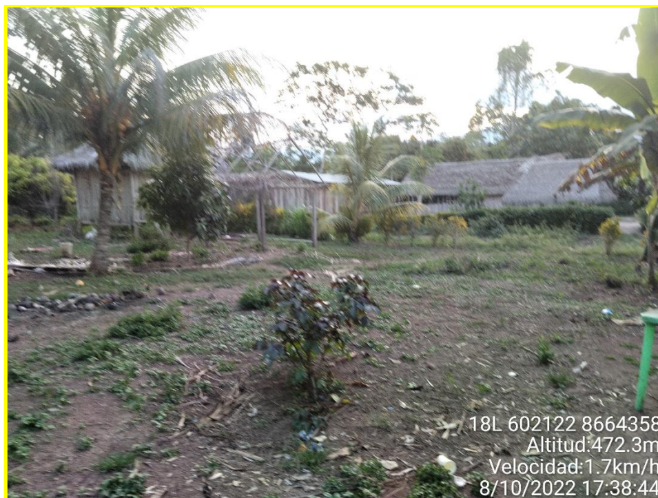
Fotografía N° 08 Vista de viviendas expuestas del sector 02 (Puerto Rico del Ene), construidas en base a madera y techados con calamina y/o hojas de palmera.
