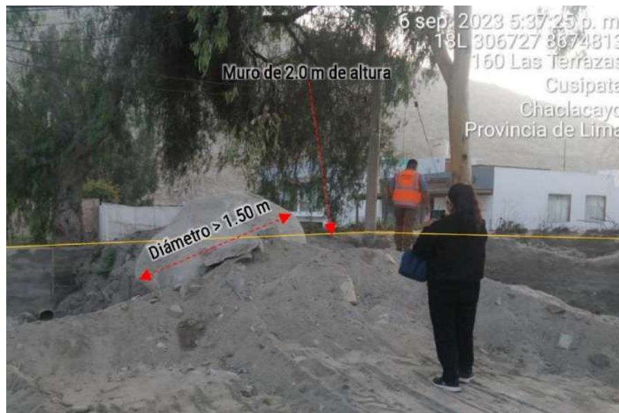
Figura 7. Curva de calle Las Terrazas a calle La Fontana con acumulación de sedimentos y escombros, Cusipata.
