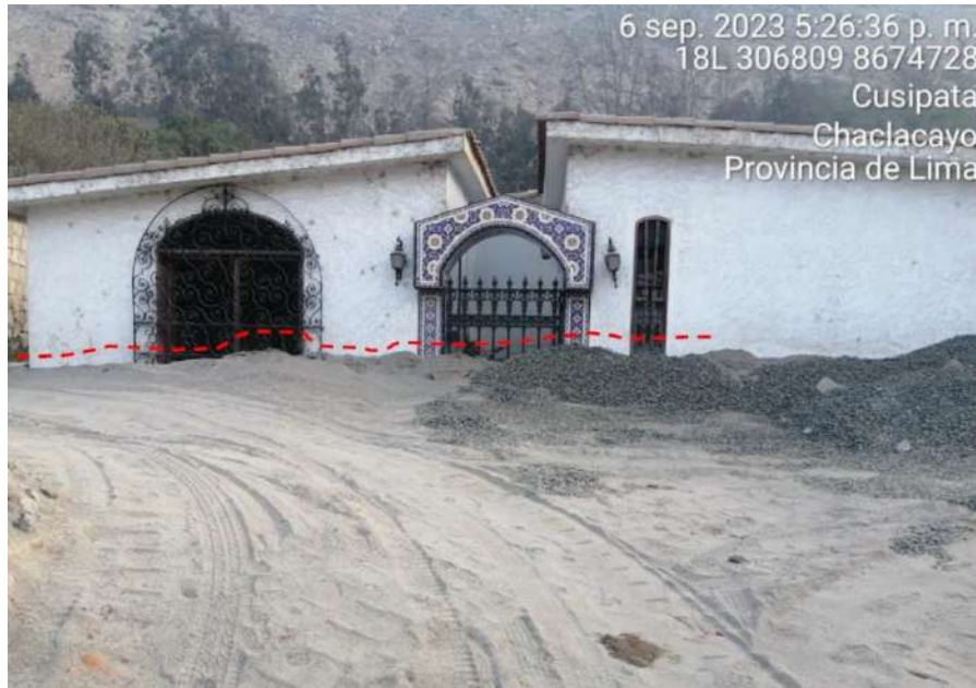
Figura 6. Vivienda colmada por sedimentos, en Cusipata.
