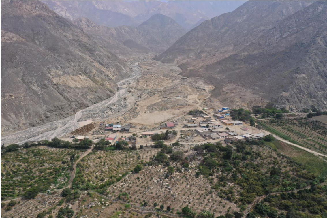
Fotografía 300. En la imagen tomado con dirección suroeste se observa el centro poblado de Mandahuaz se ubica en la desembocadura de una quebrada donde se generan flujos en periodo de lluvias intensas. Coordenadas UTM: 8853444 norte y 209125 este.
