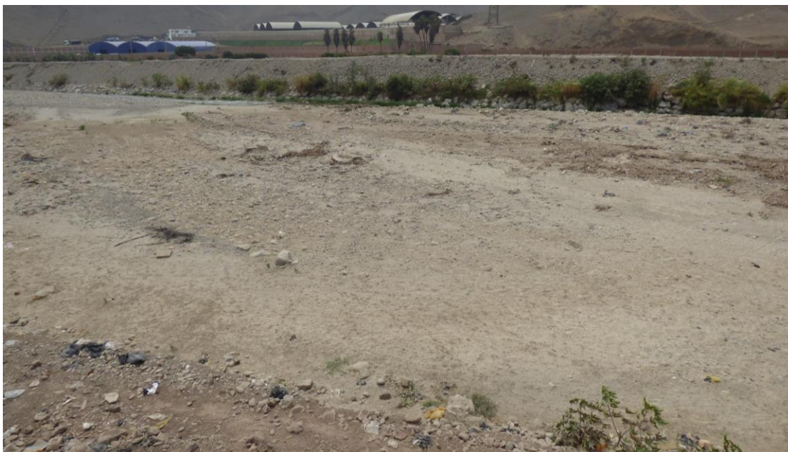
Fotografía 90. Área sujeta a inundación en ambas márgenes del río Chillón, sector Lomas de Chillón en el distrito de San Martín de Porres.
