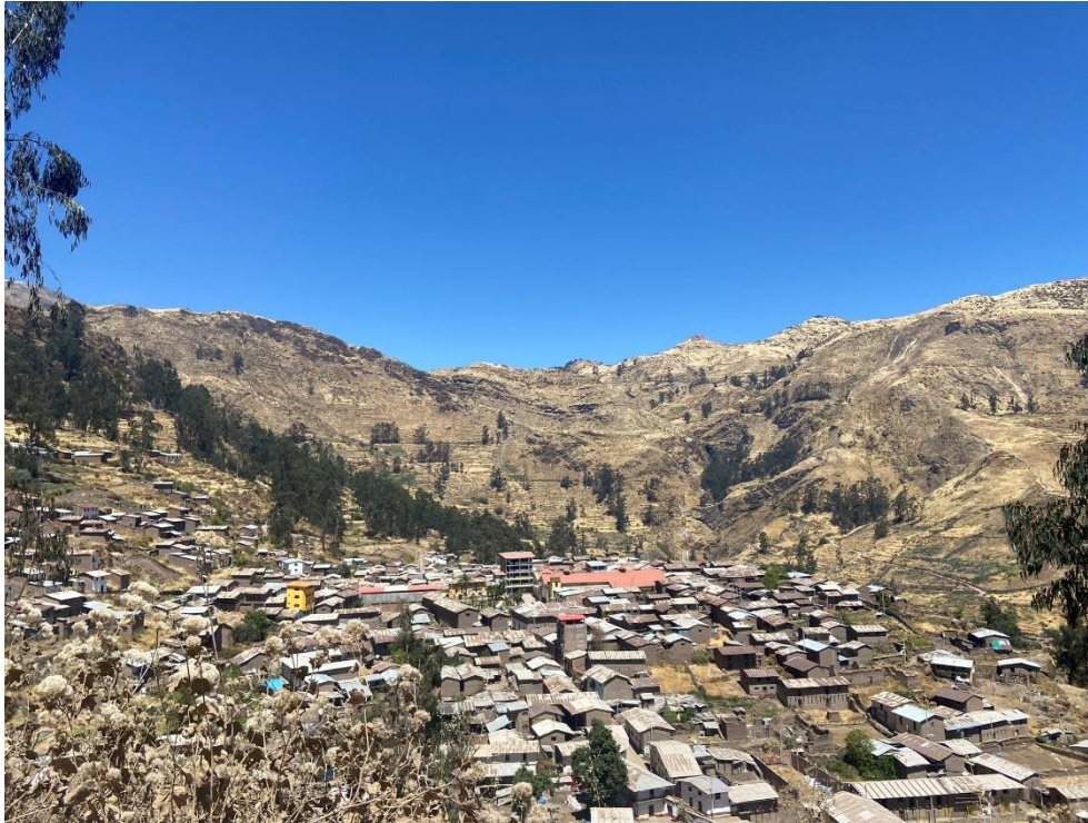
Fotografía 382. Zona crítica 15-306. Peligro por reactivación de deslizamiento sobre el cual está asentado la localidad de Quinchés. Coordenadas UTM 375704/8639171N, zona 18S. Tomado el 07/09/2023.
