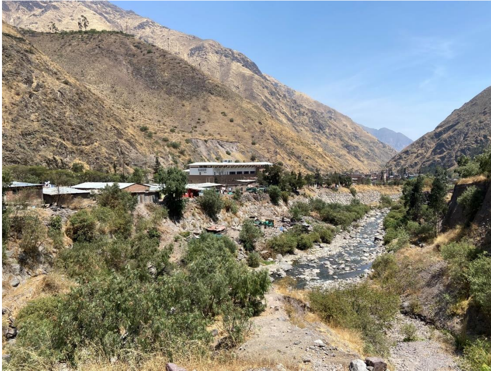
Fotografía 365. Zona crítica 15-267. Peligro por flujo de detritos proveniente de la quebrada Payhua, erosión e inundación fluvial en el distrito Matucana. Coordenadas UTM 349585E/8690730N, zona 18S. Tomado el 11/09/2023.
