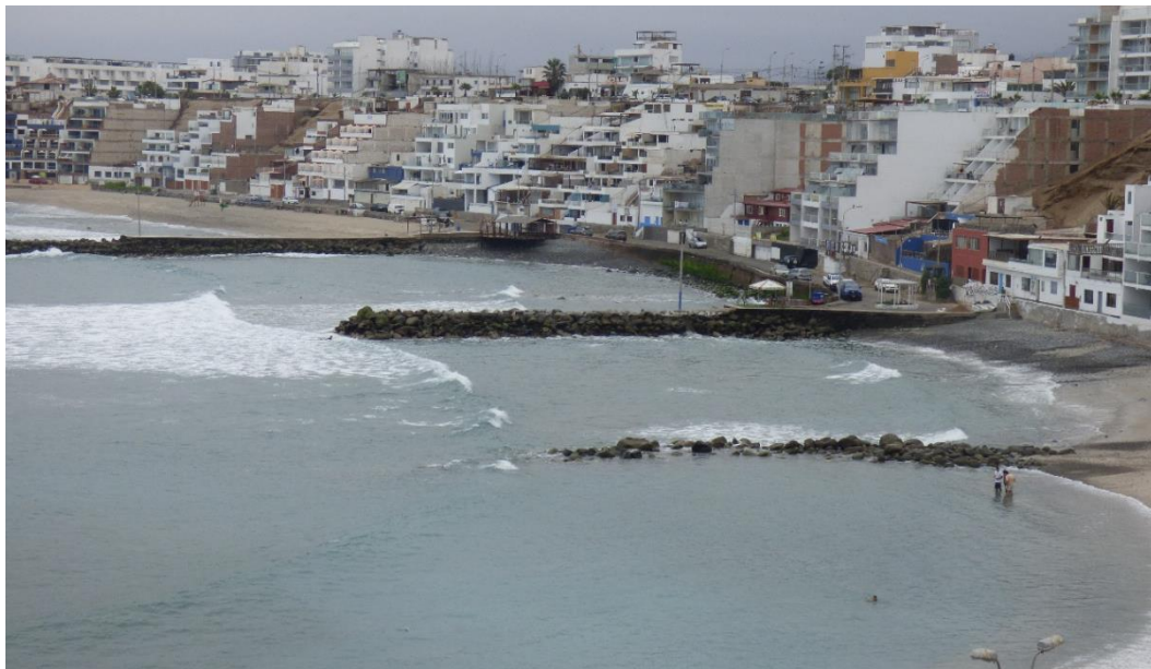
Fotografía 101. Playa Norte en el distrito de San Bartolo. Se observan cómo las corrientes marinas están erosionando los muros protectores y afectando algunas viviendas.
