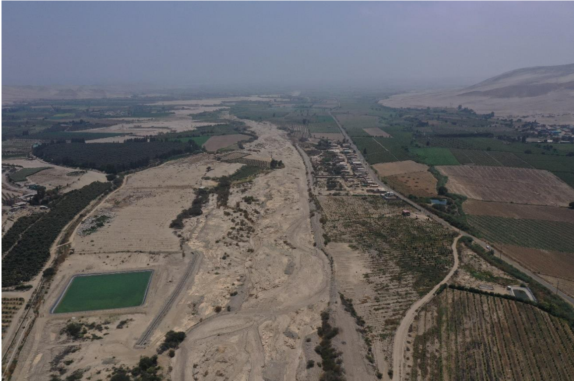
Fotografía 314. La imagen, capturada mediante un dron, muestra el centro poblado de San Nicolás de Pullanchaqui, situado en la margen derecha del río Supe. Esta captura demuestra que durante un período de lluvias intensas y/o prolongadas, en el cual el aumento del caudal del río puede desencadenar procesos geológicos, como la erosión fluvial, que tienen el potencial de inundar áreas circundantes. Esto puede resultar en daños a viviendas y terrenos de cultivo. Las coordenadas UTM corresponden a 8799739 al norte y 213908 al este.
