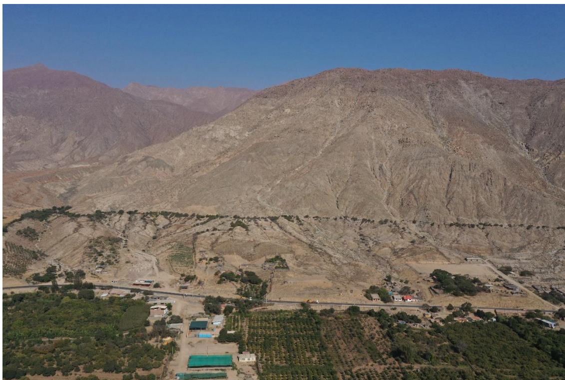
Fotografía 306. La imagen, capturada mediante un dron, nos muestra el centro poblado de Anta, situado en la base de la ladera en el flanco noroeste del cerro Víbora. Esta área se ve afectada por flujos de detritos que se originan en las quebradas circundantes, causando daños a viviendas y a un tramo de la carretera que conecta Barranca con Chasquitambo. Las coordenadas UTM corresponden a 8849139 al norte y 204722 al este.
