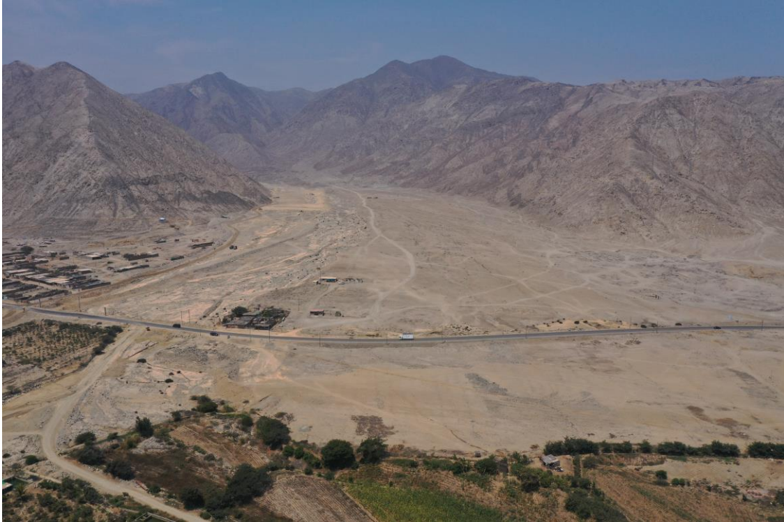
Fotografía 296. Imagen tomada con Drone de la quebrada Huaricanga, Paramonga, Barranca, se observa que en el sector ocurren flujos en períodos de lluvias intensas, afectando viviendas asentadas cerca al cauce, tramo de vía asfaltada. Coordenadas UTM: 8839164 norte y 198928 este.
