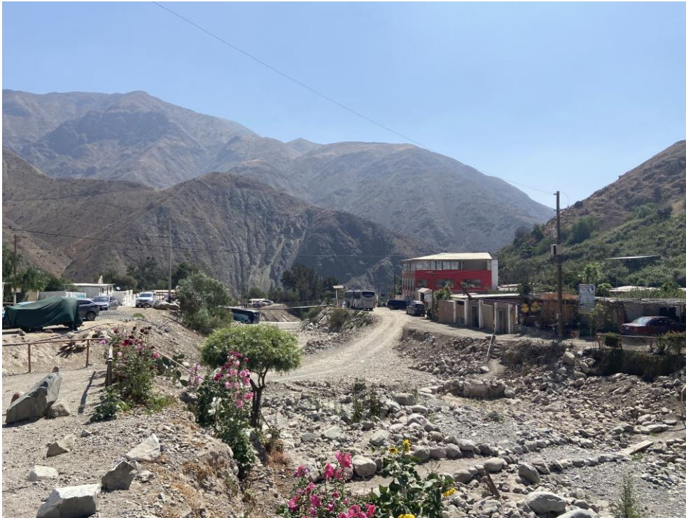
Fotografía 357. Zona crítica 15-251. Peligro por flujo de detritos, la quebrada Chamcana pasa por el medio de la ciudad de Antioquia. Coordenadas UTM 335708E/8664196N, zona 18S. Tomado el 09/09/2023.
