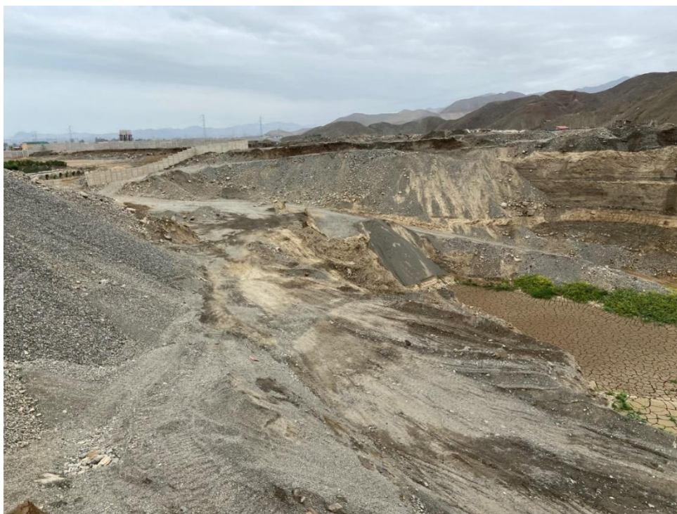
Fotografía 107. Vista de los depósitos de desmonte en la quebrada Higuera, distrito Mala. Los depósitos de desmonte se encuentran afectados por flujos de lodos.
