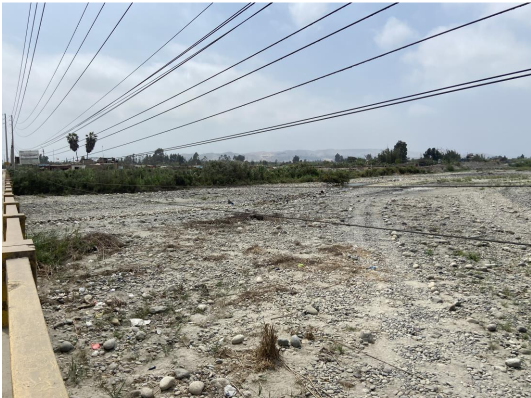
Fotografía 93. Área sujeta a inundación en ambas márgenes del río Cañete, sector Clarita, provincia Cañete.
