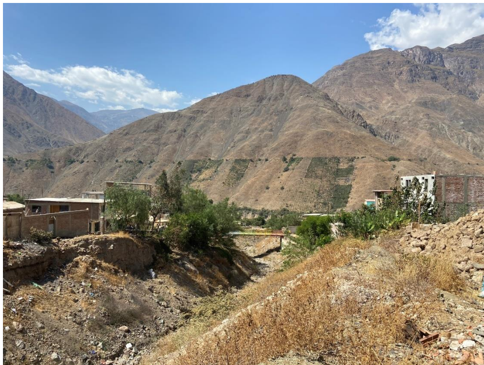
Fotografía 358. Zona crítica 15-253. Peligro por flujo de detritos en la quebrada Cochahuayco que afectaría a la localidad homónima, distrito Antioquia. Coordenadas UTM 366015E/86628566N, zona 18S. Tomado el 09/09/2023.
