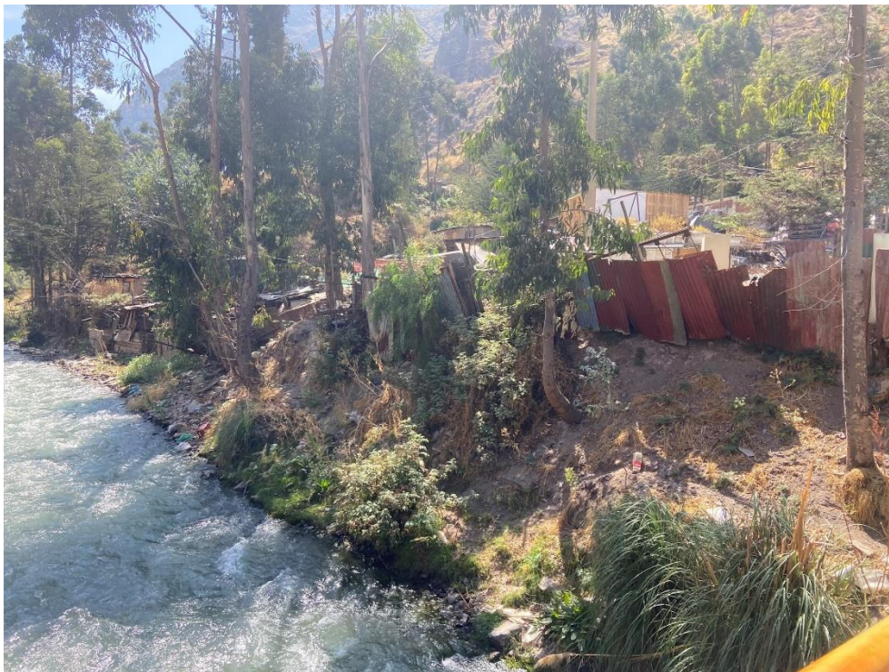
Fotografía 366. Zona crítica 15-271. Peligro por erosión e inundación fluvial por el río Rímac, distrito San Mateo. Coordenadas UTM 358013E/8699686N, zona 18S. Tomado el 11/09/2023.
