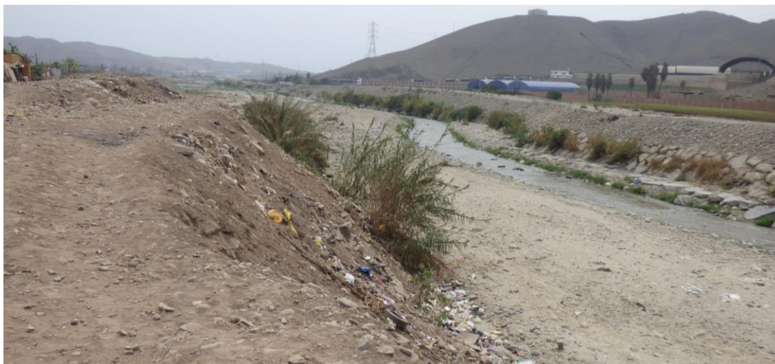
Fotografía 21. Depósitos antropogénicos en la margen izquierda del río Chillón, el depósito de desmonte y basura se ha colocado a modo de barrera, sin embargo, las crecidas del río erosionan constantemente este material, poniendo en peligro viviendas del sector Lomas de Chillón en el distrito de San Martín de Porres.
