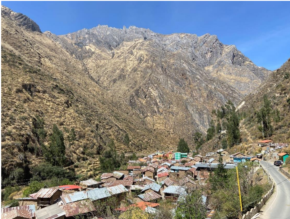
Fotografía 375. Zona crítica 15-285. Peligro por derrumbes y erosión de laderas en el distrito de Alis. Coordenadas UTM 414478E/8642550N, zona 18S. Tomado el 23/08/2023.
