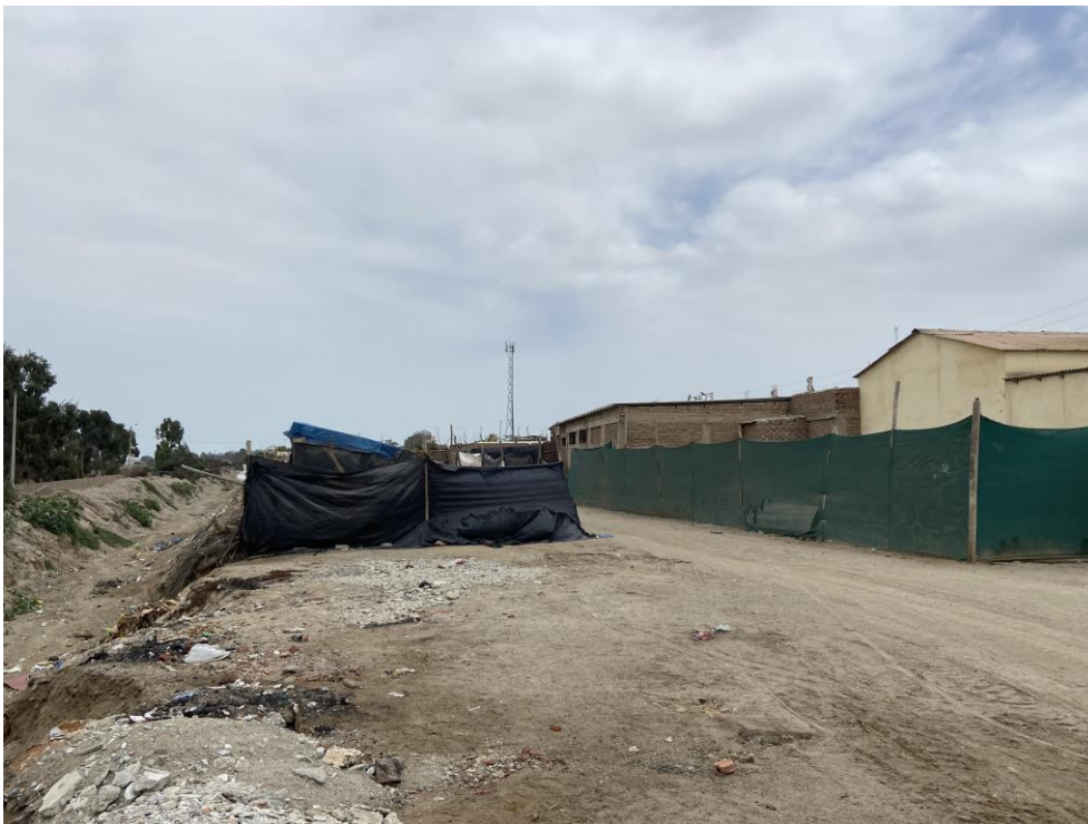
Fotografía 351. Zona crítica 15-232. AA.HH. 15 de enero, puede ser afectado por flujo de detritos, se observa la quebrada en el sector izquierdo, distrito Chilca. Coordenadas UTM 311344E/8618806N, zona 18S. Tomado el 08/09/2023.
