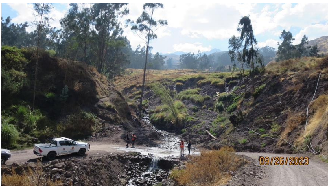
Fotografía 322. La captura, tomada en dirección noreste, nos ofrece una vista de la quebrada Angostura. Durante períodos de lluvias intensas, esta área se vuelve susceptible a una serie de procesos geológicos, incluyendo flujos de detritos, y derrumbes. Además, las laderas y quebradas circundantes son propensas a deslizamientos y flujos. Estos procesos tienen el potencial de causar daños a viviendas, v las de acceso, puentes peatonales y terrenos de cultivo en el sector. Las coordenadas UTM asociadas son 8729189 a y norte y 322981 al este.
