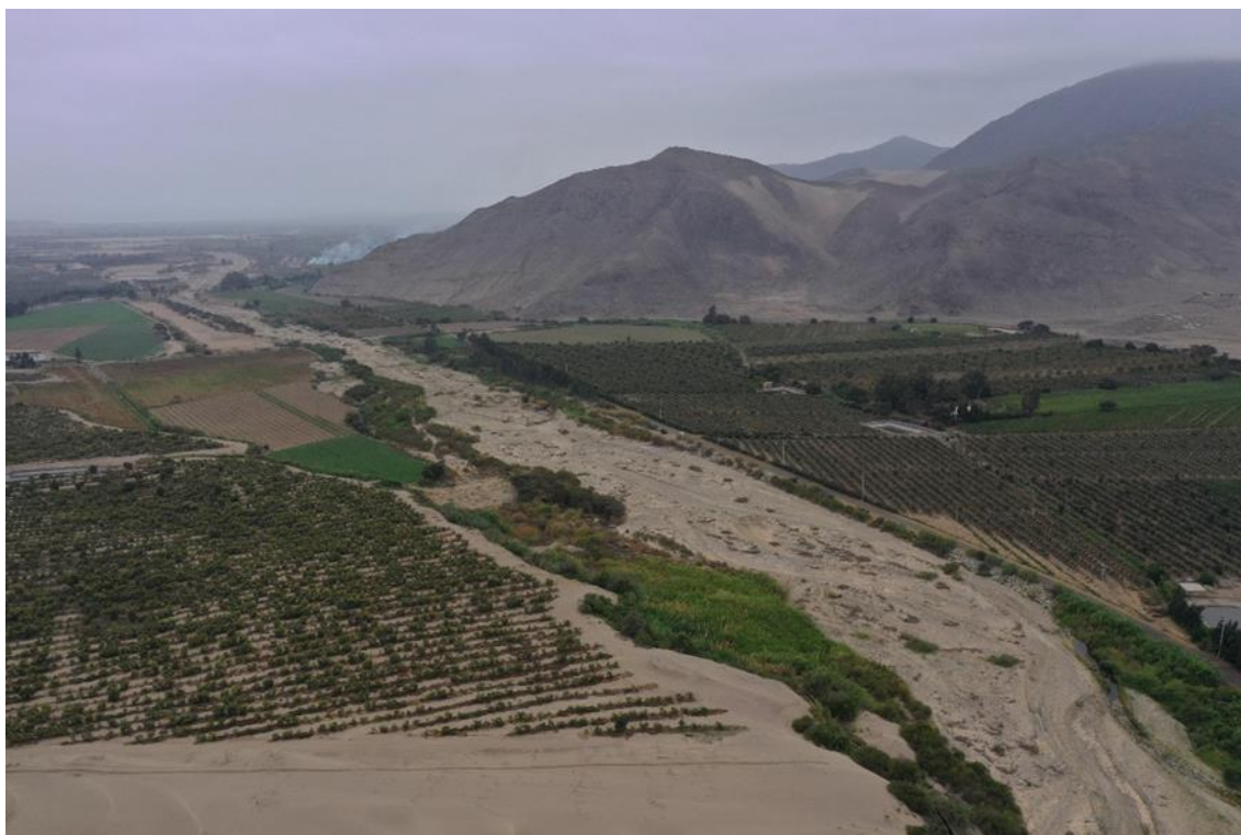
Fotografía 312. Imagen tomada con Drone, se observa el Río Supe y por la margen derecha se trazó la carretera Supe – Caraz la vía asfaltada en el tramo Km 11+800 es afectado por erosión fluvial e inundación en periodo de lluvias intensas, también afecta terrenos de cultivo. Coordenadas UTM: 8799581 norte y 216177este.
