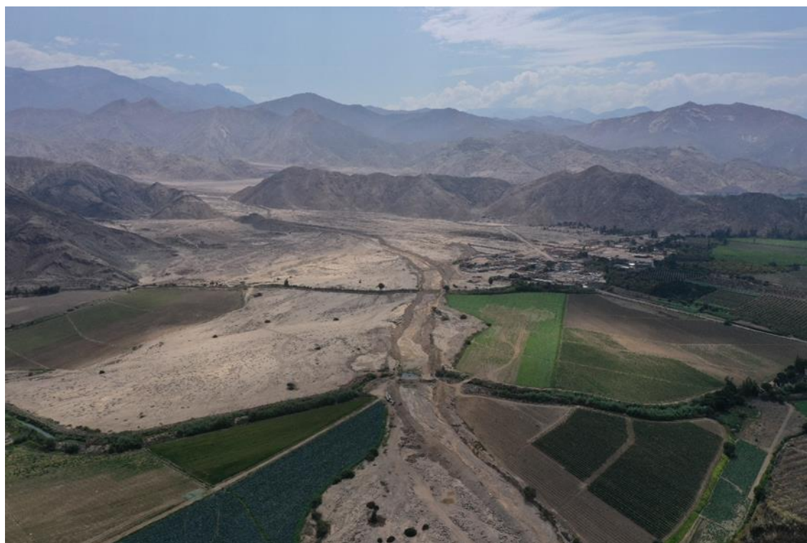
Fotografía 340. La vista tomada con un dron nos muestra una imagen del sector Quebrada Chambara, propenso a experimentar procesos geológicos como flujo de detritos y erosión fluvial, afectaría viviendas situadas en el anexo Chambara. Las coordenadas UTM correspondientes son 8771256 al norte y 245241 al este.
