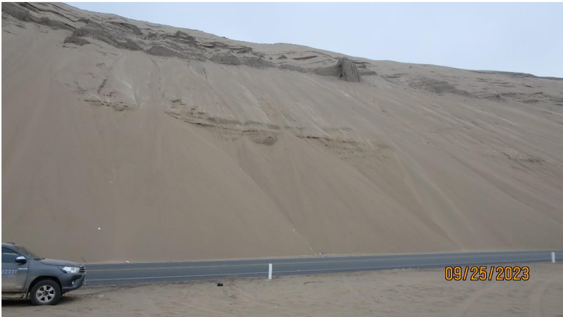
Fotografía 15. Depósitos eólicos en serpentin de Pasamayo, Aucallama – Huaral, se produce en el sector arenamiento, derrumbes y flujos secos.
