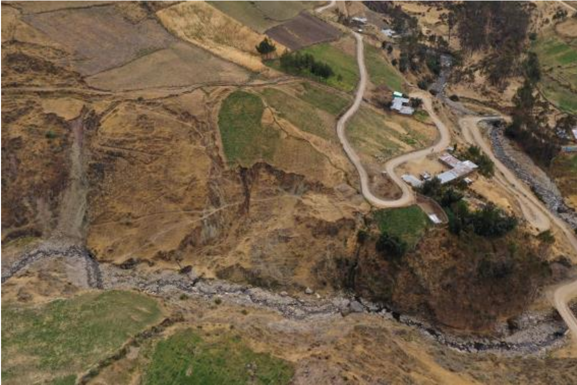
Fotografía 315. Captura de imagen con drone, se observa el valle del río Paca, hacia la confluencia con el río Gorgor donde se construyó un puente que comunica a los centros poblados del sector. Las coordenadas UTM corresponden a: 8825577 de norte y 284795 de este.
