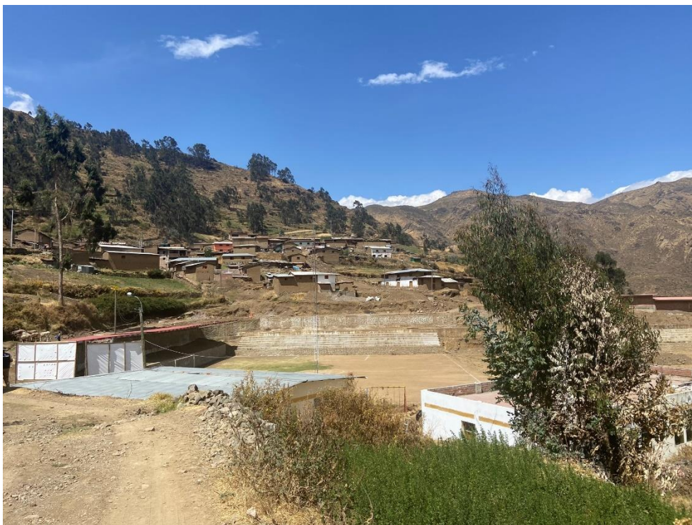
Fotografía 370. Zona crítica 15-277. Peligro por deslizamiento en el distrito de Santiago de Anchucaya asentado sobre antiguo depósito de deslizamiento. Coordenadas UTM 365897E/8662599N, zona 18S. Tomado el 06/09/2023.
