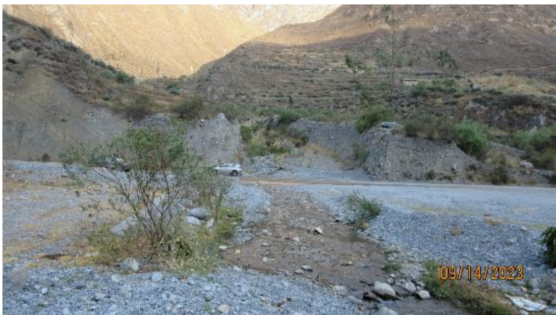
Fotografía 341. Captura de imagen tomada con dirección noroeste, se observa a la margen izquierda la carretera que conecta Churín - Oyón, Quebrada Mallay es afectado por procesos geológicos Flujo de detritos y caídas, también es afectado por erosión fluvial. En periodo de lluvias intensas afecta vía asfaltada que deja aislado los centros poblados. Las coordenadas UTM corresponden a: 8811858 al norte y 296927 al este.
