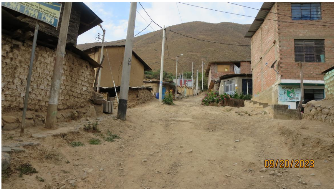
Fotografía 328. La vista tomada con dirección noreste nos muestra una imagen del poblado de San Agustín de Huayopampa, asentado en el flanco suroeste del cerro Caraupata margen derecha del río Anasmayo, este lugar se ve afectado por procesos geológicos como flujo de detritos que activan las quebradas donde se sitúa la población. Las coordenadas UTM correspondientes son 8744429 al norte y 300816 al este.
