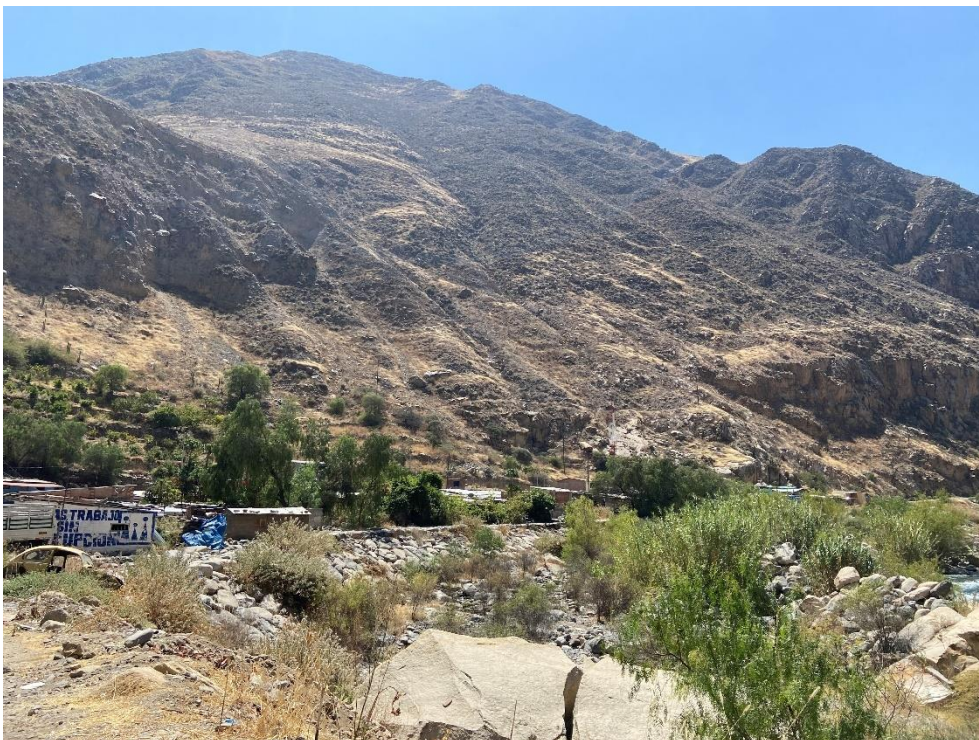
Fotografía 373. Zona crítica 15-283. Peligro por derrumbes, caída de rocas y erosión de laderas que afecten a las viviendas de Puente Auco y la carretera Cañete-Yauyos. Coordenadas UTM 396658E/8608830N, zona 18S. Tomado el 26/08/2023.
