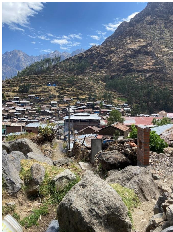
Fotografía 379. Zona crítica 15-299. Peligro por flujo de detritos por la quebrada Chure que pueden afectar a la localidad de Huantán. Coordenadas UTM 411769E/8622867N, zona 18S. Tomado el 25/08/2023.
