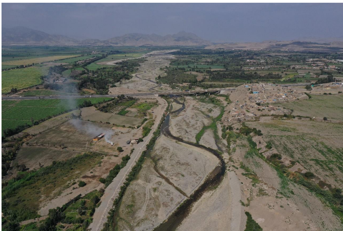
Fotografía 94. Planicie fluvio-aluvial, que se ubica a la altura del valle Huaura, río Huaura.
