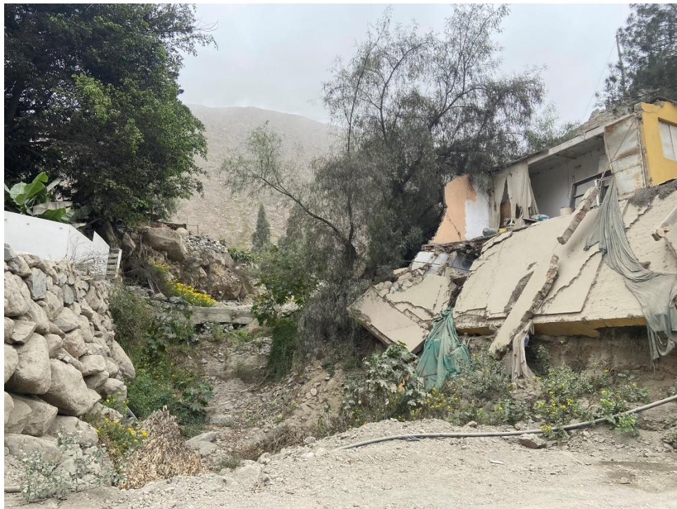
Fotografía 360. Zona crítica 15-259. Peligro por flujo de detritos que afectaría al sector San Martín y la Carretera Cieneguilla-Huarochiri, distrito Antioquia. Coordenadas UTM 316300E/8670001N, zona 18S. Tomado el 09/09/2023.
