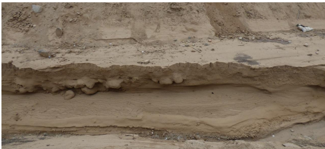
Fotografía 5. Depósito aluvial en la margen derecha de la quebrada Cruz de Hueso- San Bartolo
