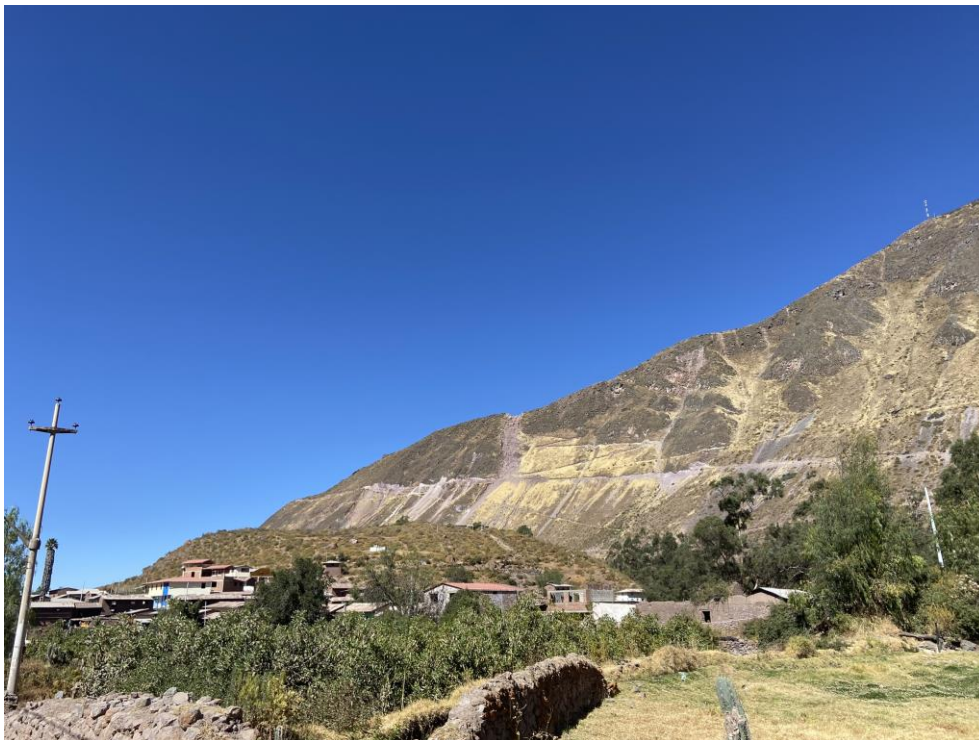
Fotografía 368. Zona crítica 15-274. Peligro por derrumbes que afectarían a la localidad de Sangallaya y a la vía Quiripa-Huarochirí. Coordenadas UTM 365887E/8654611N, zona 18S. Tomado el 07/09/2023.
