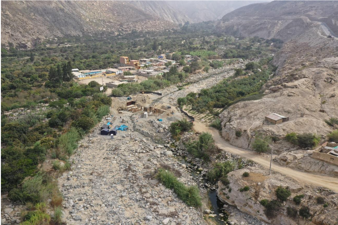
Fotografía 302. Vista tomada con Drone, se observa el Centro Poblado de Malvados, ubicado en el cauce principal del río Fortaleza, el sector puede ser afectado por erosión fluvial inundación con la presencia de lluvias extraordinarias. Coordenadas UTM: 8856352 norte y 212186 este.
