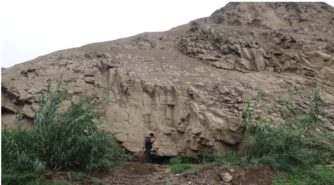
Fotografía 34. Rocas andesitas fracturadas y meteorizadas correspondiente al Grupo Quilmaná. La litología está asociada a caída de rocas, escombros en las laderas.
