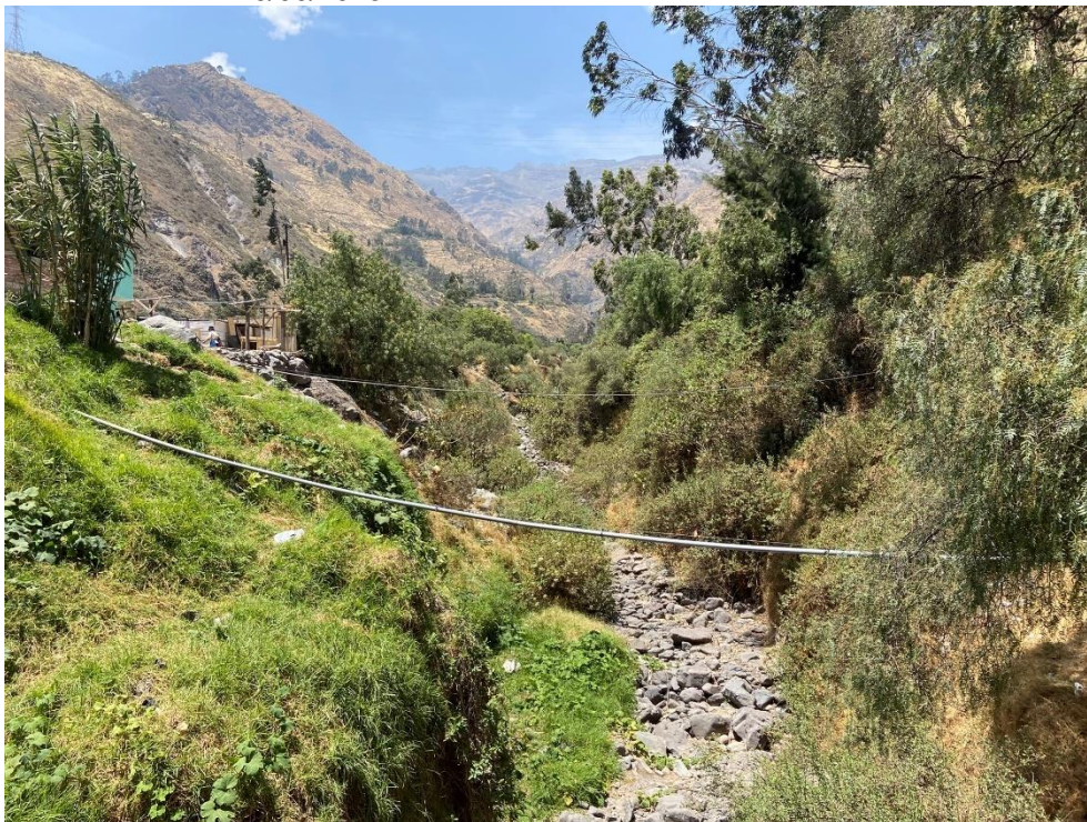
Fotografía 364. Zona crítica 15-265. Peligro por flujo de detritos en el sector Monterrico, quebrada Chucumayo, distrito Matucana. Coordenadas UTM 348621E/8689801N, zona 18S. Tomado el 11/09/2023.
