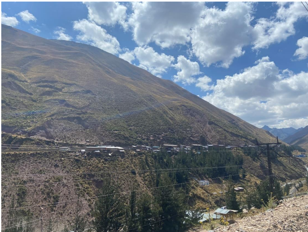
Fotografía 363. Zona crítica 15-263. Peligro por deslizamiento y derrumbes en la parte alta del poblado de Casapalca, distrito Chicla. Coordenadas UTM 365676E/8712230N, zona 18S. Tomado el 10/09/2023.
