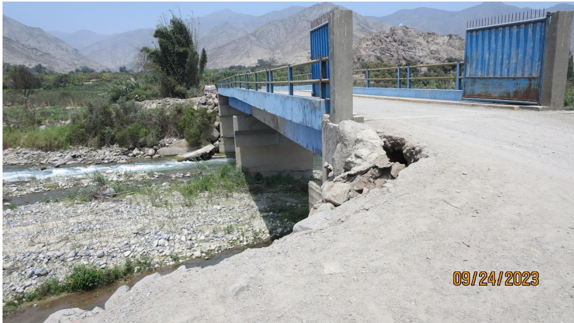
Fotografía 332. La vista tomada en dirección sureste nos muestra una imagen del puente Saume, es propenso a experimentar procesos geológicos como erosión fluvial, durante periodo de lluvias intensas afectaría el escribo del puente. Las coordenadas UTM correspondientes son 8735776 al norte y 272922 al este.
