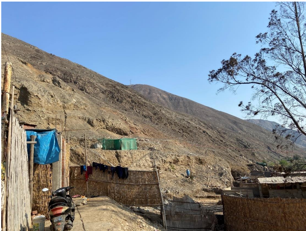
Fotografía 356. Zona crítica 15-246. Viviendas asentadas en el cauce de la quebrada Huanaco, Pacarán. Coordenadas UTM 383772E/8575293N, zona 18S. Tomado el 28/08/2023.
