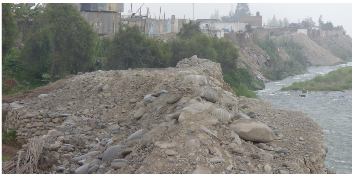
Fotografía 20. Depósitos antropogénicos en la margen izquierda del río Rímac, sobre el desmonte se han asentado viviendas que se encuentran en peligros por erosión fluvial, ubicado aguas abajo del puente peatonal Carapongo en el distrito de Ate.
