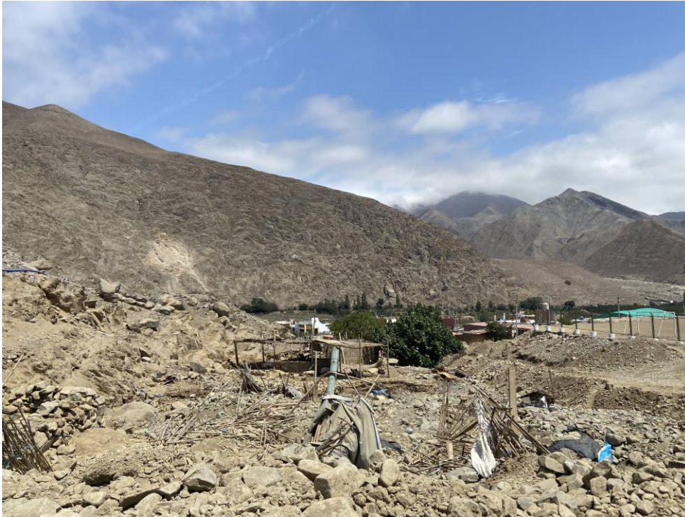
Fotografía 349. Zona crítica 15-227. Quebrada La Vuelta semi-colmatada, propensa a flujos de detritos que podrían afectar a la localidad homónima y restos arqueológicos de la La Vuelta-Yuncavirí, distrito Calango. Coordenadas UTM 337825E/8615018N, zona 18S. Tomado el 04/09/2023.
