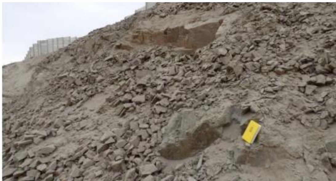
Fotografía 35. Andesitas muy fracturadas de la Formación Chilca ubicadas en la margen derecha de la quebrada Malanche en el distrito de Punta Hermosa.
