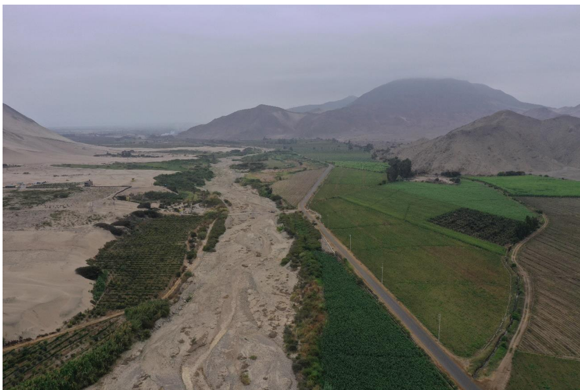
Fotografía 311. Imagen tomada con Drone, se observa el Río Supe y por la margen derecha se trazó la carretera km 13+000 Supe – Caraz, se observa que en periodo de lluvias intensas es afectado por erosión fluvial, inundación y afecta tramo de carretera también terrenos de cultivo. Coordenadas UTM: 8798845 norte y 217798 este.
