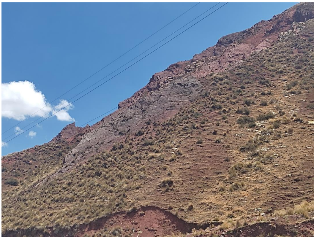
Fotografía 47. Afloramiento de la Fm. Casapalca compuesto por lutitas y limolitas de color rojizo, sector del KM122+00 – KM129+00 de la Carretera Central donde se observan constantes derrumbes.
