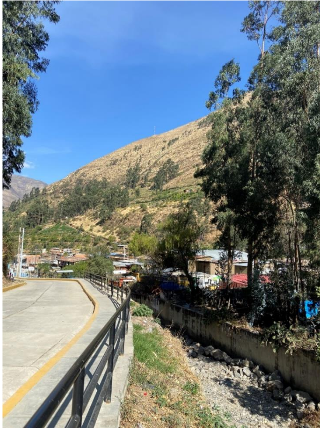
Fotografía 372. Zona crítica 15-282. Peligro por inundación y erosión fluvial por acción del río Yauyos, distrito Yauyos. Coordenadas UTM 400130E/8622431N, zona 18S. Tomado el 25/08/2023.
