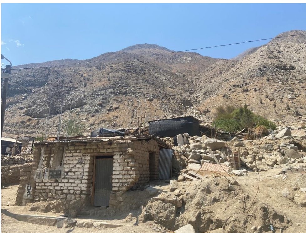
Fotografía 377. Zona crítica 15-290. Peligro por caída de rocas, erosión de laderas y flujos de detritos por quebrada seca que afecta al sector Huayllampi, Caca, Coordenadas UTM 402384E/8583511N, zona 18S. Tomado el 28/08/2023.
