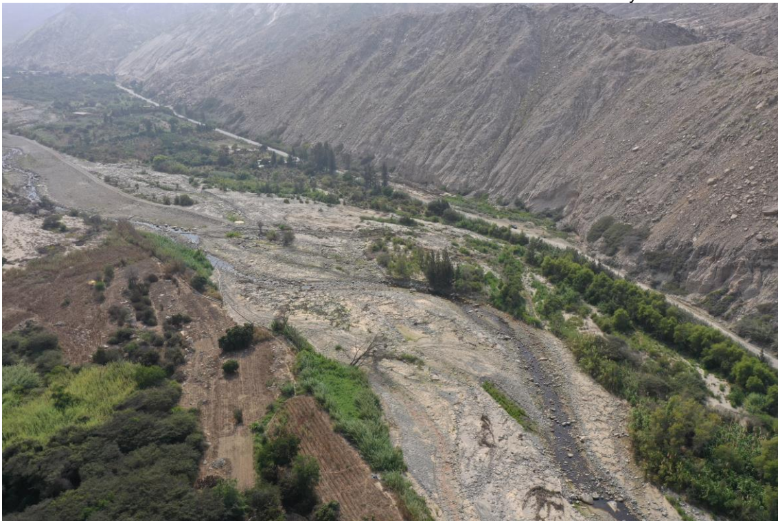
Fotografía 299. Tramo Km 42+460 Barranca - Malvados, es afectado por erosión e inundación fluvial, afecta viviendas que se encuentra situados cerca al cauce de río, también afecta carretera y puente de acceso al centro poblado Malvado. Coordenadas UTM: 8854236 norte y 210385 este.
