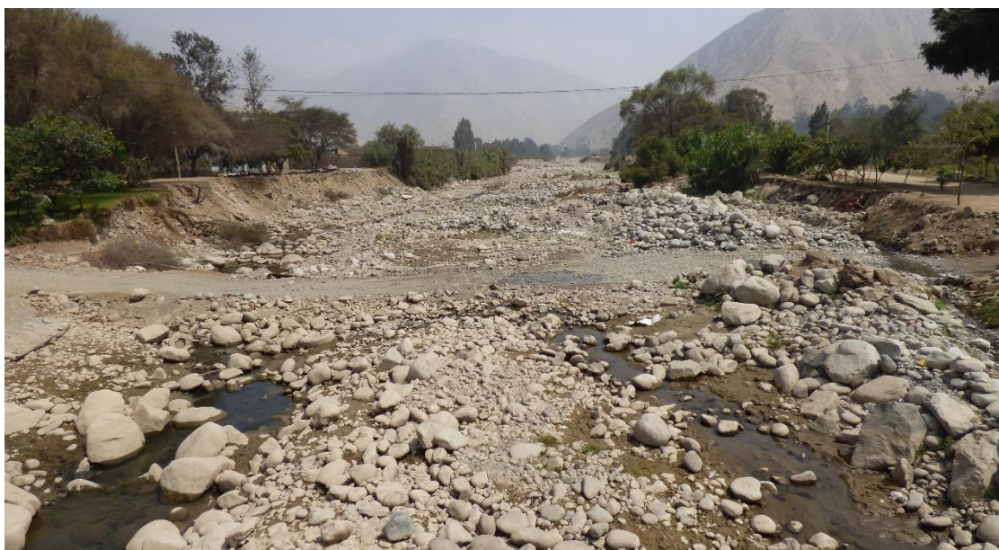
Fotografía 91. Llanura o planicie inundable en el área sujeta a inundación en ambas márgenes del río Rímac en el sector el Rancharito, en este sector las laderas sufren procesos de erosión fluvial durante épocas de crecidas y se observa colmatación del cauce. Distrito Cieneguilla.
