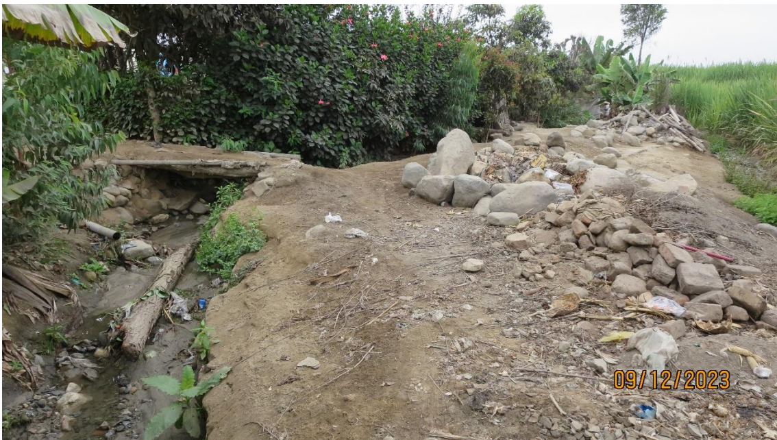
Fotografía 309. Vista tomado con dirección norte, se observa el sector San Miguel de Otopongo, se ubica en un área donde ocurren flujo de detritos, que afectaría viviendas y tramo de carretera. Coordenadas UTM: 8824413 norte y 205778 este.
