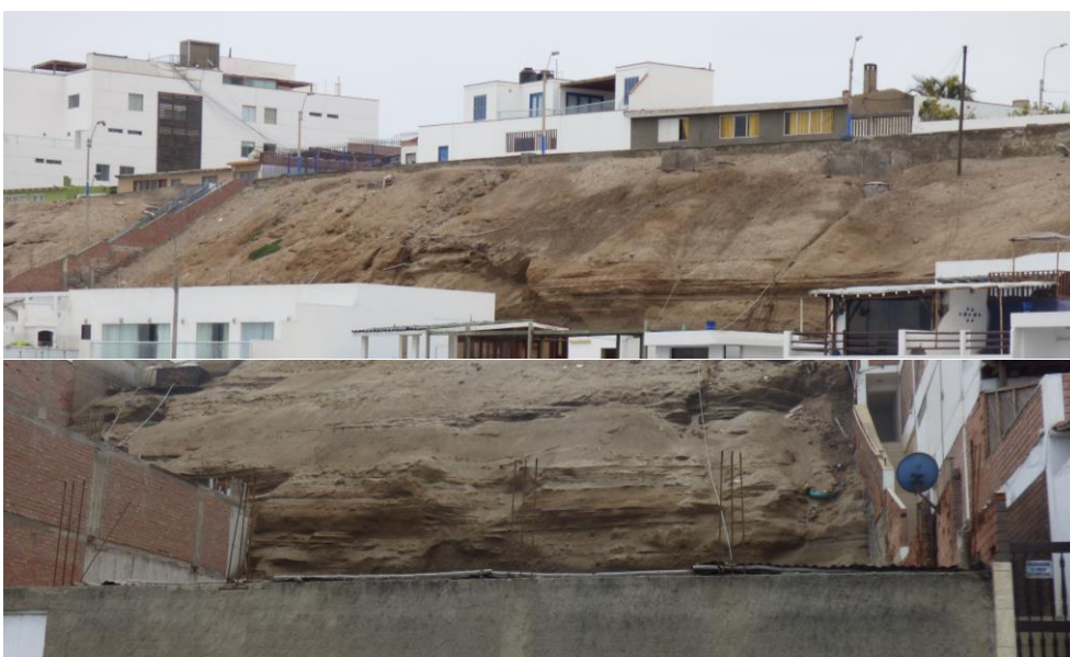
Fotografía 18. En las fotografías se tienen depósitos marinos de limo y arenas, se observan estratos semi-horizontales paralelos delante de las cuales se han construido viviendas ubicadas frente a Playa Norte en el distrito de San Bartolo.
