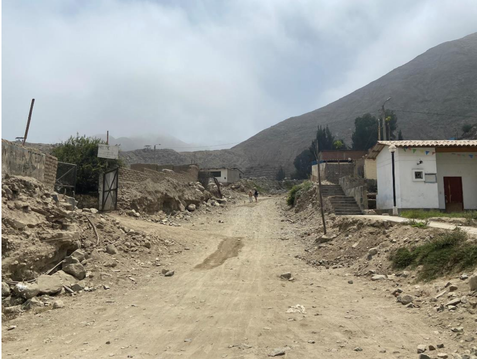
Fotografía 359. Zona crítica 15-255. Peligro por flujo de detritos en la quebrada Balconcillo de Aviyay que afectaría a la localidad de Nieve Nieve y la Carretera Cieneguilla-Huarochiri, distrito Antioquia. Coordenadas UTM 318157E/8670002N, zona 18S. Tomado el 09/09/2023.
