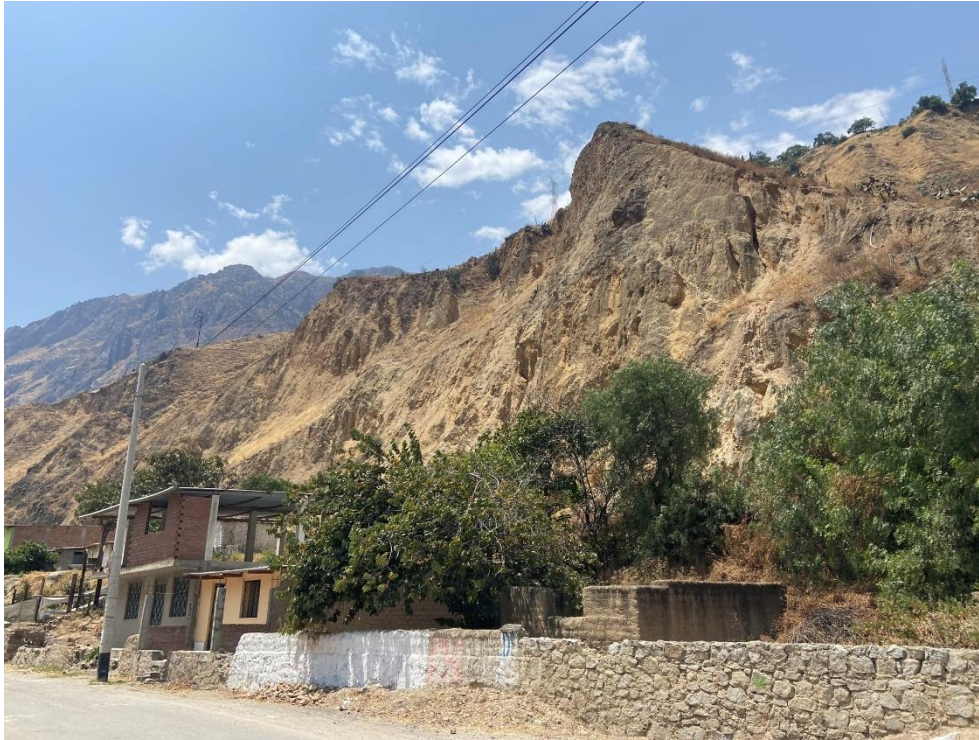
Fotografía 371. Zona crítica 15-280. Peligro por reactivación de deslizamiento y erosión de laderas en el sector Pueblo Libre, distrito Surco. Coordenadas UTM 365897E/8662599N, zona 18S. Tomado el 12/09/2023.
