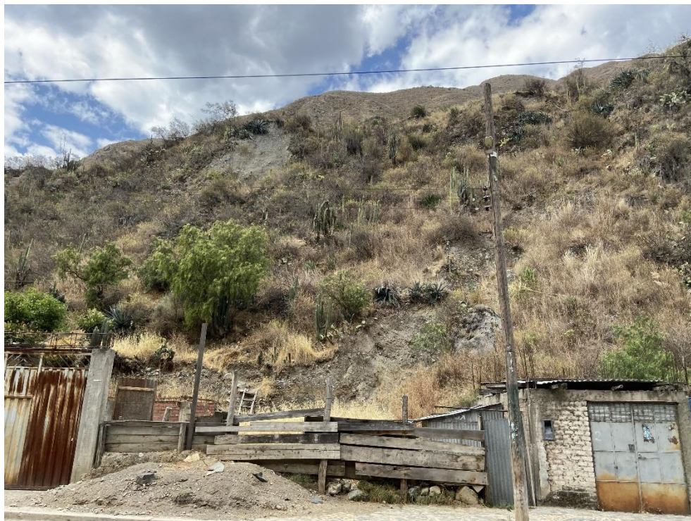
Fotografía 381. Zona crítica 15-302. El anexo de Llapay se asienta sobre el pie del deslizamiento del cerro Llishallisha propenso a sufrir reactivación y otros peligros como erosión de laderas o derrumbes en el pie. Coordenadas UTM 410015/8636967N, zona 18S. Tomado el 24/08/2023.
