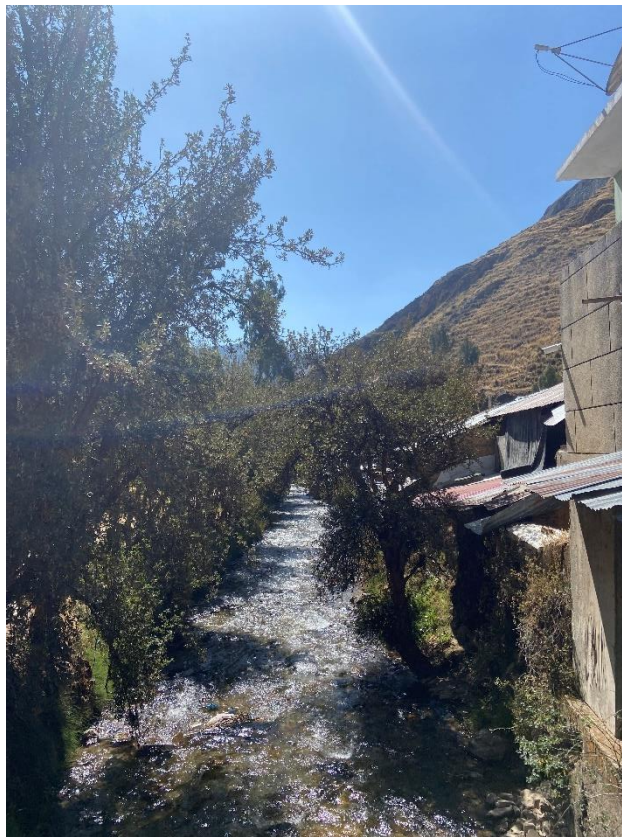
Fotografía 383. Zona crítica 15-307. Peligro por erosión fluvial por acción del río Huancachi en la terraza donde se asienta el sector homónimo, distrito Tomas. Coordenadas UTM 421974E/8645376N, zona 18S. Tomado el 22/08/2023.
