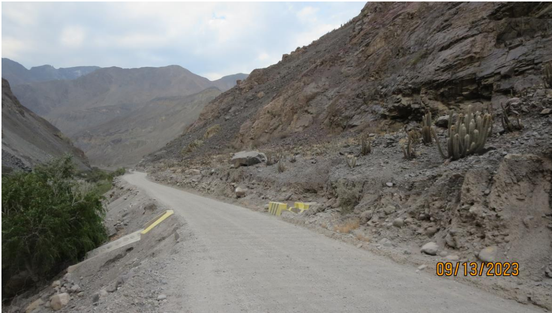
Fotografía 44. Secuencia de areniscas, lutitas y limolitas de la formación Carhuaz muy meteorizadas, margen izquierdo río Pativilca, Km. 87 carretera Pamplona-Cajatambo.
