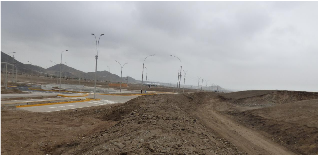
Fotografía 73. Colinas y lomadas en roca vulcano-sedimentaria ubicadas en la margen izquierda de la quebrada Lúcumo en el distrito de Lurín. Sector Macrópolis etapa 3, Condominio Industrial Macrópolis.
