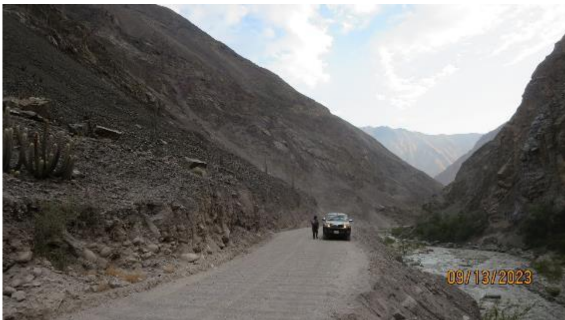
Fotografía 319. Captura de imagen tomada con dirección oeste, se observa a la margen izquierda la carretera que conecta Pamplona – Cajatambo, el tramo Km 94+000 es afectado por procesos geológicos como caída de rocas derrumbes y flujos de detritos, también es afectado por erosión fluvial. En periodo de lluvias intensas afecta vía asfaltada que deja aislado los centros poblados. Las coordenadas UTM corresponden a: 8841447 al norte y 263385 al este
