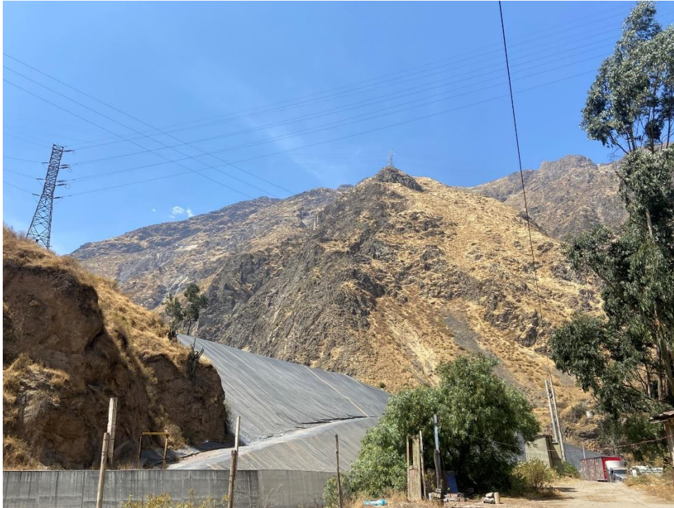
Fotografía 367. Zona crítica 15-273. Peligro por deslizamiento y flujo de detritos que acarrearían el depósito de relaves en el sector Tamboraque, distrito San Mateo. Coordenadas UTM 357481E/8697212N, zona 18S. Tomado el 11/09/2023.
