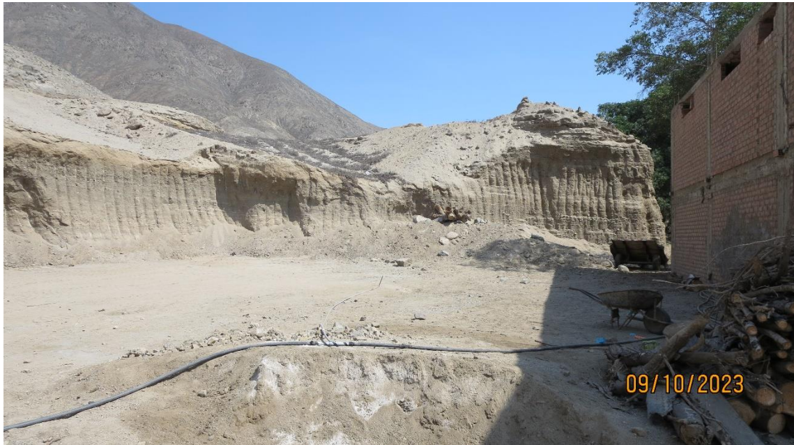
Fotografía 298. Sector Monte Grande, Paramonga, Barranca, se observa que se asientan viviendas para el cual realizaron corte de talud y en periodo de lluvia intensas o lluvias prolongadas se generan flujos que afectan las viviendas y tramo de carretera asfaltada. Coordenadas UTM: 8842596 al norte y 200833 al este.
