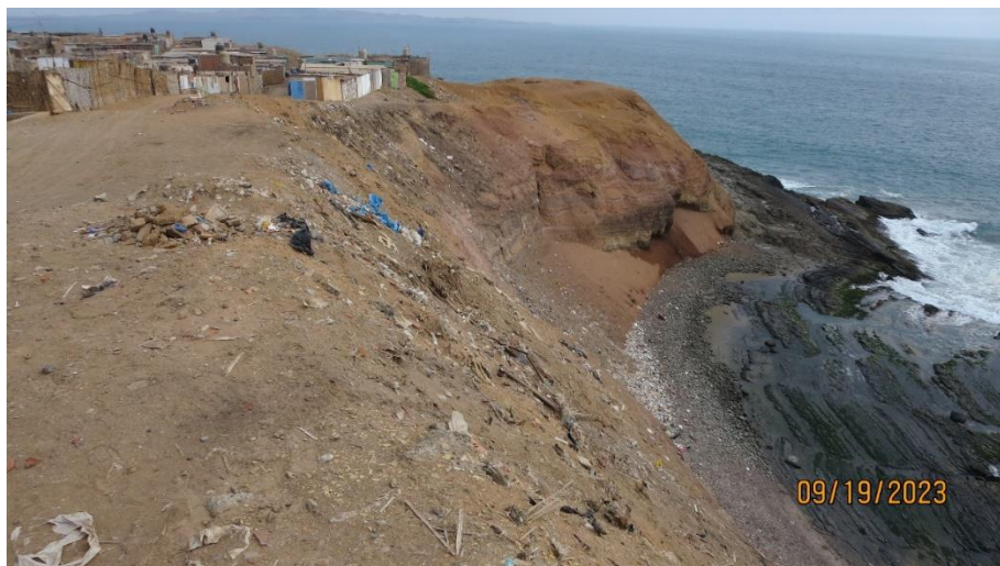
Fotografía 106. Relleno artificial sobre acantilado, sector El Tauca, AAHH. Atalaya y Manzanares, distrito Santa María - Huaura
