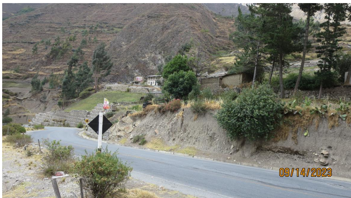
Fotografía 344. La vista, tomada en dirección noroeste, nos muestra una imagen de las viviendas en la zona de Viroc y el tramo de la carretera Sayán - Churín. Este lugar se ve afectado por una serie de procesos geológicos, incluyendo deslizamientos, erosión fluvial e inundaciones. Actualmente, en la zona se pueden observar grietas tanto en el terreno como en la carretera asfaltada. Estos eventos podrían agravarse durante períodos de lluvias intensas o en caso de movimientos sísmicos, lo que representaría un riesgo para las viviendas ubicadas dentro de la zona afectada o en sus proximidades, así como para la carretera Sayán - Churín. Las coordenadas UTM correspondientes son 8818287 al norte y 303523 al este.
