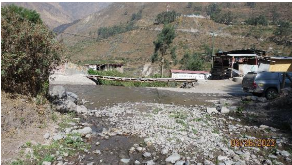
Fotografía 321. La captura, tomada en dirección noroeste nos muestra una imagen de la parte baja de la quebrada Portura, esta área se vuelve susceptible a una serie de procesos geológicos, incluyendo flujos de detritos, erosión de ladera. Estos procesos tienen el potencial de causar daños a viviendas y vías de acceso. Las coordenadas UTM asociadas son 8733241 al norte y 323242 al este.
