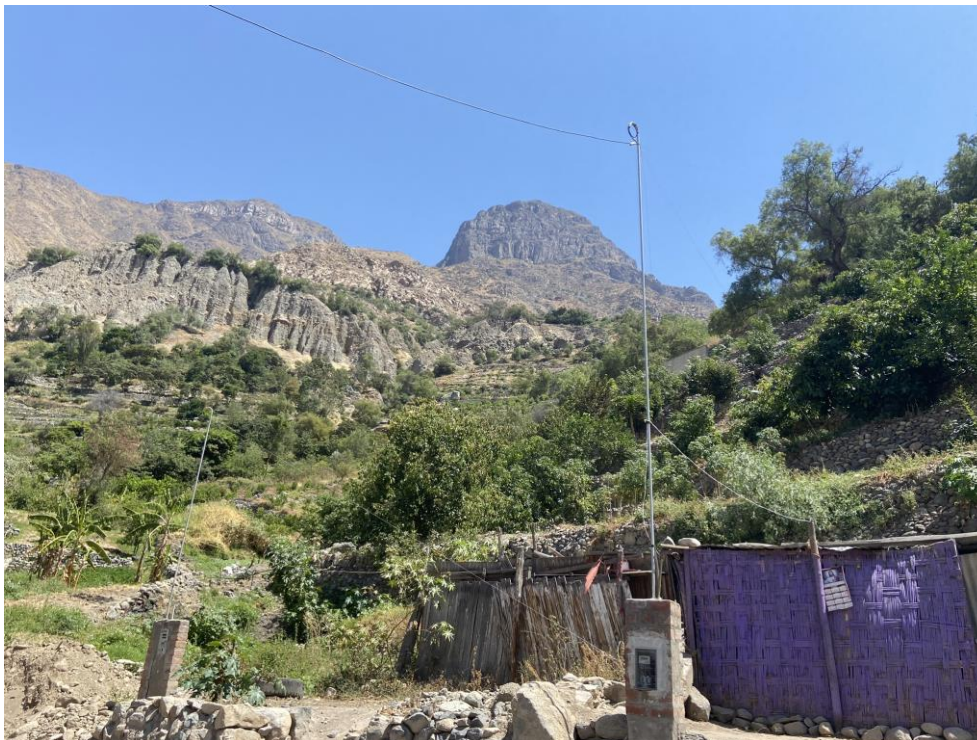
Fotografía 376. Zona crítica 15-287. El sector de Calachota se asienta sobre depósitos aluviales de la quebrada Aucampi, por lo que está expuesto a flujos de detritos y erosión de laderas. Coordenadas UTM 393016E/8603414N, zona 18S. Tomado el 26/08/2023.
