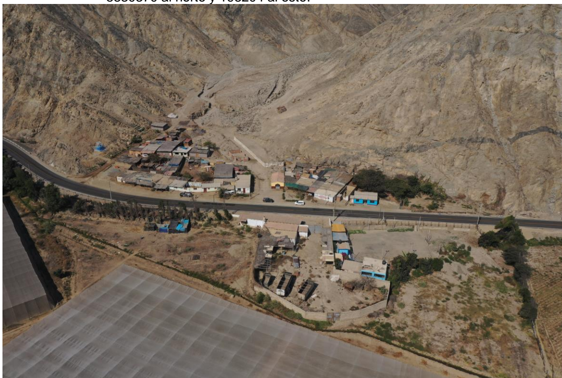
Fotografía 305. La imagen, capturada mediante un dron, nos muestra el centro poblado de Sauce Grande, situado en la desembocadura de la quebrada con el mismo nombre. Esta área se ve afectada por flujos de detritos que se originan en la quebrada, causando daños a viviendas y a un tramo de la carretera que conecta Barranca con Chasquitambo. Las coordenadas UTM corresponden a 8845440 al norte y 201478 al este.
