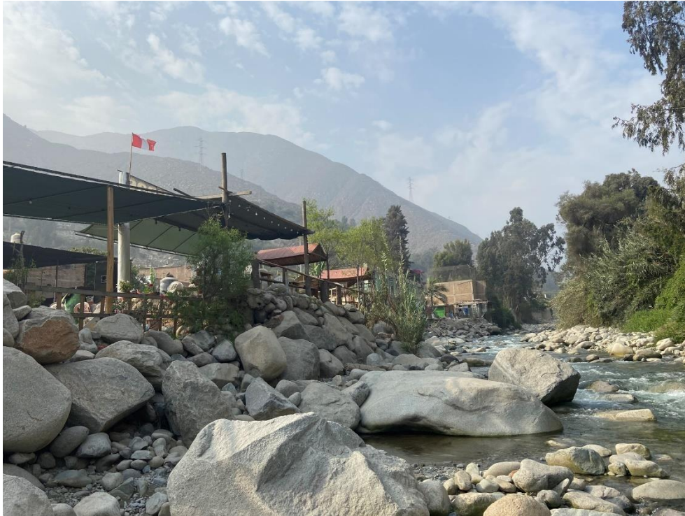
Fotografía 369. Zona crítica 15-276. Peligro por erosión e inundación fluvial por acción del río Rimac, sector del distrito de Santa Eulalia. Coordenadas UTM 318937E/8683956N, zona 18S. Tomado el 12/09/2023.
