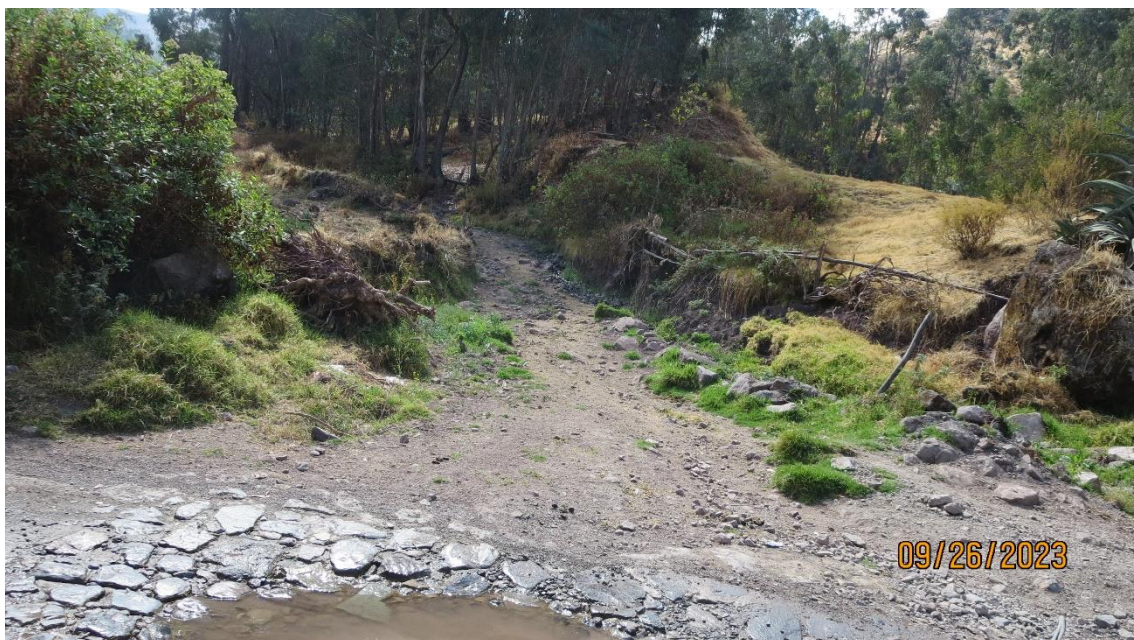
Fotografía 323. La captura, tomada en dirección noreste, nos ofrece una vista de la quebrada Acomayo. Durante períodos de lluvias intensas, esta área se vuelve susceptible a una serie de procesos geológicos, incluyendo flujos de detritos, y derrumbes. Además, las laderas y quebradas circundantes son propensas a deslizamientos y flujos. Estos procesos tienen el potencial de causar daños a viviendas, v las de acceso, puentes peatonales y terrenos de cultivo en el sector. Las coordenadas UTM asociadas son 8729036a y norte y 322903 al este.
