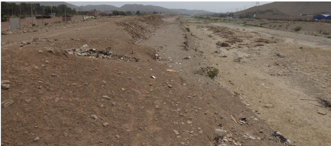
Fotografía 96. Terrazas en ambas márgenes del río Chillón, sobre estas se han arrojado desmonte para incrementar la altura de la terraza y crear una barrera protectora ante crecidas. Sector de Lomas de Chillón en el distrito de San Martín de Porres.
