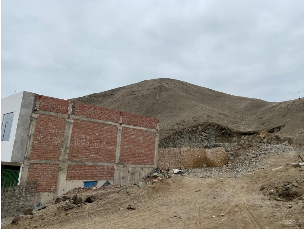
Fotografía 355. Zona crítica 15-243. Peligro por flujo de lodo y derrumbes en el anexo San Juan, Mala. Coordenadas UTM 324107E/8600996N, zona 18S. Tomado el 03/09/2023.
