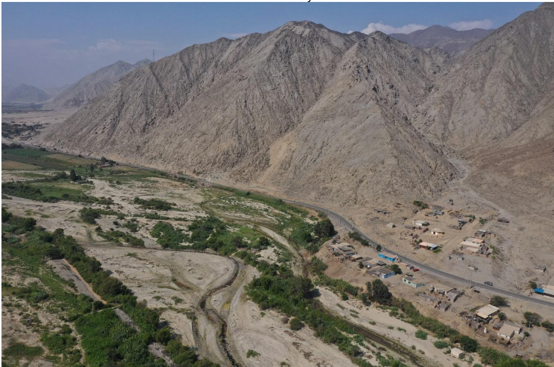
Fotografía 303. La imagen capturada con dron, se observa el centro poblado Hoya Chica ubicado en la desembocadura de una quebrada, que en periodo de lluvias intensas se activan llegando a generar flujos de detritos que podrían ocasionar daños a las viviendas, vía asfaltada que conecta los poblados también es afectado por erosión fluvial, las coordenadas UTM, corresponden a 8836535 al norte y 198278 al este.
