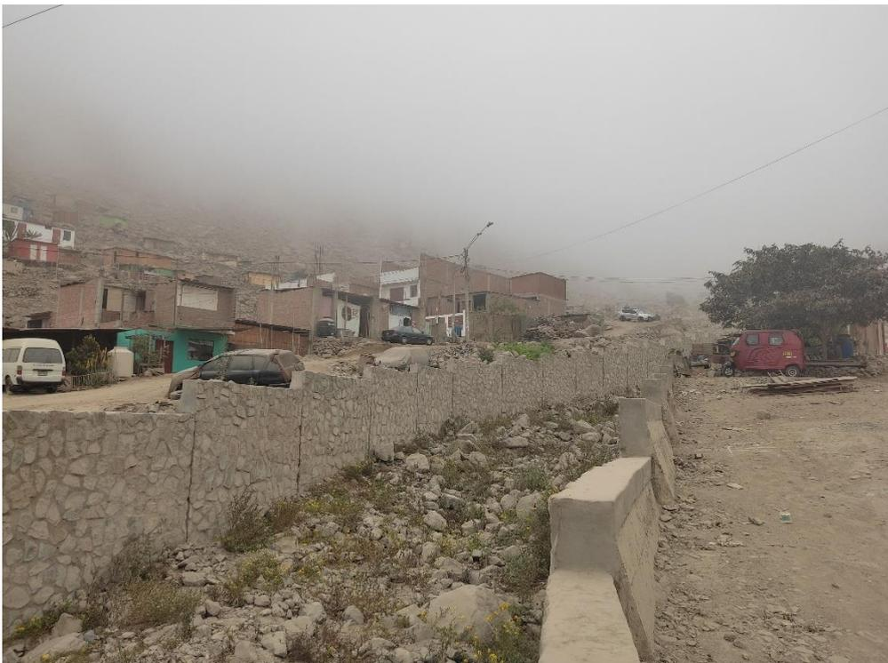
**Fotografía 134.** Zona crítica 15-039. Muros laterales en la quebrada Chacrasana, cauce colmatado. Coordenadas UTM 18S E309711; N8678061 (tomada el 20/09/2023).
