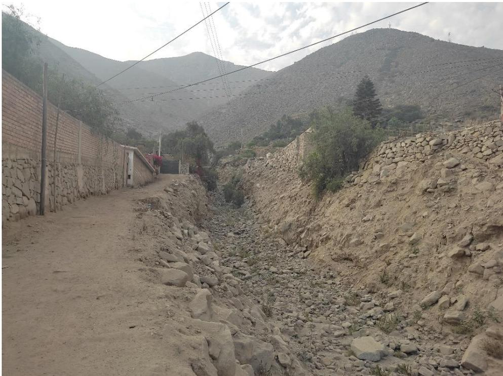
**Fotografía 153.** Zona crítica 15-046. Cauce colmatado de la quebrada Corrales, viviendas se encuentran cerca del cauce no cuenta con defensa ribereña. Coordenadas UTM 18S E316952; N8681426 (tomada el 20/09/2023).
