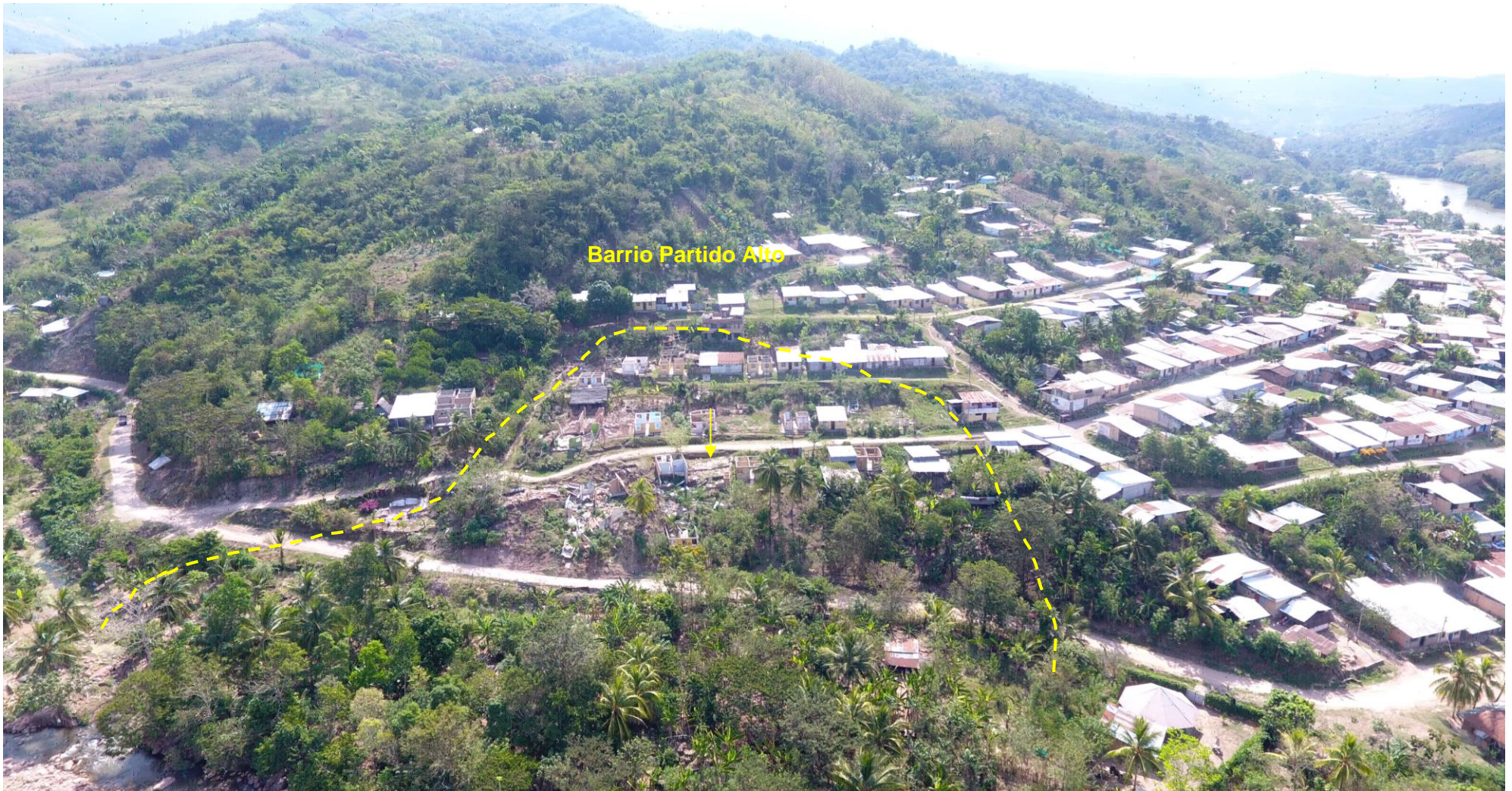
Figura 19: Vista del barrio Partido Alto, posterior al deslizamiento de suelos.
