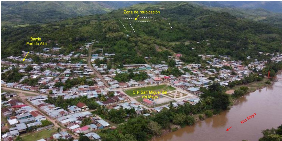
Figura 25. Vista general de la zona de reubicación.
