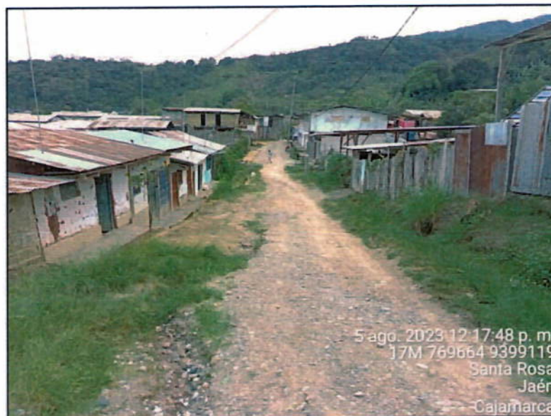
CARCAVAS GENERADAS POR ESCORRENTÍA SUPERFICIAL EN EPOCA DE PRECIPITACIONES EN TERRAZA INCLINADA SITUADA EN EXTREMO NORTE DE SANTA ROSA
