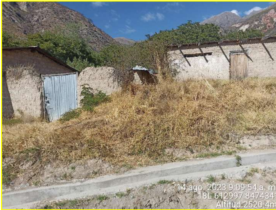
Fotografía N° 09: Vista de viviendas y sistema de canal de riego, dentro del área expuesta al peligro.
