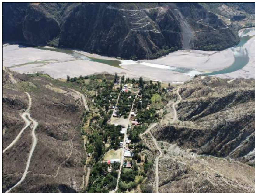
Figura 01. Imagen de viviendas expuestas margen derecha
