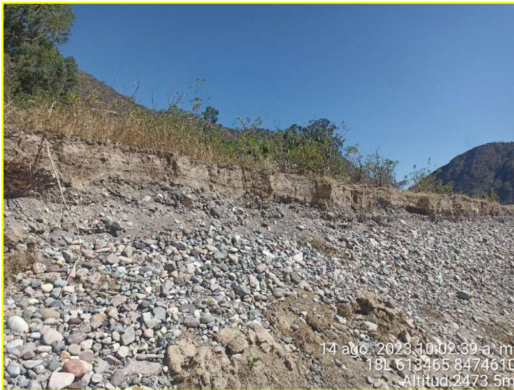
Fotografía N° 03: Vista hacia el oeste tramo medio del río Pampas dentro del área EVAR, sectores susceptibles a ser socavado por el paso del río Pampas.
