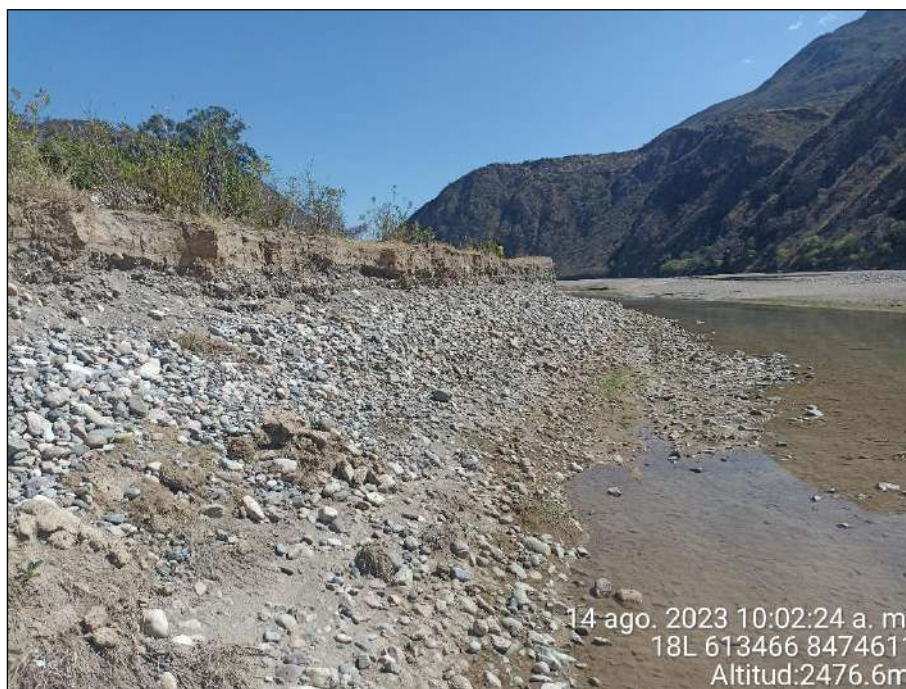
Fuente: Equipo técnico; altura de flujo es de 2.5 m
