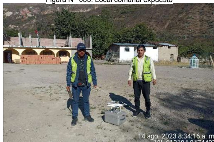
Figura N° 035. Local comunal expuesto
