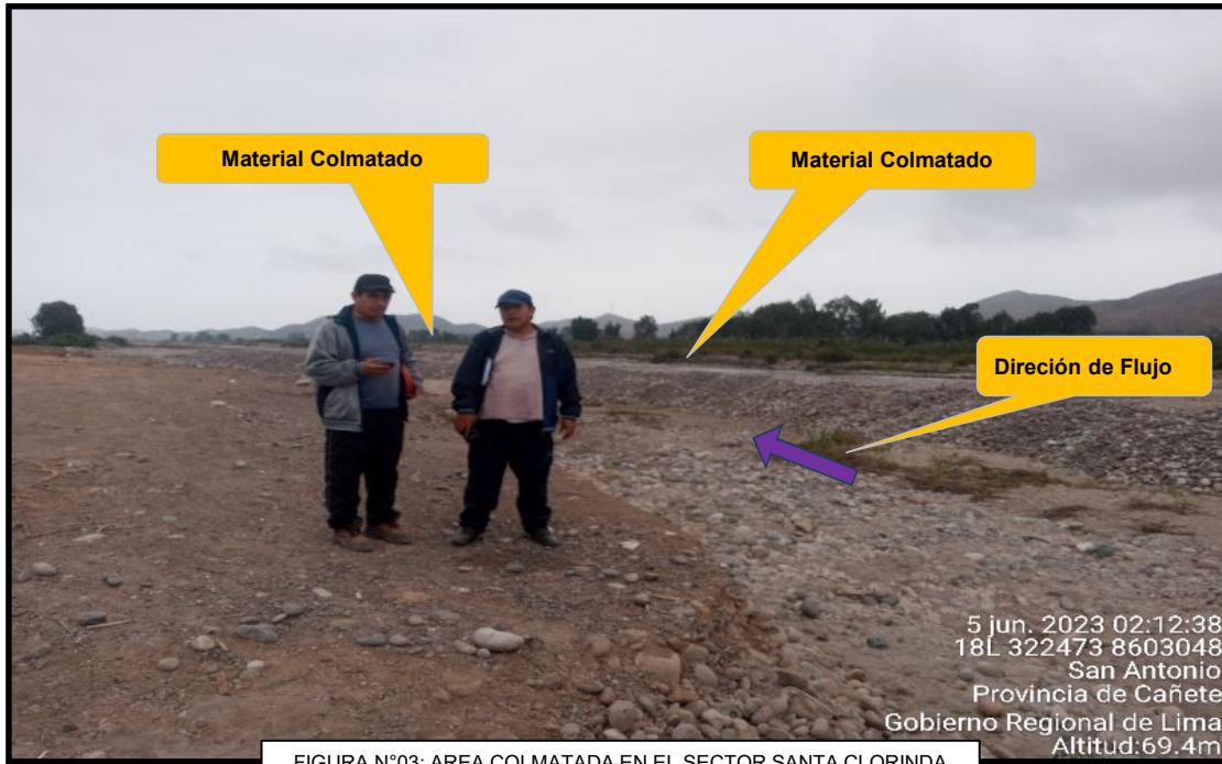
FIGURA N°03: AREA COLMATADA EN EL SECTOR SANTA CLORINDA
