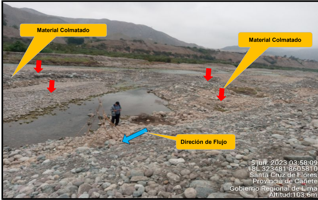
FIGURA N°03: MARGEN DERECHO E IZQUIERDO COLMATADO, EN EL SECTOR SAN JOSE DEL MONTE
