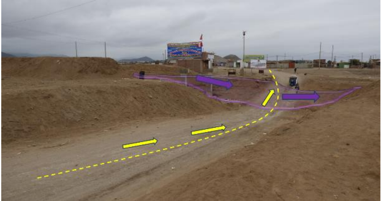
Figura 10. Asociación Nueva Punta Hermosa (ex Villa Navarra), ubicado en la margen izquierda de la quebrada Malanche, se observa el cauce del flujo y la vía alterna, a traviesa el cauce disminuyendo su ancho y altura
