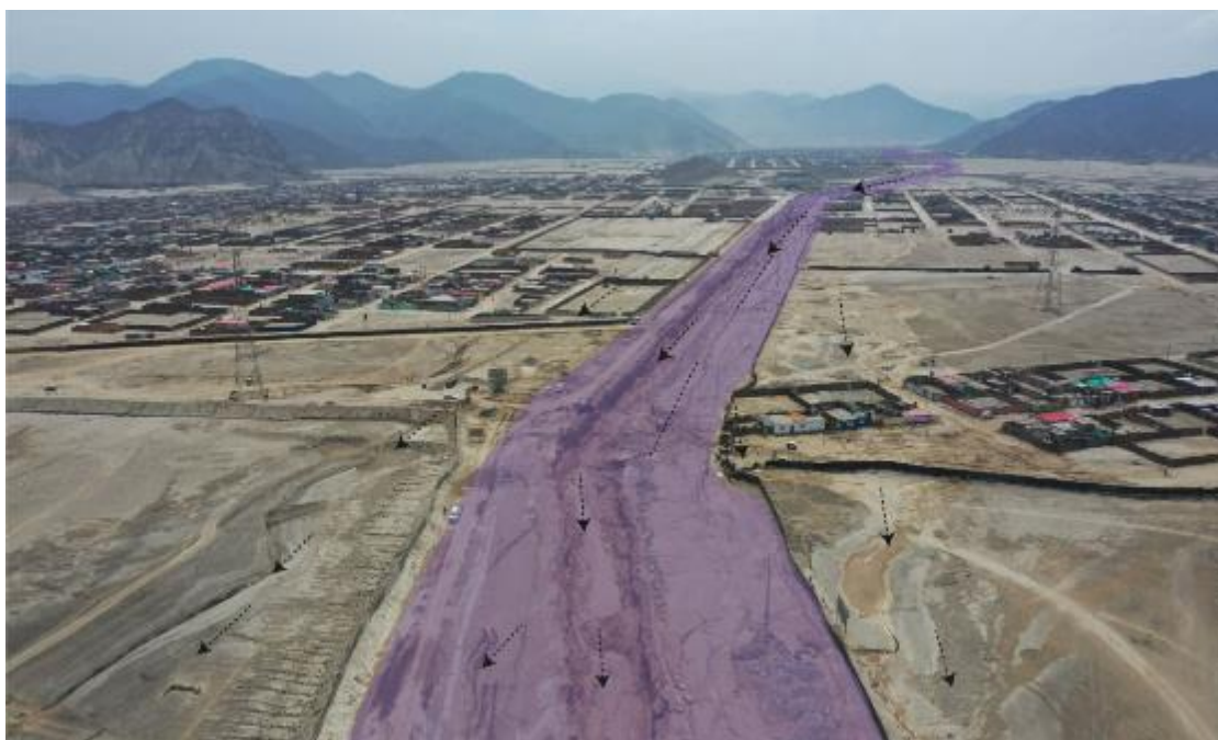
Figura 12. Recorrido del flujo de lodo desde la parte alta de la quebrada Malanche y su paso por los centros poblados Pampapacta y Santa Rosa. Imagen tomada por dron (2017).
