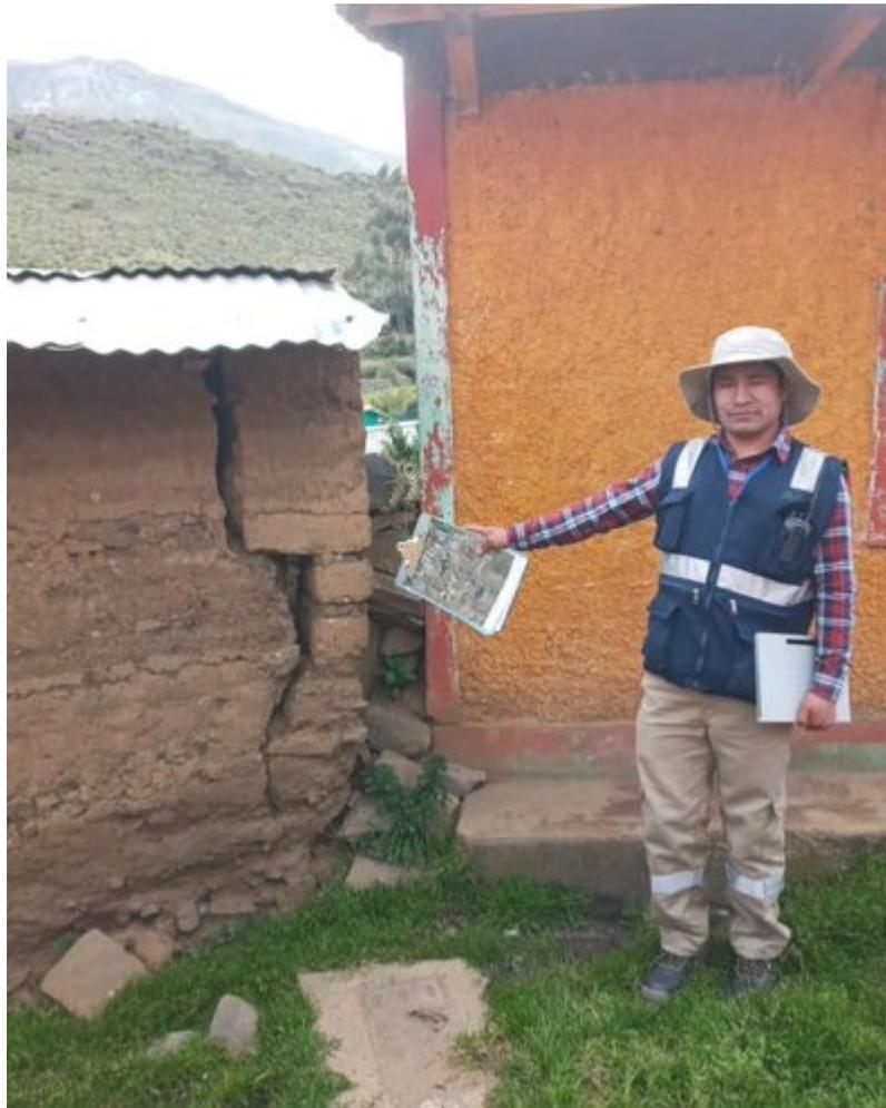
**Foto 10.** Vista de fisuras en viviendas por construcciones precarias en terrazas y montaña estructural en roca sedimentaria un canal de riego en el sector de Suyán, ubicado en depósitos coluviales. (265456E, 8891491.7N)
