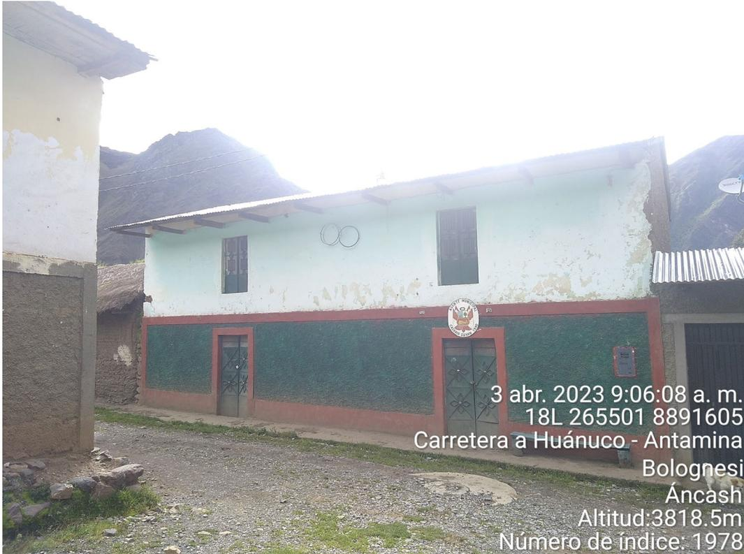
**Fotografía 9.** Local comunal del Caserío Suyan. Se observa una construcción de techo de calamina, pared de tapial, tarrajado con yeso la parte delantera de la fachada se encuentra aproximadamente a 40 metros de la plaza principal del Caserío
