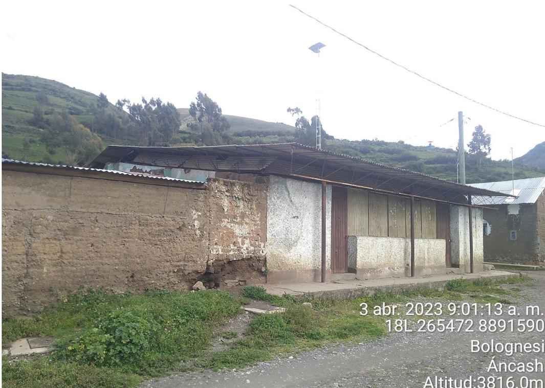
**Fotografía 10.** Concejo Municipal del Caserío Suyan, ubicado a 70 metros NO aproximadamente en referencia a la plaza central del caserío. Se observa una construcción en malas condiciones con techo de calamina
