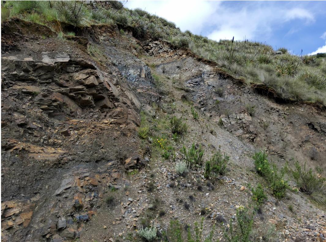
**Foto 3.** Vista de una caída de detritos y caída de rocas activo en laderas moderadamente empinadas en el sector de Suyán (265031E, 8891930.68N)
