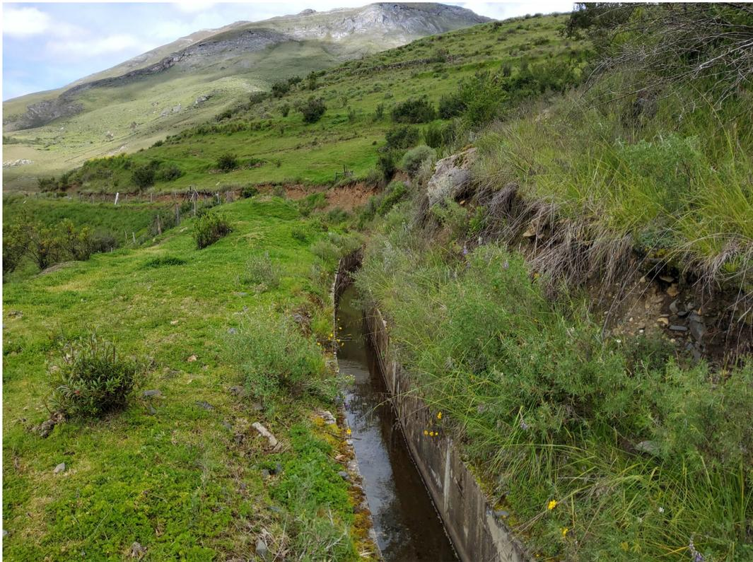
**Foto 33.** Vista de canal de riego abierto rectangular en laderas moderadamente empinadas del sector de Suyán. (GEO-WV-073,265121E,8891802N,3957msnm)
