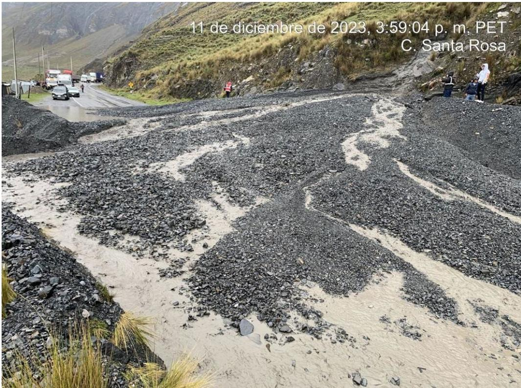
**Fotografía13.** Vista depósitos aluviales al flanco izquierdo del río Pativilca en la parte baja de la ladera (264399 E, 8884974 N).
