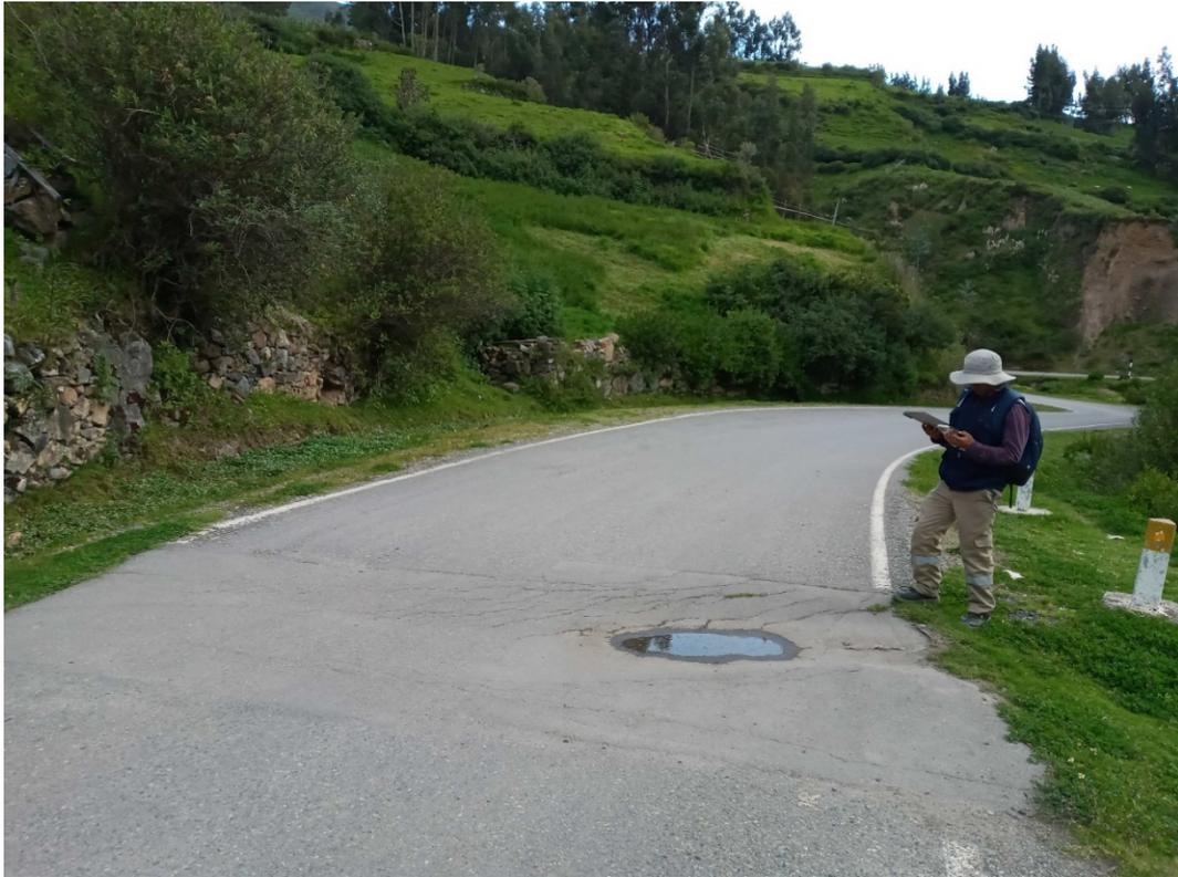
**Fotografía4.** Vista de agrietamiento en vía con dirección N57° en vertiente o piedemonte coluvio deluvial del sector de Aquia Cruz (264235 E, 8884137 N).
