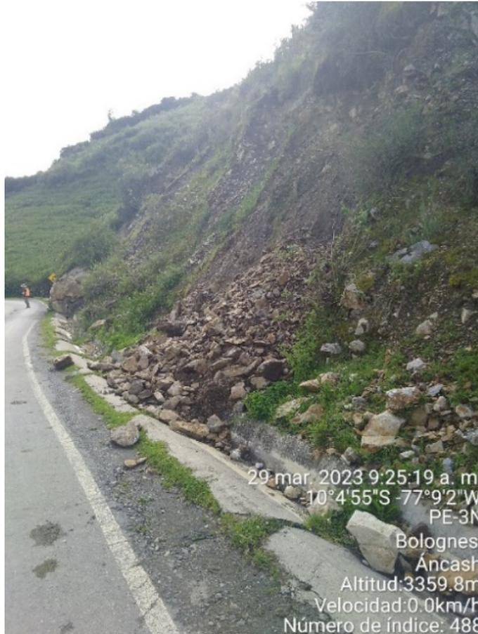
**Fotografia1.** Vista de la carretera que se ve obstruida por el desprendimiento del talud que arrastra rocas y tierra.
