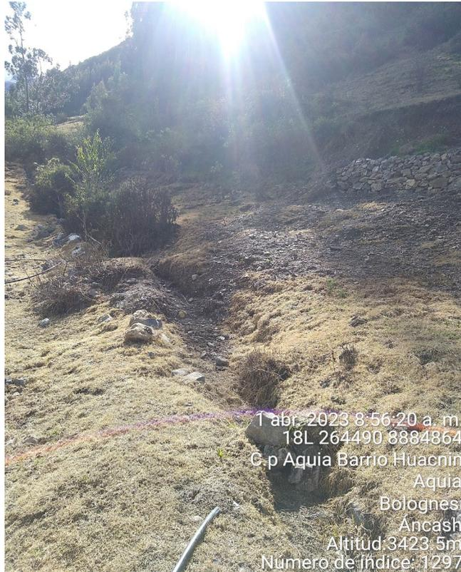
**Fotografia2.** Canal de riego sin revestir y obstruido por material suelto
