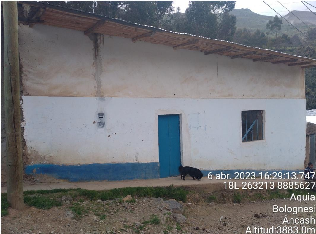
**Fotografía 8.** Local comunal del Caserío de Villanueva. Se observa una construcción de techo de calamina, pared de tapial, tarrajado con yeso la parte delantera de la fachada se visualiza del lado izquierdo humedad debido a la precipitación y deterioro por la antigüedad de construcción.
