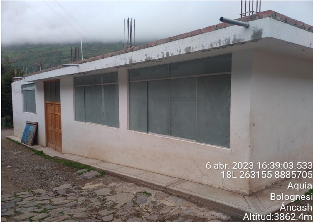
**Fotografía9.** Concejo Municipal del Caserío Villanueva. Está conformado por columna paredes y techo de material de concreto. Asimismo, la fachada presenta pérdida del revestimiento de pintura en paredes por efectos de la humedad capilar.
