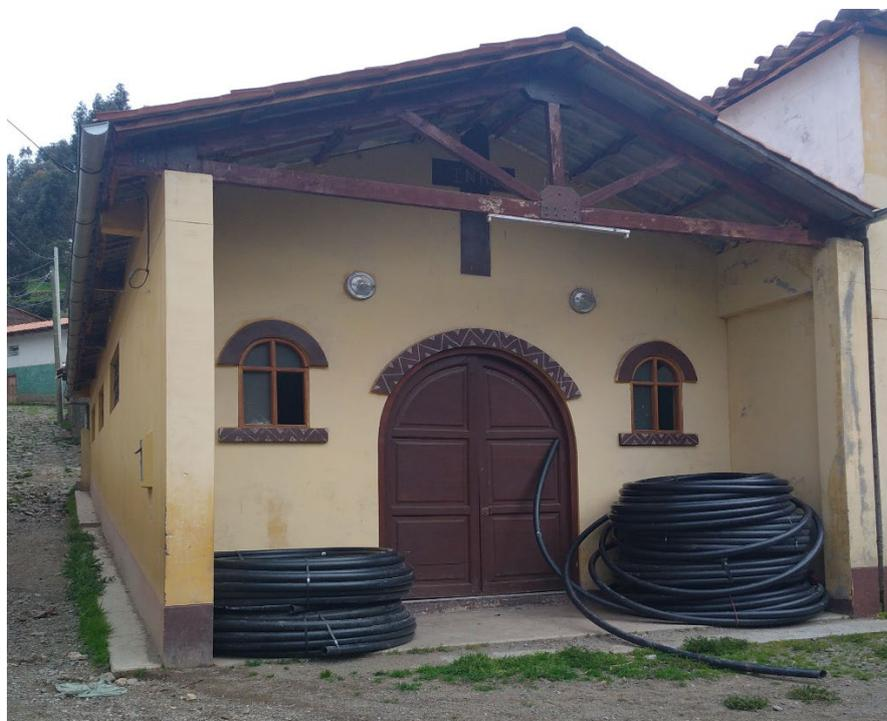
**Fotografía6.** Iglesia Católica del Caserío Villanueva. Formado por paredes de adobe revestidas de yeso y soporte de madera y tejas. Asimismo, desde la fachada se visualiza manchas de humedad debido a que se encuentra a la intemperie de la precipitación.
