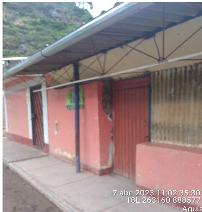
**Fotografía 4.** Vista de cerca de la Institución Educativa Inicial del Caserío Villanueva. Se observa la construcción de material de adobe en paredes revestidas de yeso y techo con soporte de estructura metálica y Eternit.
