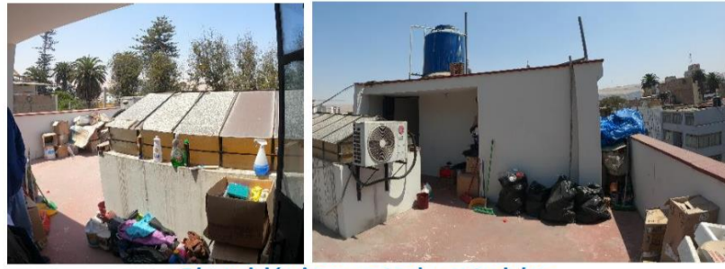
Disposición incorrecta de materiales
