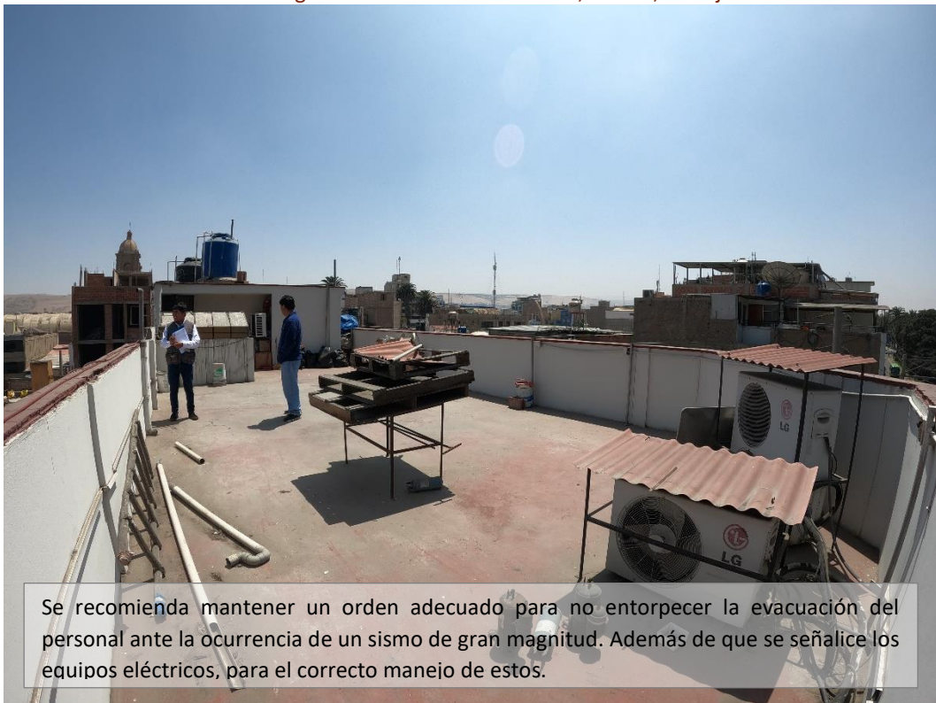
IMAGEN 12—25 : Oficina Regional del INDECOPI de Tacna, azotea, trabajos de mantenimiento
