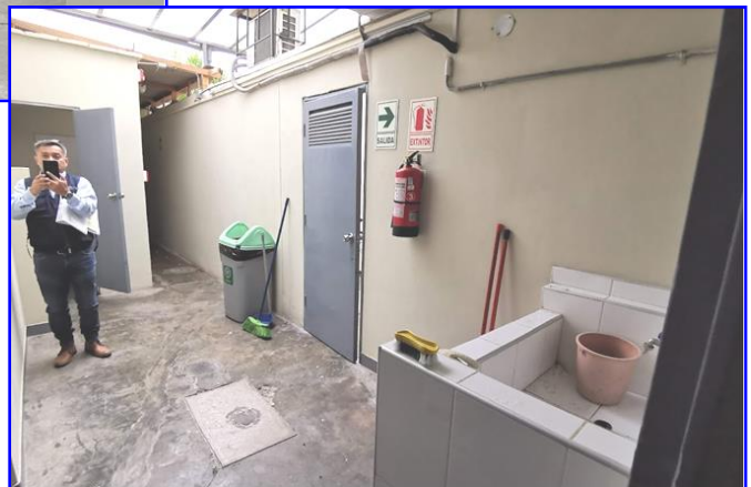
Foto arriba 7: Aquí se aprecia la configuración de parte del área libre, donde se ubica lavandería.
