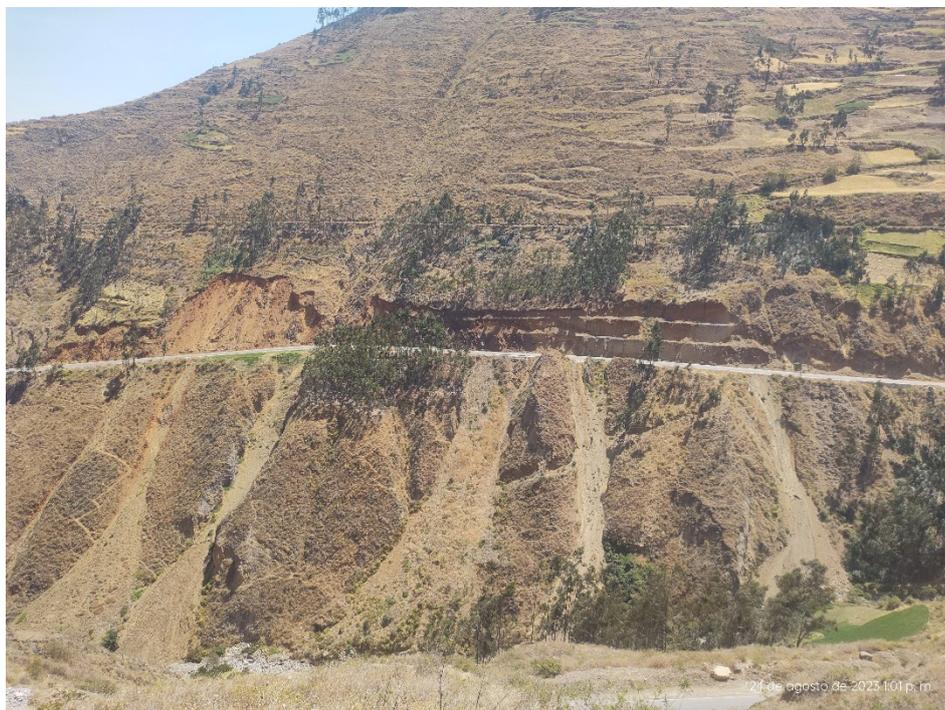
Fotografía N° 06: Deslizamiento y caída de roca en el sector Santa Rita por la vía principal Huaraz – Casma, parte alta hay viviendas.
