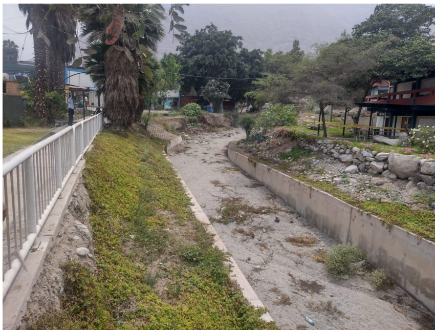
Foto N° 12: Canalización de la quebrada Santo Domingo.
