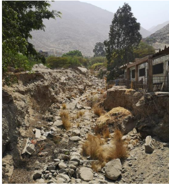
Foto N° 03: Vista de la quebrada Santo Domingo, desde el puente aguas arriba.
