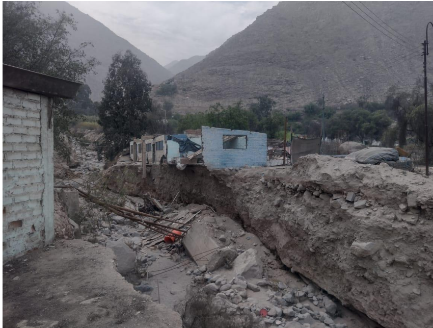
Foto N° 11: Presencia de la quebrada Santo Domingo, en la cual se visualiza los daños y efectos adversos
