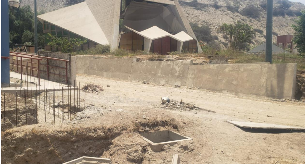
Foto N° 06: Toma fotográfica de la vía que corta la UNE, coincidente con el cauce de la quebrada Cantuta II, con presencia de muros de contención de baja altura. Actualmente, no cuenta con red de drenaje para interceptar el escurrimiento de flujos poco significativos.
