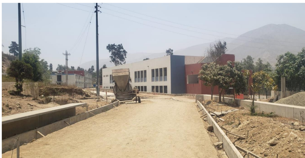
Foto N° 05: vía, actualmente afirmada, la cual es parte del cauce de la quebrada Cantuta II dentro de la UNE. Se puede apreciar que no cuenta con corte transversal cóncavo para encauzamiento del flujo en caso de activación de la quebrada
