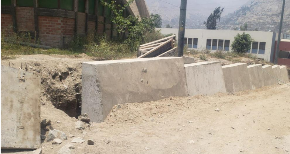
Foto N° 02: Vista de la quebrada Cantuta, se visualizan los muros de contención
